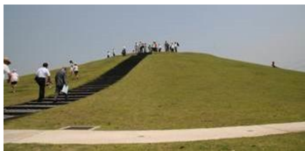
写真-3 津波避難のために整備された築山の例（神栖市 中央公園）
