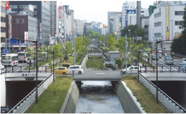
写真-1 創成川通 (札幌市提供)
