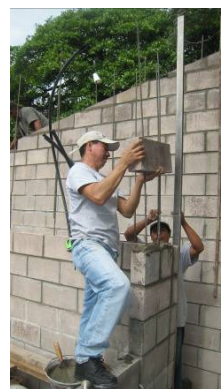
写真2 コンクリートブロック造
