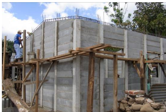
写真1 ブロックパネル造
