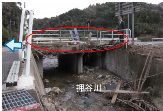
写真-2.2.42 国道191号と押谷川（12月25日調査）
