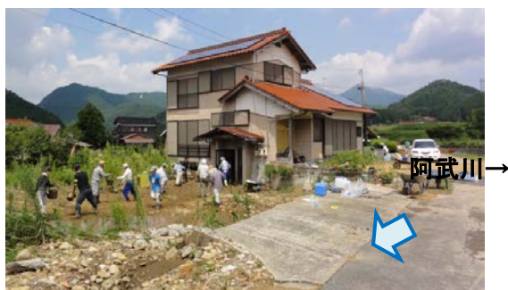
写真-2.2.7 川沿いの家屋の土砂の撤去 (損壊は見られない) (8月6日調査)
