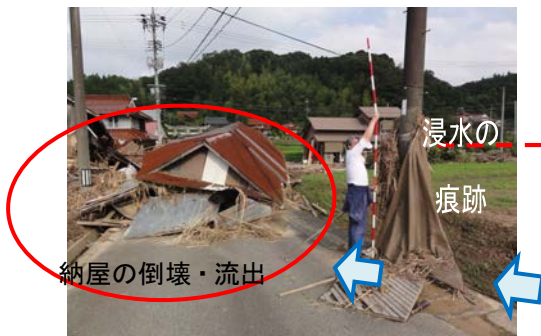
写真-2.2.23 下小川地区の納屋の倒壊・流出 (8月5日調査)
