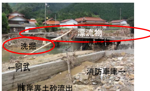
写真-2.2.4 橋梁右岸洗掘、左岸護岸裏の土砂流出（8 月 6 日調査）
