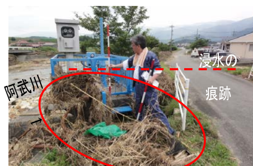
写真-2.2.5 樋管に付着した漂流物 (8月6日調査)
