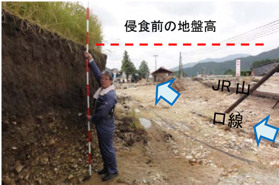
写真-2.2.11 氾濫流により約2.6m 侵食された水田 (8月6日調査)
