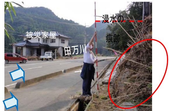
写真-2.2.28 道路脇の浸水痕跡 (8月5日調査)
