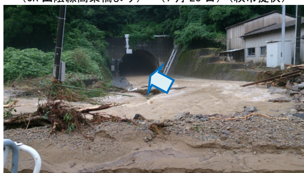
写真-2.2.44 須佐トンネルに流入する押谷川の氾濫流 （7月28日17時頃）（萩市提供）
