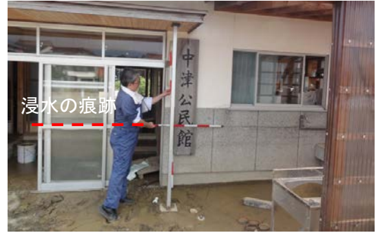
写真-2.2.39 中津公民館の浸水痕跡 (8月5日調査)
