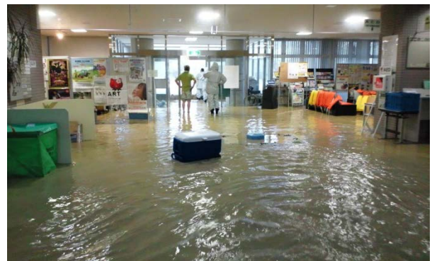
写真-2.2.34 須佐総合事務所の浸水 (7月28日12時頃) (萩市提供)
