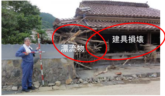
写真-2.2.38 家屋の損壊状況と漂流物 (8月5日調査)
