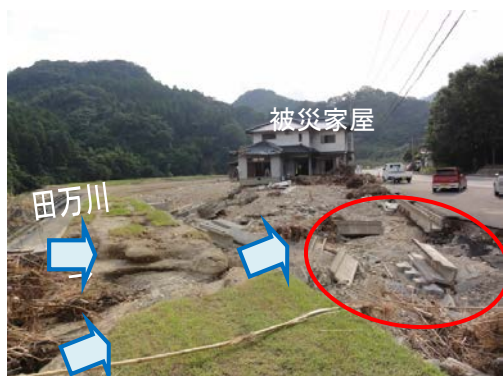
写真-2.2.27 道路側溝の散乱状況 (8月5日調査)
