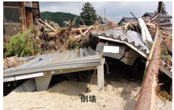
写真-2.2.14 車庫の倒壊と自動車の被害 (8月6日調査)
