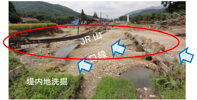
写真-2.2.10 氾濫流による線路盛土の流失 (8月6日調査)
