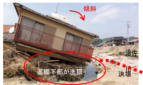
写真-2.2.37 基礎下部の洗掘により倒壊した家屋 (8月5日調査)
