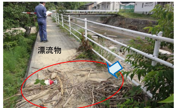
写真-2.2.30 A 橋右岸下流の堤防天端の漂流物（8月5日調査）
