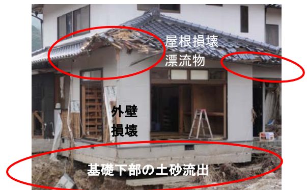
写真-2.2.26 家屋基礎下部の土砂流出 (8月5日調査)
