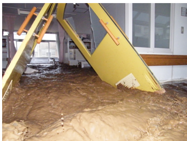
写真-2.2.18 老人ホームの浸水状況(7月28日12時頃)(萩市提供)
