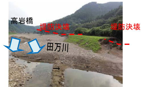
写真-2.2.22 田万川の堤防決壊箇所 (8月5日調査)
