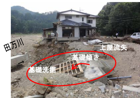
写真-2.2.25 集会所・地蔵堂の上屋流失 (8月5日調査)
