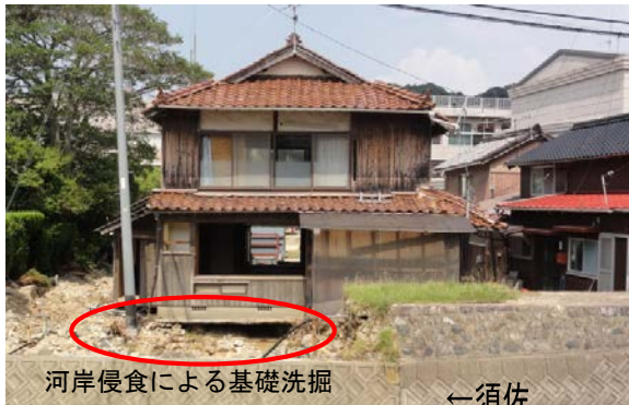
写真-2.2.33 堤防際の損壊家屋 (8月5日調査) 川
