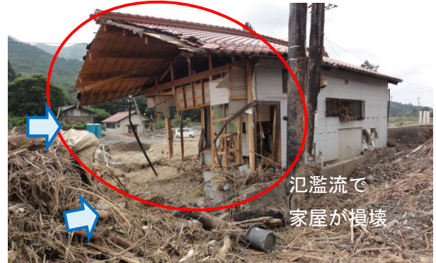
写真-2.2.12 氾濫流により損壊した家屋 (8月6日調査)
