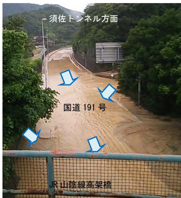
写真-2.2.43 国道191号須佐トンネル方面からの氾濫流の状況 （JR山陰線高架橋より）（7月28日）（萩市提供）
