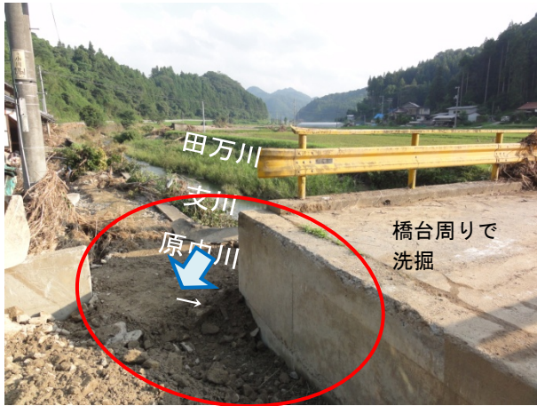
写真-2.2.19 橋台周りの洗掘状況 (8月5日調査)
