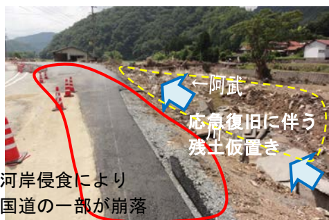
写真-2.2.1 阿武川の河岸侵食により崩落した国道 315 号（8 月 6 日調査）
