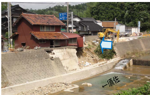
写真-2.2.29 A 橋右岸上流の損壊家屋（8月5日調査）
