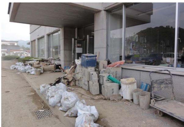
写真-2.2.35 浸水した萩市役所須佐総合事務所 (8月5日調査)
