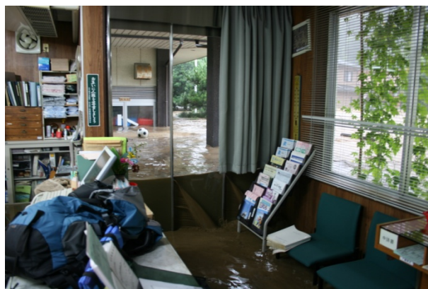
写真-2.3.4 萩市役所小川支所内の浸水状況 (7月28日11:30) (萩市提供)
