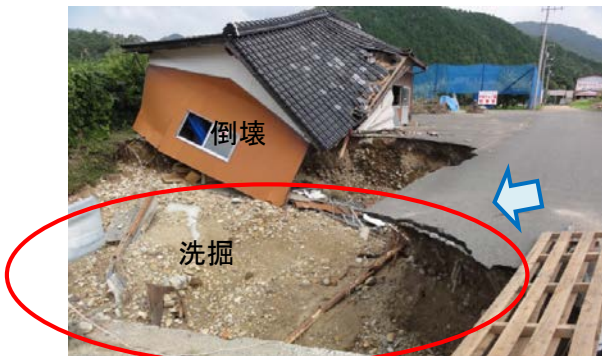
写真-2.2.13 氾濫流により損壊したリンゴ農園の倉庫 (8月6日調査)
