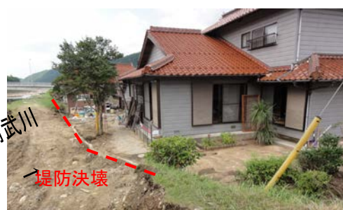
写真-2.2.8 朝早橋下流の堤防決壊状況 (8月6日調査)
