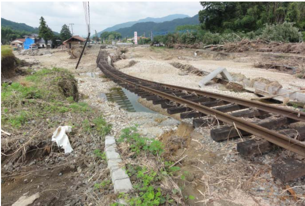
写真-2.3.1 JR 山口線鍋倉駅～徳佐駅間の被害状況 (8 月 6 日調査)
