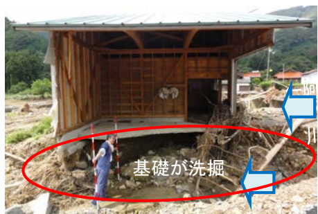
写真-2.2.3 消防車庫の基礎下部洗掘、外壁損壊（8 月 6 日調査）
