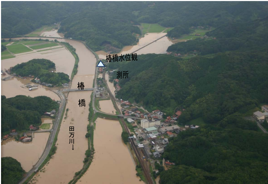
写真-2. 2. 16 田万川下流部の椿橋付近の航空写真（7月28日17時頃）（萩市提供）
