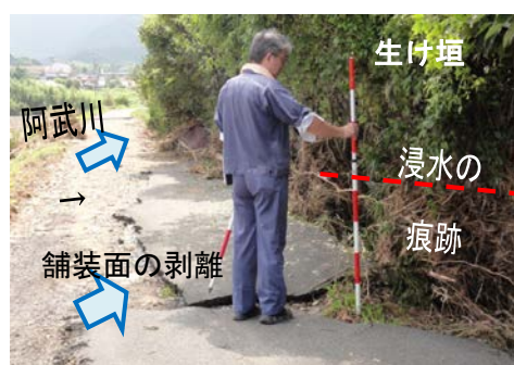
写真-2.2.6 堤防際天端の舗装面剥離と 生け垣に付着した漂流物 (8月6日調査)
