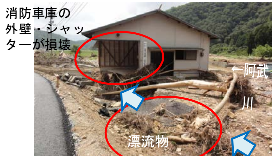
写真-2.2.2 消防車庫の被害状況と漂流物等（8 月 6 日調査）
