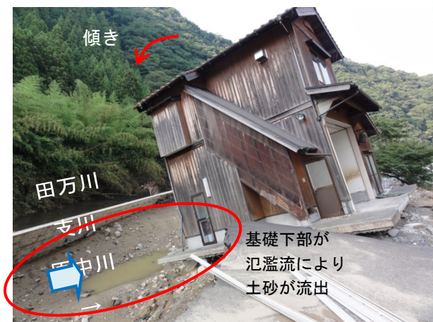
写真-2.2.17 消防車庫の傾斜(8月5日調査)
