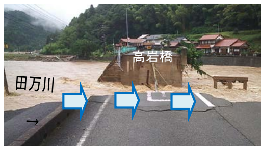
写真-2.2.21 高岩橋の橋台背後に氾濫流が迂回 (7月28日16時頃)(萩市提供)
