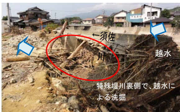
写真-2.2.36 龍背橋上流左岸の堤防越水箇所 (8月5日調査)
