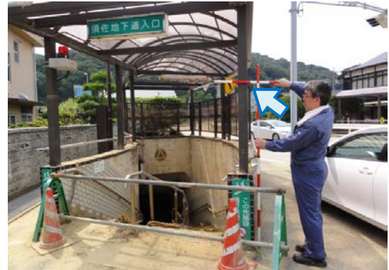
写真-2.2.41 水没した中津交差点地下道入口の痕跡 (8月5日調査)
