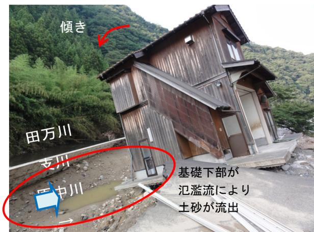
写真-2.2.17 消防車庫の傾斜(8月5日調査)
