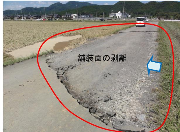
写真-3.2.19 戸田地区の農道における舗装面の剥離
