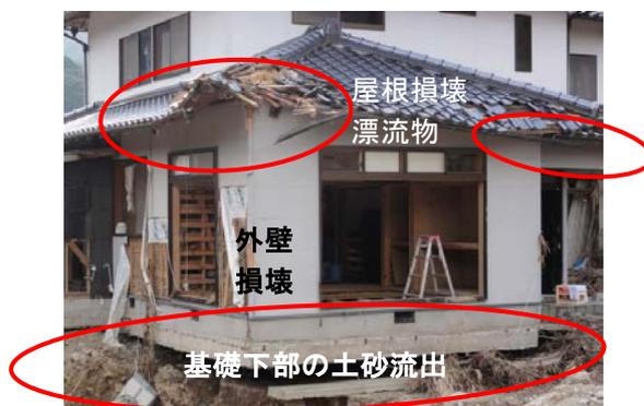
写真-2.2.26 家屋基礎下部の土砂流出
