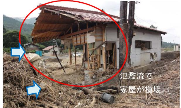
写真-2.2.12 氾濫流により損壊した家屋
