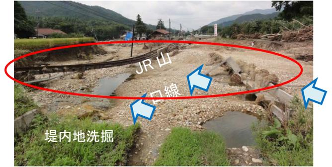
写真-2.2.10 氾濫流による線路盛土の流失
