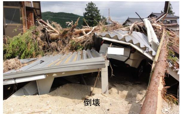
写真-2.2.14 車庫の倒壊と自動車の被害
