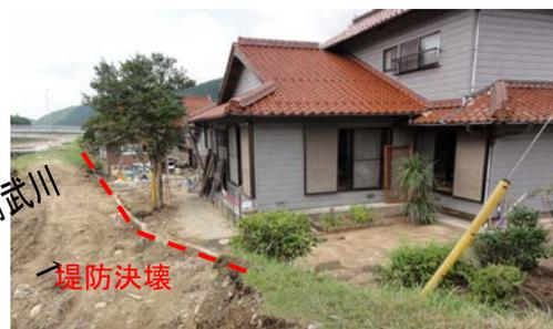
写真-2.2.8 朝早橋下流の堤防決壊状況
