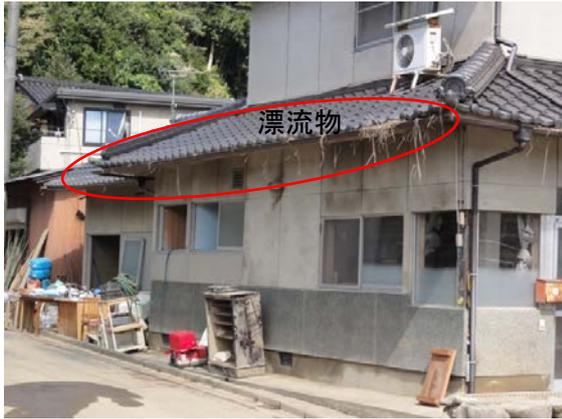
写真-3.2.31 家屋1階屋根の浸水痕跡
