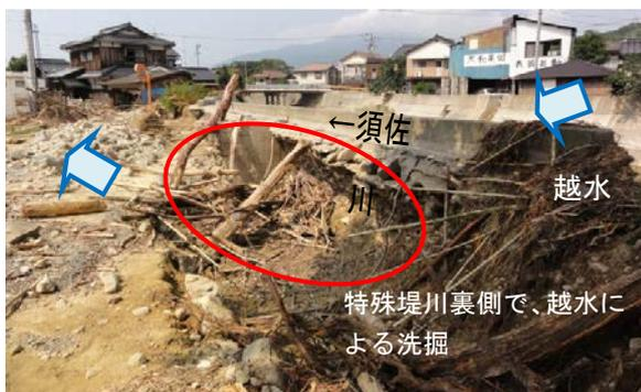
写真-2.2.36 龍背橋上流左岸の堤防越水箇所
