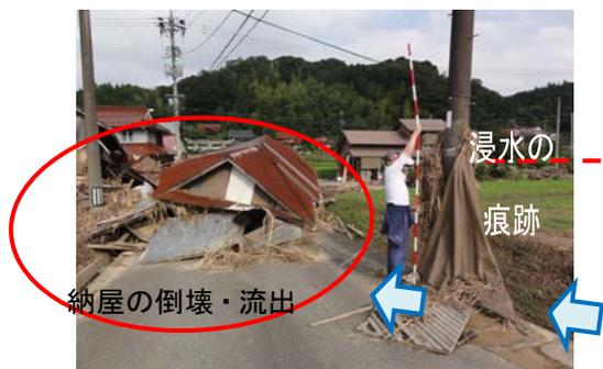
写真-2.2.23 下小川地区の納屋の倒壊・流出
