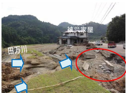
写真-2.2.27 道路側溝の散乱状況
