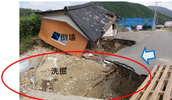
写真-2.2.13 氾濫流により損壊したリンゴ農園の倉庫
