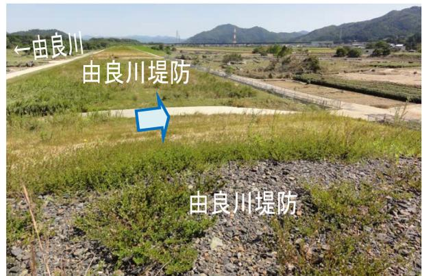
写真-3.2.17 緊急水防災対策施工中の開口部より溢水
