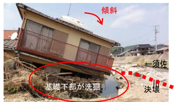
写真-2.2.37 基礎下部の洗掘により倒壊した家屋
