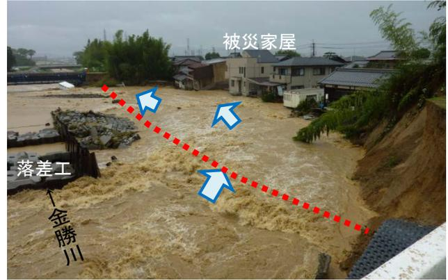
写真-3.2.3 堤防の決壊と洪水流
