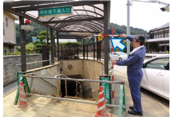
写真-2.2.41 水没した中津交差点地下道入口の痕跡
