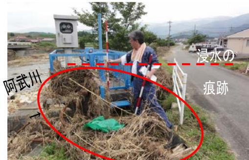
写真-2.2.5 樋管に付着した漂流物
