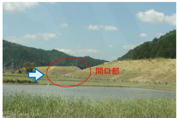
写真-3.2.30 緊急水防災対策施工中の開口部より溢水
