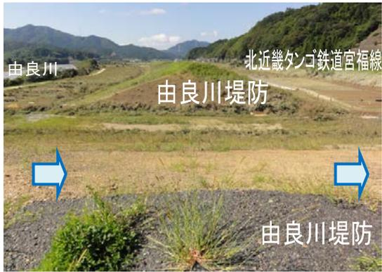
写真-3.2.24 緊急水防災対策施工中の開口部より溢水
