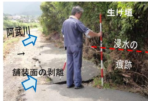
写真-2.2.6 堤防際天端の舗装面剥離と
