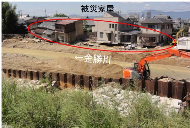
写真-3.2.4 堤防近傍の家屋の被害状況 (9月18日調査)
