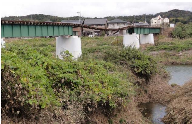
写真-3.3.1 信楽高原鐵道仙川橋梁橋脚流出
