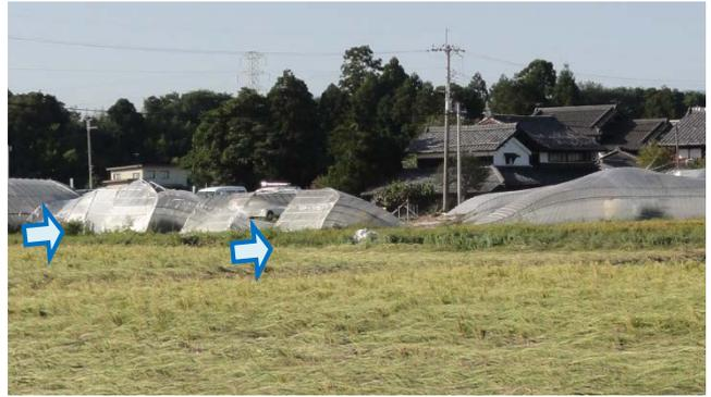
写真-3.2.11 ビニールハウスの損壊
