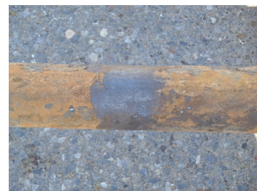
写真-4.19 タイロッド腐食状況
