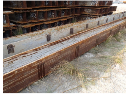
写真-4.21 土中部側拡大
