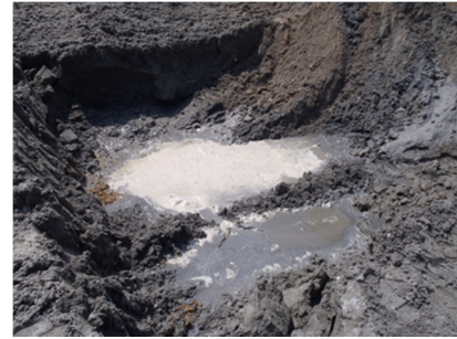
写真-4.10 タイロッド調査箇所周辺の土壤状況
