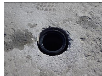
写真-2.9 VP100立て込み完了（構造3-2）
