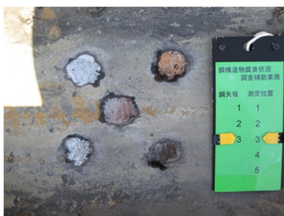
写真-4.8 計測箇所拡大 (No.3 : -4.2m)
