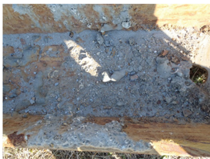
写真-4.6 上部側拡大 (海生生物付着の痕跡)
