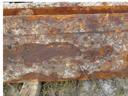
写真-4.23 計測箇所拡大（水中部側）
