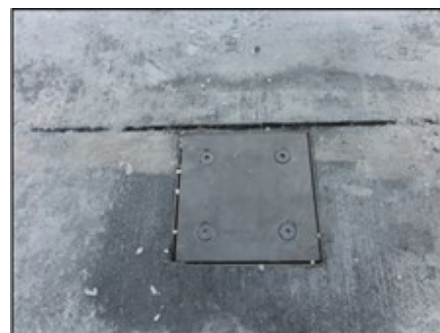
写真-2.5 構造1 設置完了 (ふた閉口状態)
