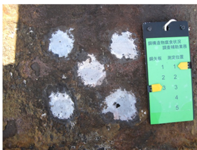
写真-4.7 計測箇所拡大 (No.3 : -0.2m)
