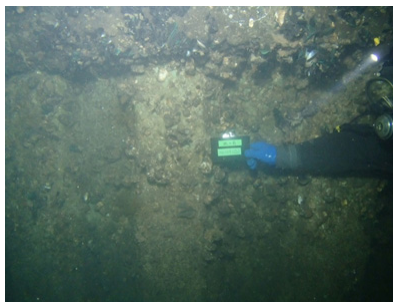
写真-3.8 水中硬化形被覆の外観の一例 (矢板凹面)
