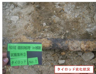
写真-4.15 タイロッドの腐食状況
