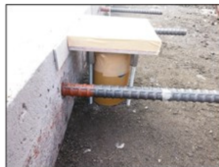
写真-2.4 蓋およびボイド管設置
