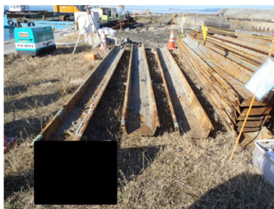
写真-4.5 控え工全景
