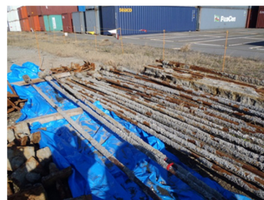
写真-4.3 タイロッド全景
