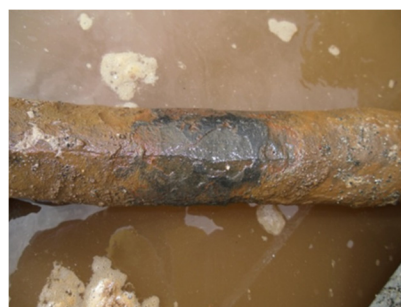
写真-4.1 タイロッド腐食状況の例
