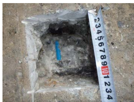
写真-3.2 鉄筋腐食確認状況
