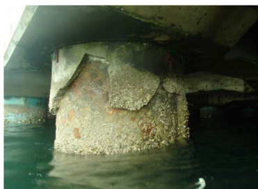
写真-3.18 モルタル被覆防食の劣化事例(施設C)
