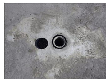
写真-2.10 構造3設置完了（ふた開放状態）
