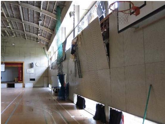
写真 5.8.2-41 損傷して傾いた内壁
