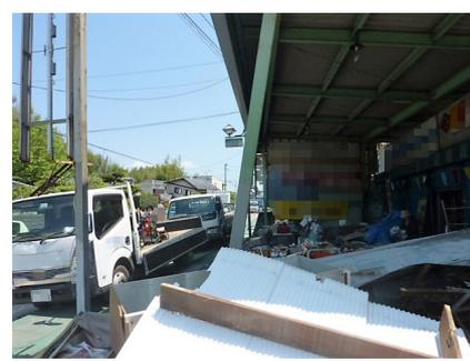
写真 5. 4-32 柱の傾斜
