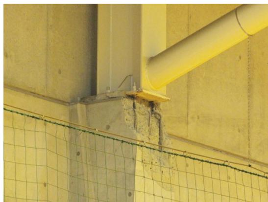
写真 5.8.2-47 支承部のコンクリートの側方破壊
