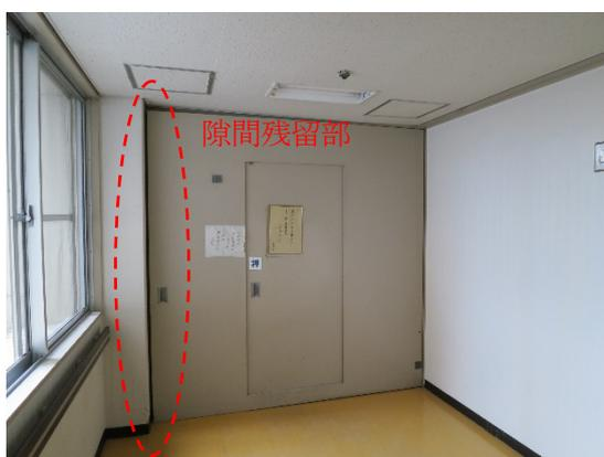
写真 5. 8. 2-63 完全には閉鎖しなくなった防火戸（SRC 造、熊本市東区）
