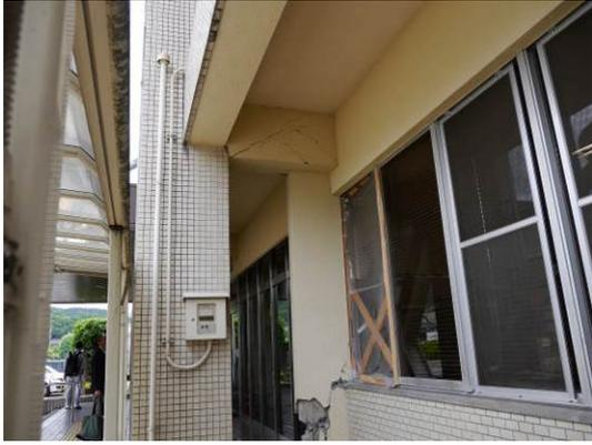
写真5.5-174 短スパン梁のせん断ひび割れ
