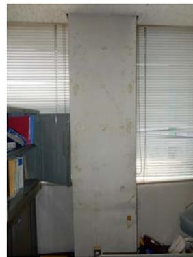
写真5.5-268 柱のせん断ひび割れ
