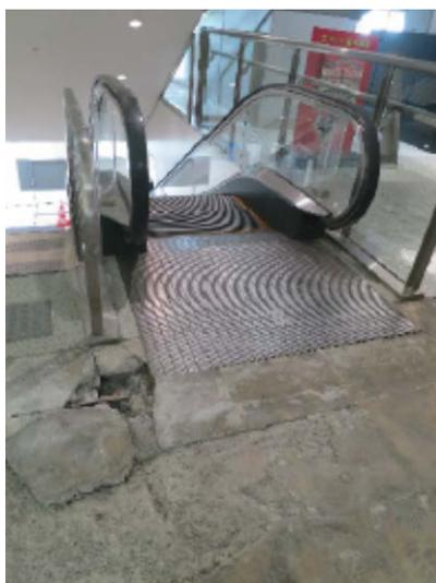
写真 5.8.3-14 エスカレーター接続部での被害
