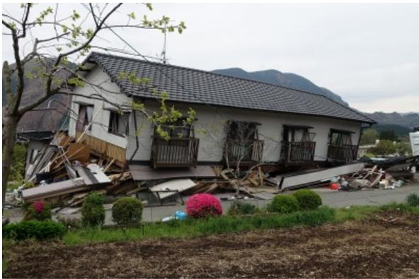
写真 5.3-58 倒壊した木造アパート
