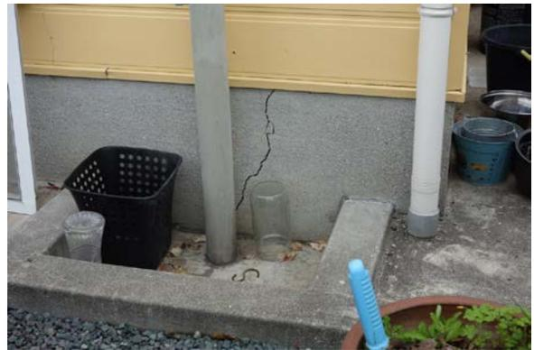
写真 5.6-8 写真 5.6-6 の建築物の基礎の様子。ひび割れを確認
