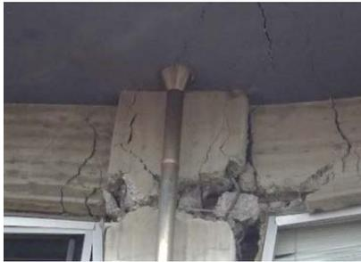
写真5.5-196 5階柱頭部の破壊
