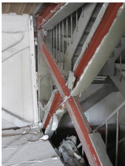
写真 5.4-192 溝形鋼ブレースの座屈
