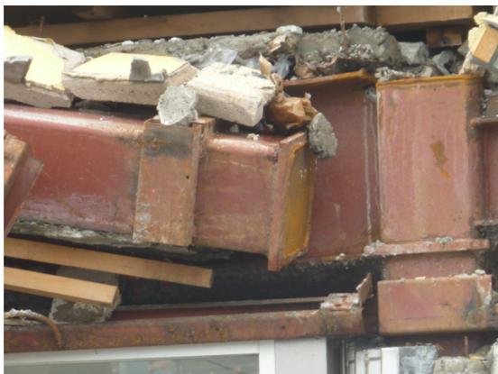
写真 5.4-2 パネルーダイアフラム間の溶接部の破断
