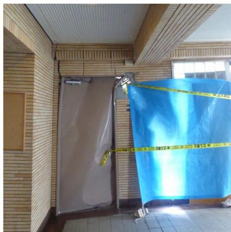
写真5.5-81 1階エントランスホール内部と住棟本体（左側）をつなぐ梁端の大きな残留ひび割れ
