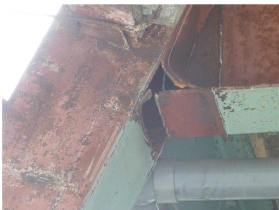
写真 5.4-5 梁端破断
