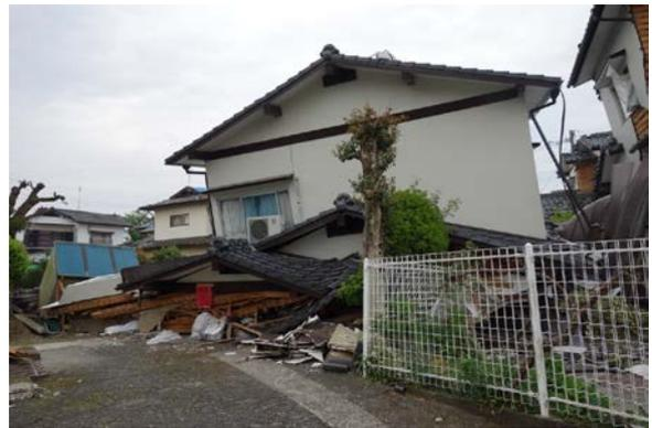
写真 5.6-2 1 階が倒壊している建築物
