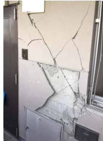
写真5.5-235 桁行き方向外廊下側玄関脇の方立て壁のせん断破壊
