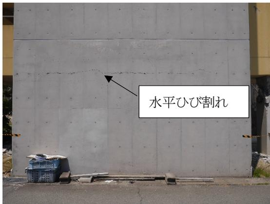
(a) 桁行外柱連層耐力壁（水平ひび割れ）
