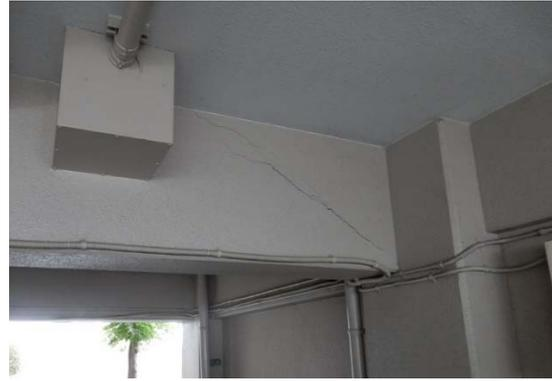
写真5.5-63 1階駐輪場内の桁行方向の大梁のせん断ひび割れ
