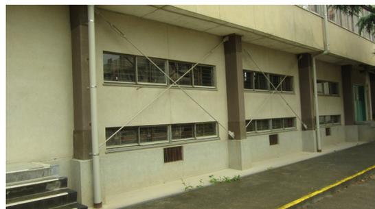
写真 5.4-108 1階鉛直ブレース（被害なし）
