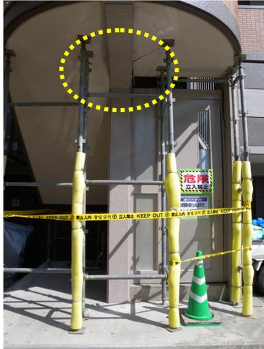
写真 5.7.2-45 外階段の被害
