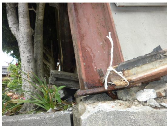
写真 5.4-8 柱脚部の損傷状況
