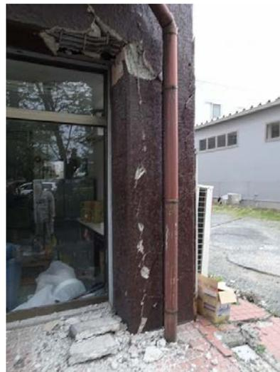
写真5.5-257 1 階柱 (北東側) の主筋付着割裂ひび割れと 2 階梁端部の破壊
