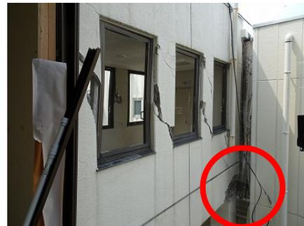
写真5.5-157 渡り廊下被害柱梁接合部被害
