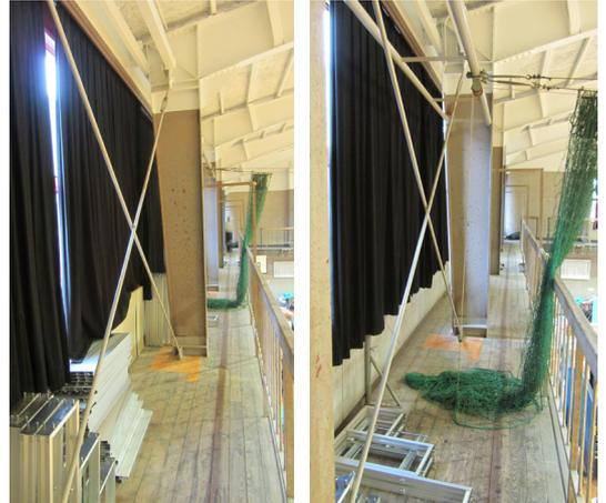
写真 5.4-106 2階鉛直ブレース（被害なし）
