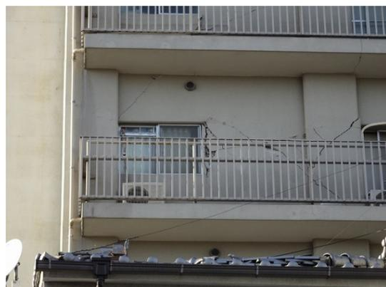
写真5.5-251 5階張間方向南側妻構面の袖壁付き柱せん断破壊
