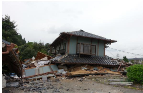
写真 5.3-27 倒壊した木造住宅
