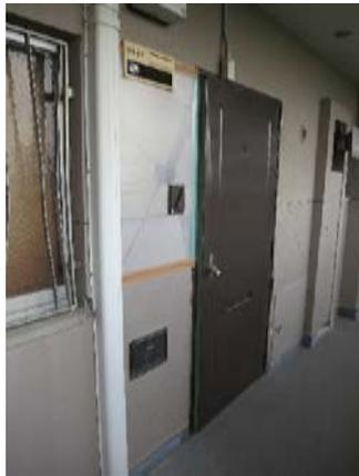
写真 5.8.2-65 開閉障害が発生した玄関扉（RC造、熊本市中央区）
