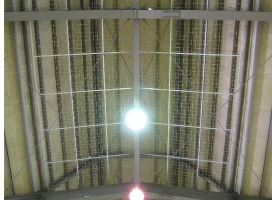
写真 5. 4-168 吊り材が脱落した天井
