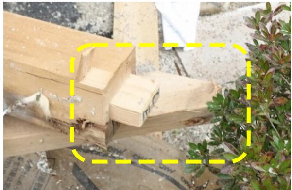
写真 5.3-51 柱頭部 (釘打ちによる接合)
