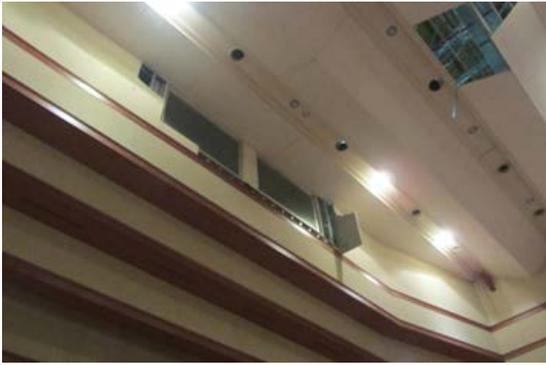
写真 5.8.2-39 客席後方上部の開口脇の内壁の損傷・脱落
