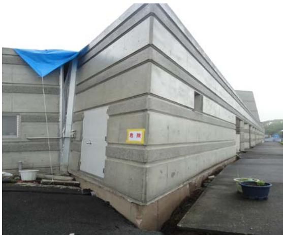
写真5.5-139 建築物北東面の地盤沈下
