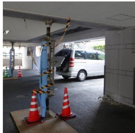
写真5.5-42 支保工による張間方向大梁のたわみ対策
