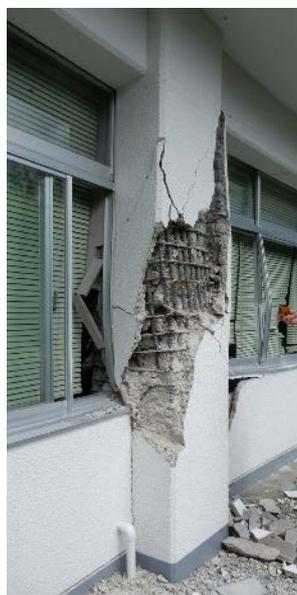
写真5.5-186 柱のせん断破壊
