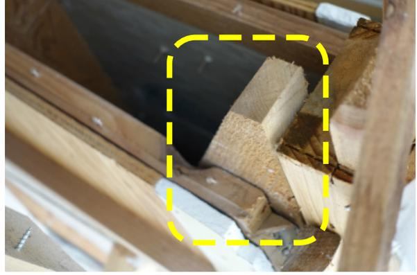
写真 5.3-47 アパート A の筋かい端部
