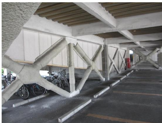
写真 5.4-189 建築物内のブレースの様子
