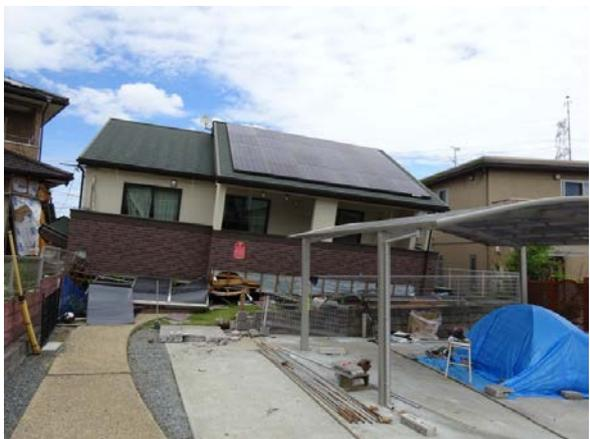
写真 5.3-18 倒壊した木造住宅
