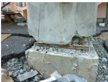
写真 5.4-37 柱脚部の損傷状況
