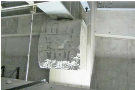
写真 5.8.2-46 S 造屋根支承部の損傷 (脱落)
