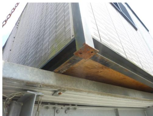
写真 5. 4-42 柱脚部ボルト破断
