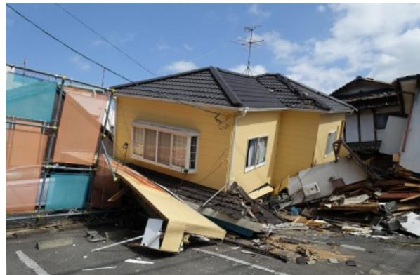
写真 5.3-11 倒壊した木造住宅
