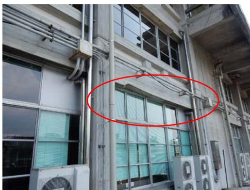
写真5.5-274 大梁下端のコンクリートの剥落
