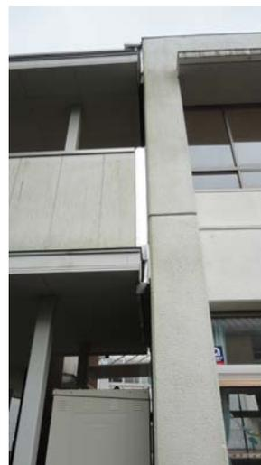
写真5.5-154 エキスパンションジョイントの損傷
