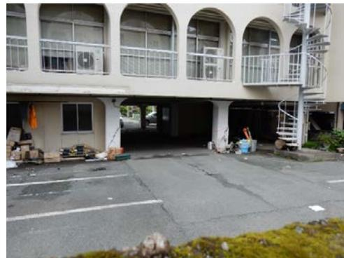
写真5.5-310 建築物南東構面における1階柱のせん断破壊
