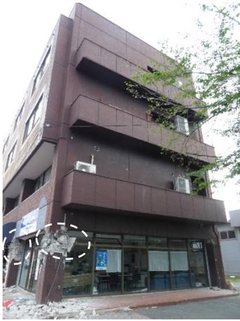
写真5.5-254 外観 (南東側) と大破した 2 本の柱
