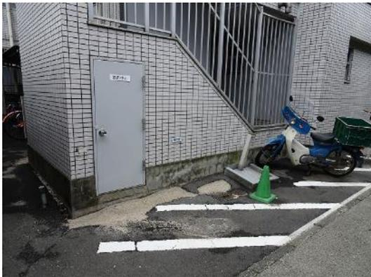
写真5.5-75 表層アスファルト路盤の凹凸
