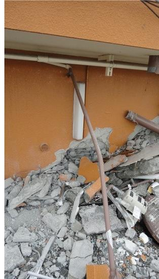
写真5.5-231 層崩壊した1階柱
