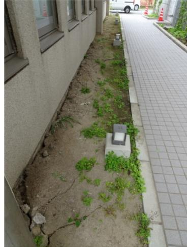
写真5.5-125 建築物に接する地盤のひび割れ
