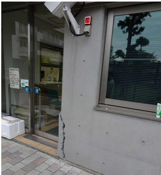
写真5.5-128 外壁端部のひび割れ
