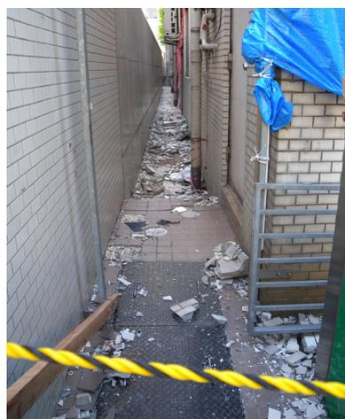
写真 5.7.2-16 隣接建物（右側）の外装材落下被害
