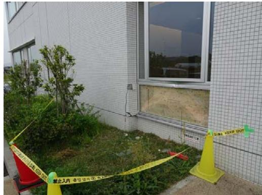
写真5.5-110 耐力壁脚部の損傷
