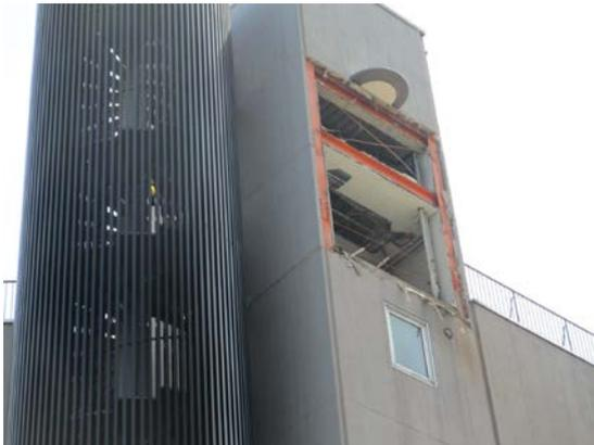
写真 5. 8. 2-56 駐車場の塔屋の被害
