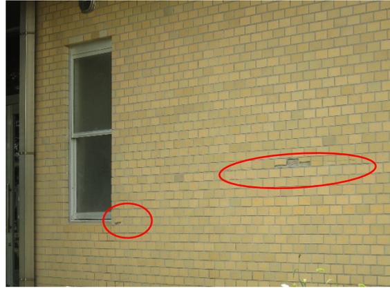
写真 5. 4-98 外壁のひび割れ・タイル剥落(赤円内にひび割れ・タイル剥離)
