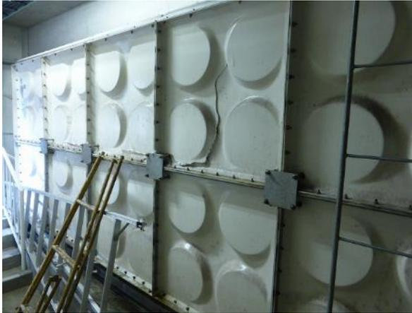
写真5.5-69 FRP 受水槽の破損
