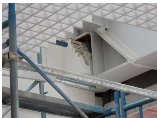
写真5.5-121 エントランス屋根上の鉄骨梁を支える RC 造コーベルの損傷
