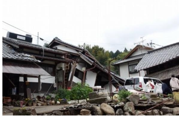
写真 5.3-39 倒壊した木造住宅
