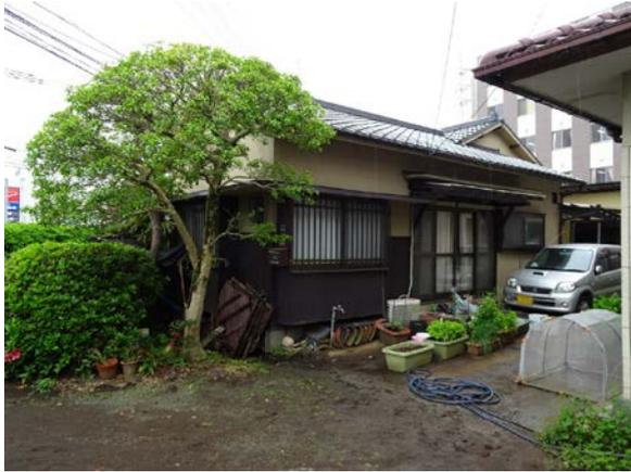
写真 5.6-49 地盤の液状化により基礎の損傷を伴って沈下したと思われる平家建木造住宅
