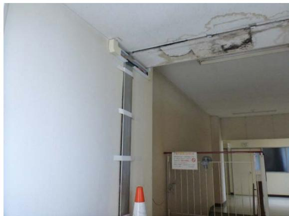
写真5.5-132 エキスパンションジョイント保護カバーの変形（内側）
