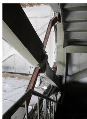
写真 5.4-191 ブレースの耐火被覆の剥落
