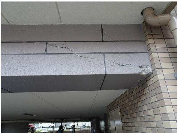
写真5.5-41 張間方向妻構面2階大梁端部のせん断ひび割れ
