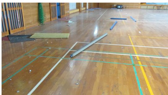
写真 5. 4-142 落下した立体トラスの部材
