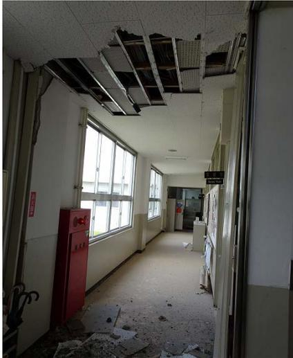
写真5.5-285 天井材の落下
