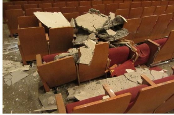
写真 5.8.2-2 1階客席へのラスモルタル天井の脱落
