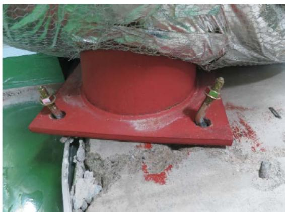
写真 5.8.3-8 屋上貯湯槽アンカー接合部の損傷
