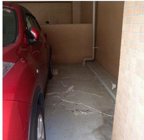
写真 5. 7. 2-53 免震層上面の床スラブの損傷（西側外周部の大梁内側にあたる部分）
