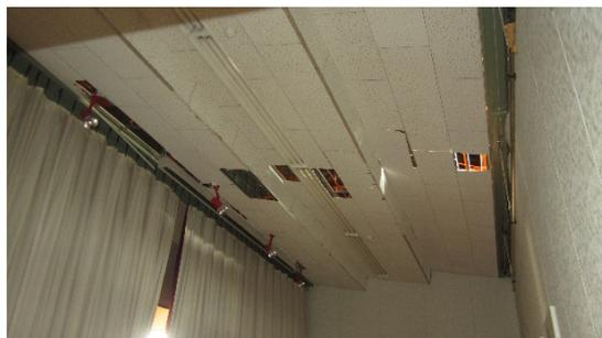
写真 5.8.2-16 舞台の天井の損傷・一部脱落
