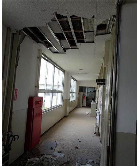
写真 5. 8. 2-25 天井材の落下
