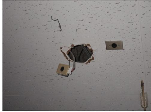
写真 5.8.2-71 1階天井板破損箇所
