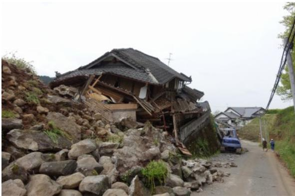
写真 5.3-40 倒壊した木造住宅
