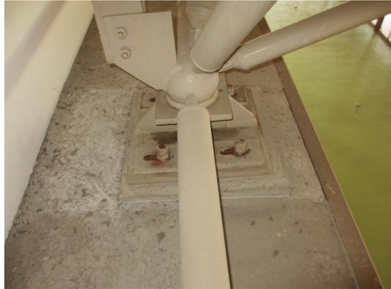
写真 5.4-187 体育館Nの桁行き構面の屋根支承部（長孔の端までボルトが移動）
