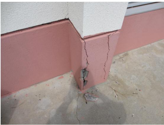
写真 5.4-51 柱脚部のコンクリートひび割れ
