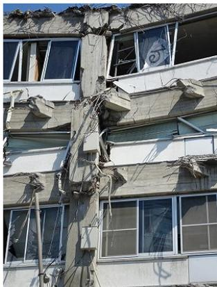
写真5.5-201 4、5階十字形柱梁接合部の損傷（南西側）
