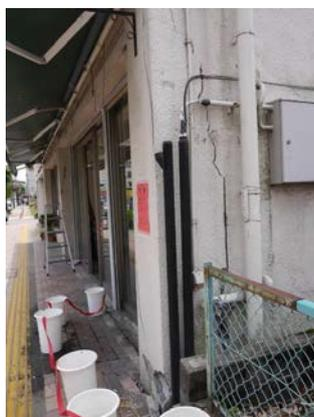
写真5.5-301 1階柱のせん断ひび割れ
