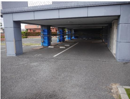
写真5.5-9 1階（ピロティ層）の被害
