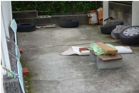
写真 5.6-7 写真 5.6-6 の建築物周辺の地盤変状
