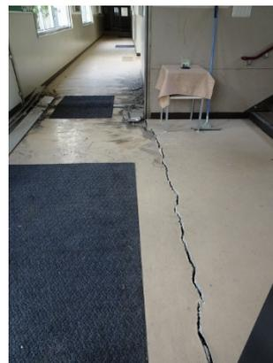
写真5.5-284 1階スラブのひび割れと段差
