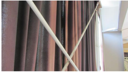
写真 5.4-112 2階鉛直ブレース (交点での擦れ)
