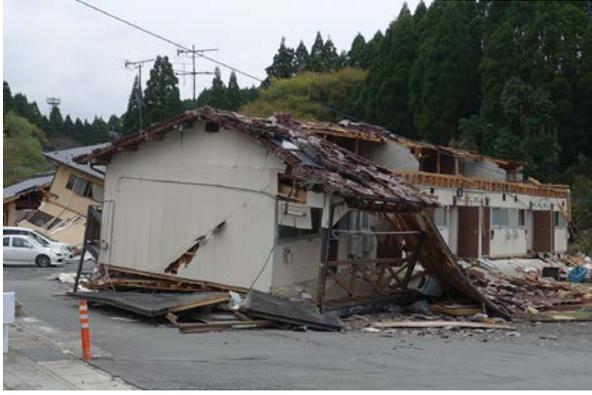
写真 5.3-54 倒壊した木造アパート D
