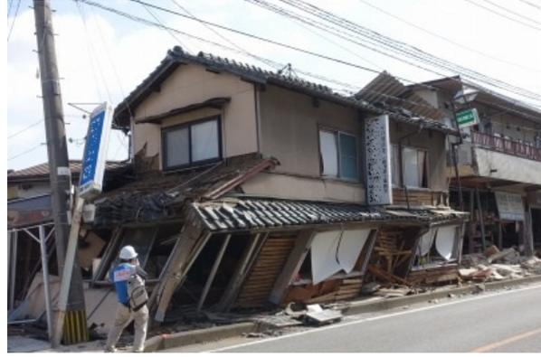
写真 5.3-7 大きく傾斜した店舗併用住宅
