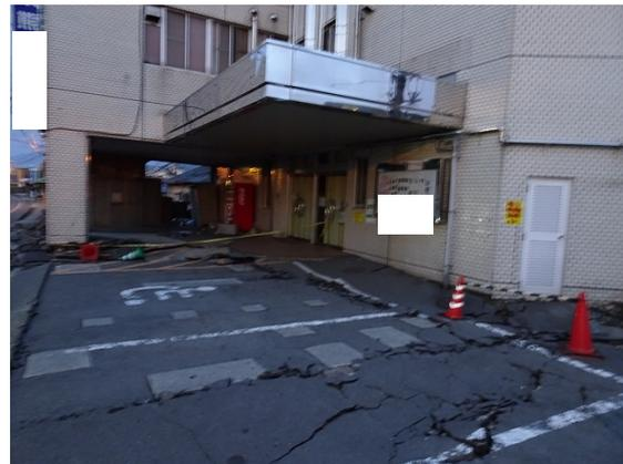
写真5.5-259 地盤の亀裂
