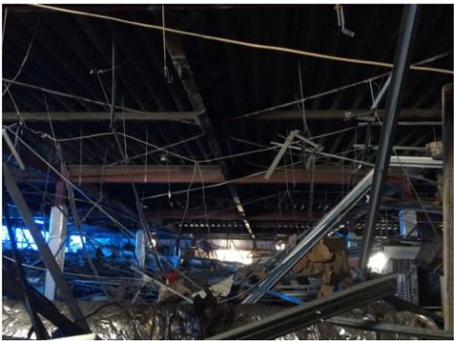
写真 5.8.2-74 2階天井崩落状況
