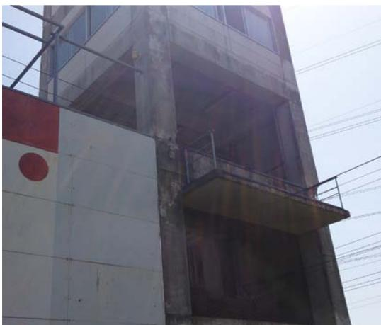
写真5.5-20 前震後の主訓練塔の被災状況
