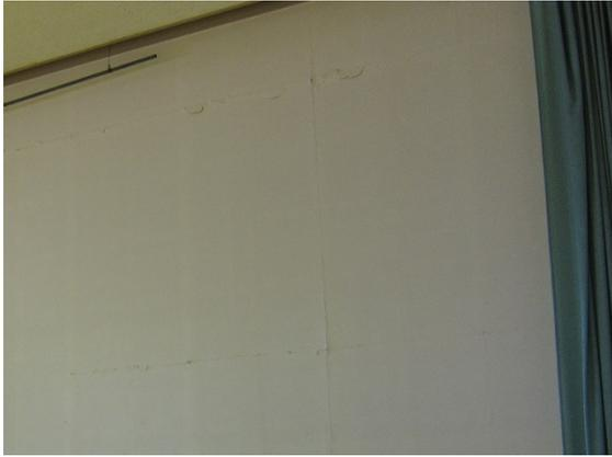
写真 5. 4-97 舞台背面壁の仕上げボード継ぎ目のずれ
