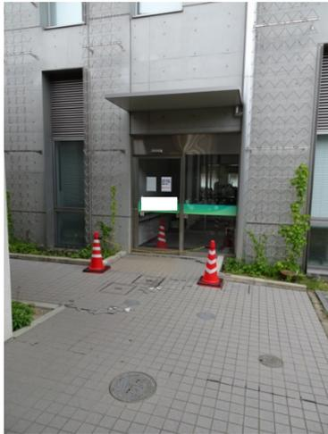
写真5.5-124 南側外構のひび割れ
