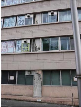
写真5.5-305 建築物北西面における各階柱の損傷
