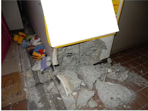
写真5.5-265 2階耐力壁の曲げ圧縮破壊
