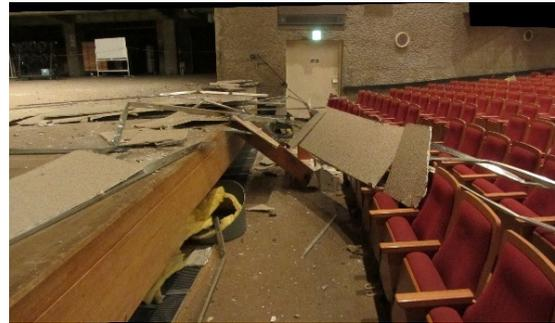
写真 5.8.2-4 1階客席前方に落下した天井(せっこうボード(厚さ 12.5mm)+吹付)
