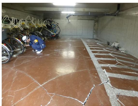
写真5.5-83 1階駐輪場土間スラブの上方向への残留変形と大きなひび割れ
