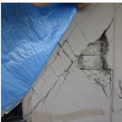
写真5.5-31 共用廊下側柱のせん断破壊
