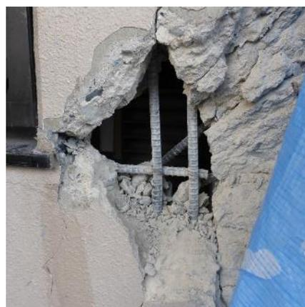
写真5.5-32 共用廊下側柱に取付く腰壁および袖壁 (袖壁横筋は柱内に未定着だが、スリットなし)
