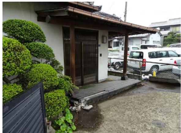
写真 5.6-48 写真 5.6-47 の建築物の 1 階玄関部分の沈下状況
