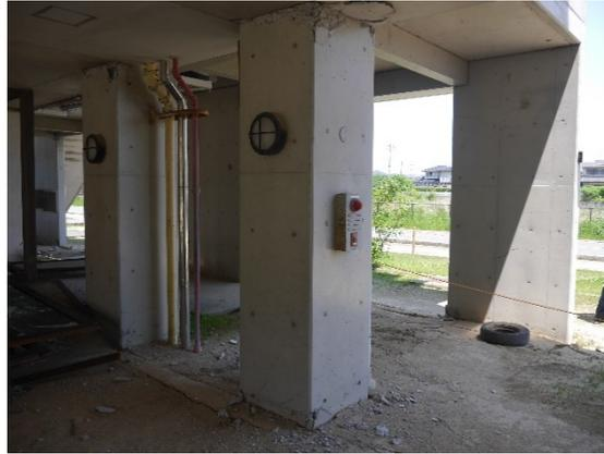
写真5.5-6 X5-Y3 柱（曲げ降伏、損傷度Ⅲ）
