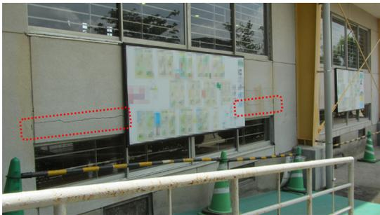
写真 5.4-115 1階外壁の水平なひび割れ
