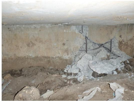
写真5.5-29 1階バルコニー下の基礎部分の損傷
