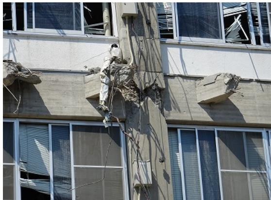
写真5.5-202 4階十字形柱梁接合部の損傷（南東側）
