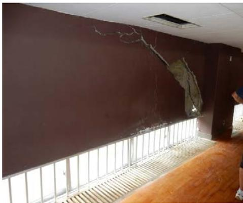
写真5.5-190 非構造壁のせん断破壊
