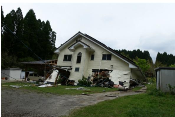
写真 5.3-68 倒壊した木造住宅（金物あり）
