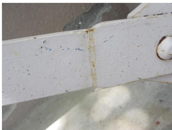
写真 5.4-90 ブレース母材と端部の幅広プレートの境界がわずかに降伏 (写真 5.4-89 の拡大)
