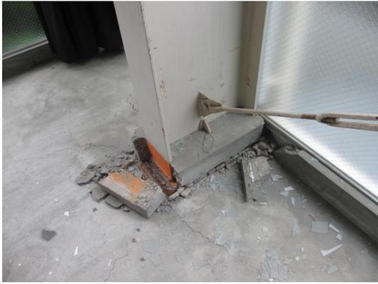
写真 5.4-82 柱脚部のコンクリート破壊
