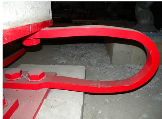
写真 5.7.2-19 鋼材ダンパーの変状
