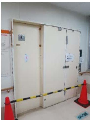
写真 5. 8. 2-62 脱落した折り畳み式防火戸（RC+S 造、大津町）
