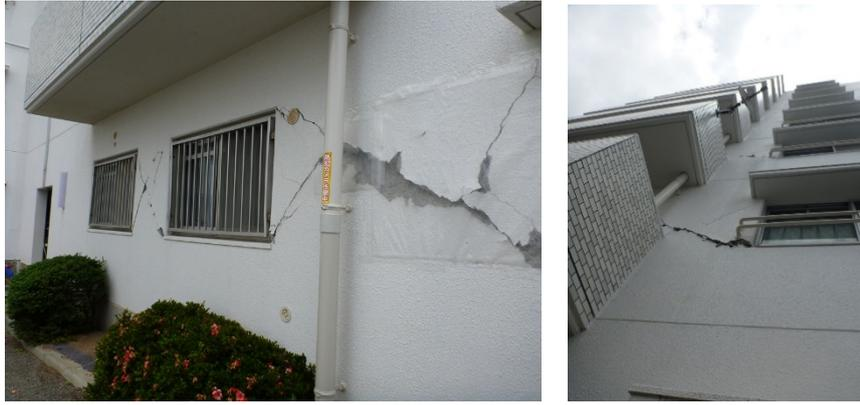
写真5.5-66 張間方向の妻壁の被害
