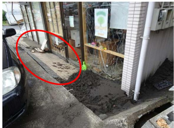
写真 5.6-52 写真 5.6-51 の建築物の1階部分の沈下状況
