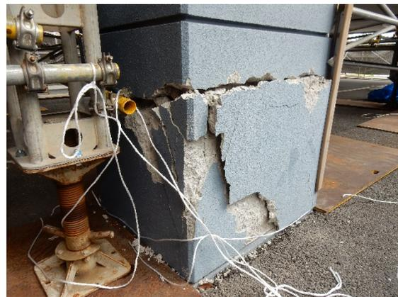
写真5.5-10 1階柱の水平ひび割れ
