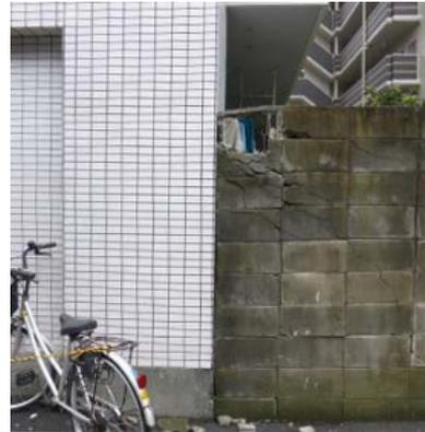
写真5.5-76 柱の傾斜方向 (写真矢印) にあるコンクリートブロックの破壊とせん断ひび割れ
