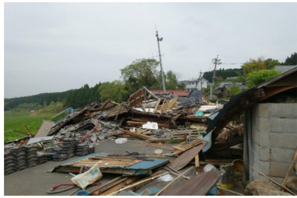
写真 5.3-37 倒壊した木造住宅
