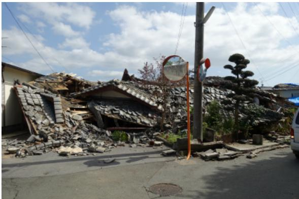
写真5.3-2 倒壊した木造住宅
