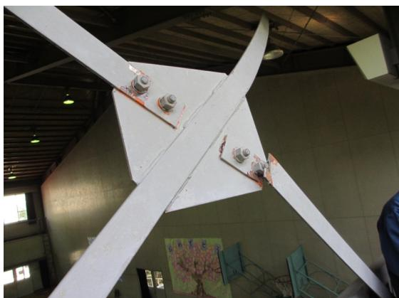
写真5.4-174 体育館Oのブレース孔欠損部の破断
