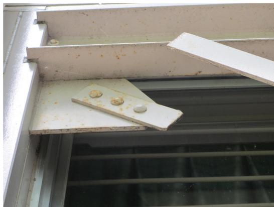
写真5.4-173 体育館Fの母材破断
