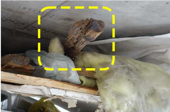
写真 5.3-48 アパート A の筋かい端部
