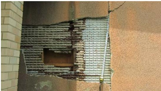
写真 5.8.2-52 入り口脇の外壁モルタルの落下
