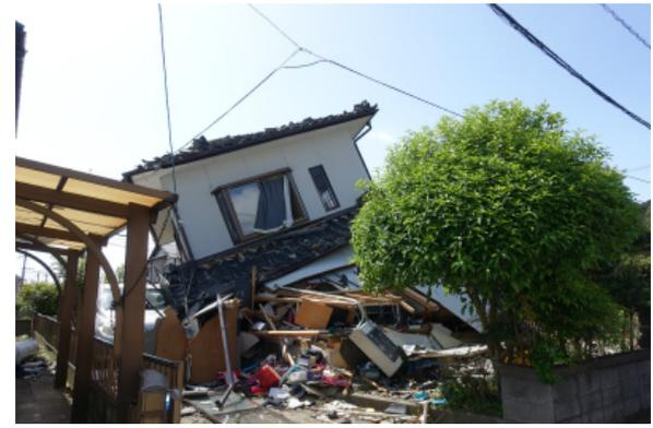
写真 5.3-9 倒壊した木造住宅
