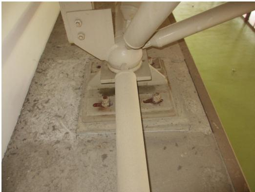
写真 5.4-159 建物桁行構面は長孔の支承部で長孔の端までボルトが移動
