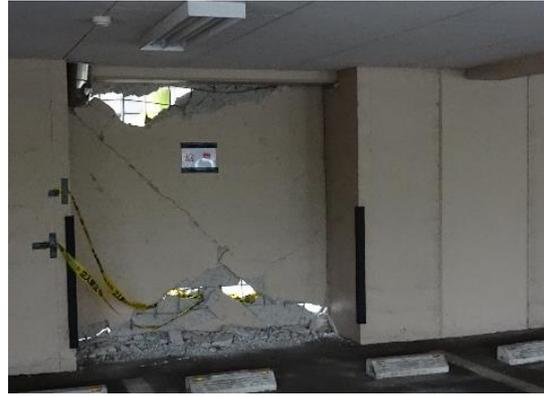
写真5.5-53 1階桁行方向の非構造壁の
