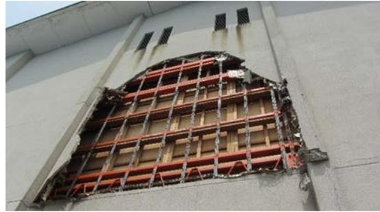
写真 5.8.2-51 舞台裏 ラスモルタル外壁の落下
