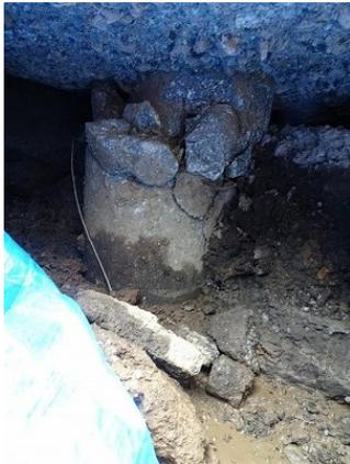
写真5.5-160 庁舎棟南西側コンクリート杭
