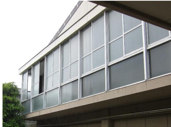
写真 5.4-83 窓ガラスの被害
