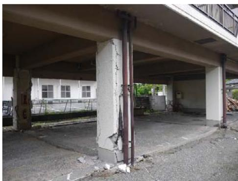
写真5.5-14 X3-Y1 柱 (付着割裂破壊、損傷度IV)
