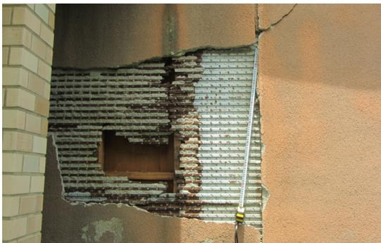
写真 5.4-116 入り口脇の外壁モルタルの落下
