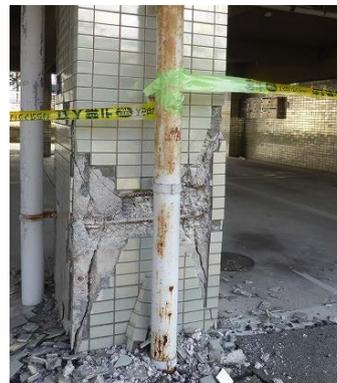
写真5.5-38 1階柱張間方向のせん断ひび割れ
