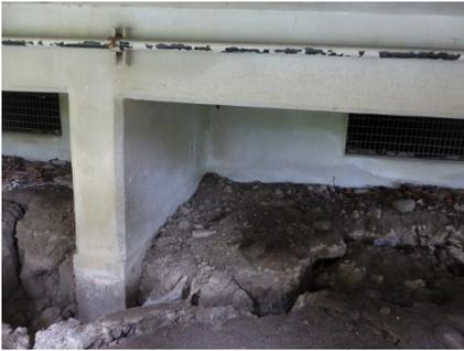
写真5.5-94 建築部外周部の地盤の亀裂
