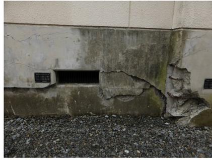
写真5.5-93 基礎立上り部の損傷
