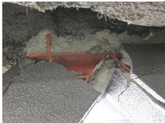
写真 5.4-198 ブレース交差部の耐火被覆の剥離
