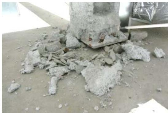
写真 5.8.2-45 屋根支承部の被害 (諸室棟)
