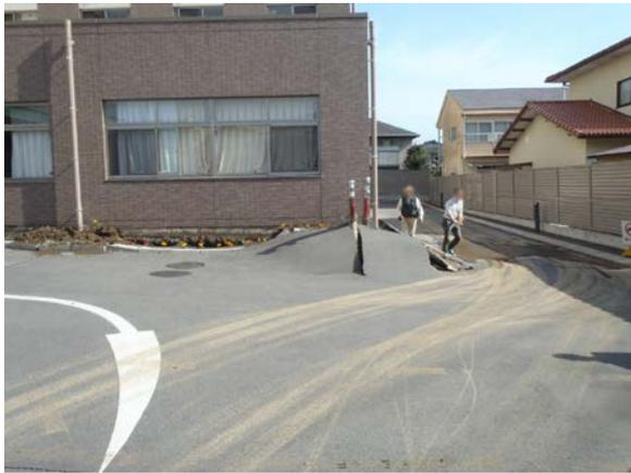
写真 5.6-57 写真 5.6-55 の建築物の周辺地盤の沈下状況（平成 28 年 4 月 15 日午前撮影）
