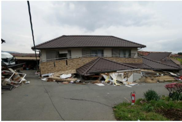
写真 5.3-70 倒壊した木造住宅（金物あり）
