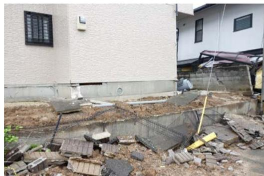
写真 5.6-41 写真 5.6-40 の建築物の基礎。ひび割れが認められるが、破壊はしていない。地盤変状は認められる。
