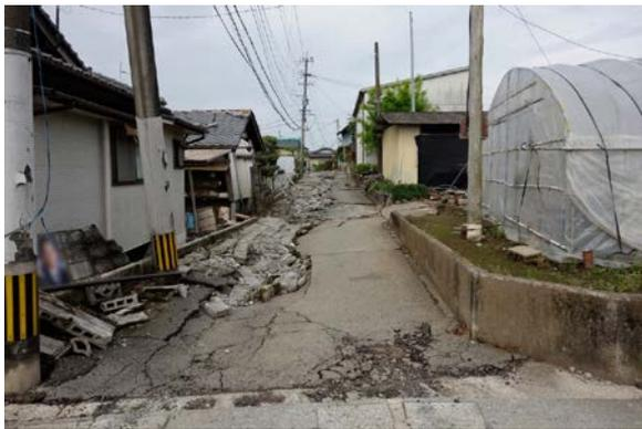
写真 5.6-10 A 通り・県道 28 号南側の道路の舗装の様子。北側に比べて損傷が大きく見える。
