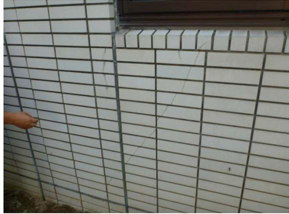
写真5.5-130 非構造壁のひび割れ
