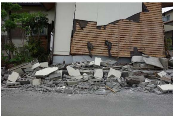
写真 5.6-18 写真 5.6-17 の建築物の基礎周りの様子。基礎にひび割れが見られ、地盤変状も認められる。
