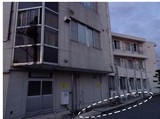
写真5.5-261 コンクリートブロック塀の倒壊
