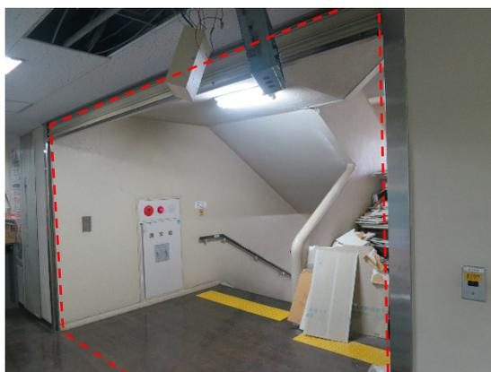
写真 5. 8. 2-64 自動閉鎖したのち開放できなくなっていた防火シャッター（RC 造、御船町）
