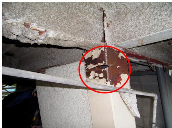
写真 5.4-26 柱の破断
