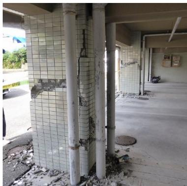
写真5.5-37 1階柱桁行方向のせん断破壊
