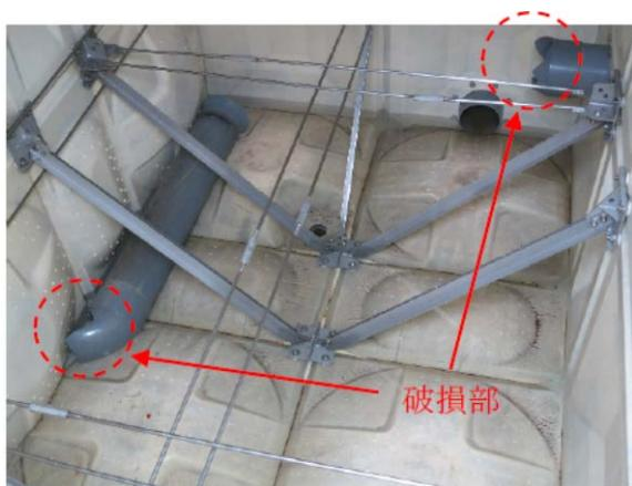
写真 5.8.3-5 病院 A における水槽内部のオーバーフロー管損傷傷
