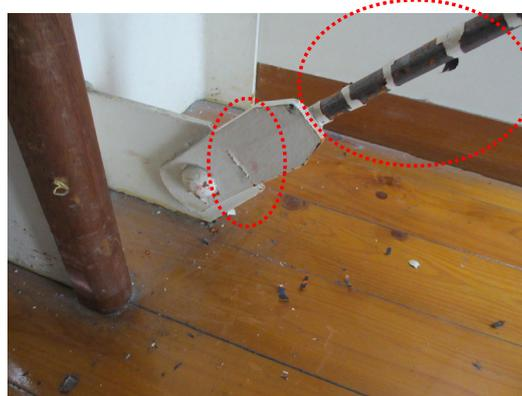
写真 5.4-121 ブレース端部の塑性化と羽子板の曲がり
