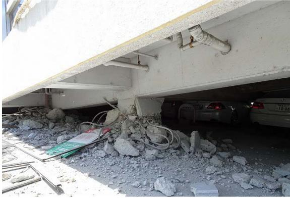
写真5.5-211 破壊した南側の1階柱
