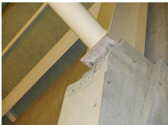
写真 5.4-57 支承部のコンクリートの側方破壊
