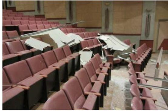
写真 5.8.2-8 脱落した天井
