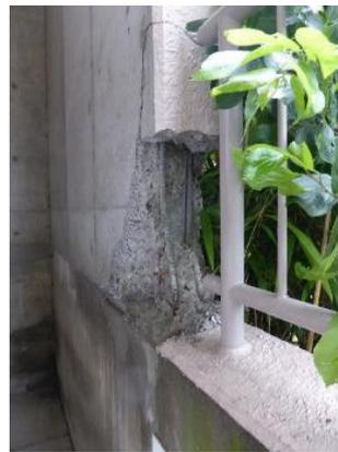
写真5.5-72 駐車場の桁行方向非構造壁の損傷
