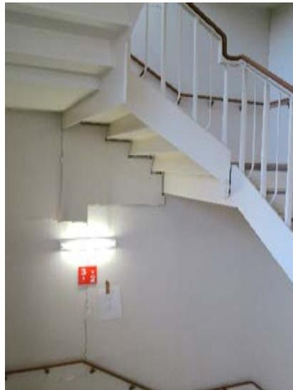
写真 5.8.2-68 階段室内の壁の被害 (RC+S 造、大津町)
