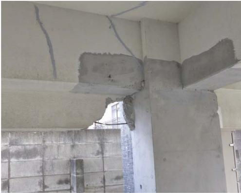
写真5.5-48 垂れ壁端部のコンクリート剥
