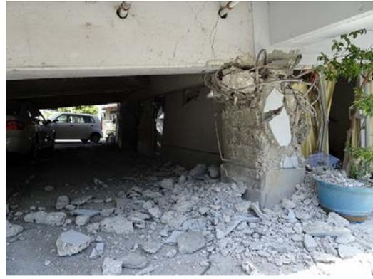
写真5.5-212 破壊した北側の1階柱
