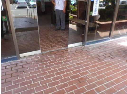
写真5.5-277 自動ドアレールの変形
