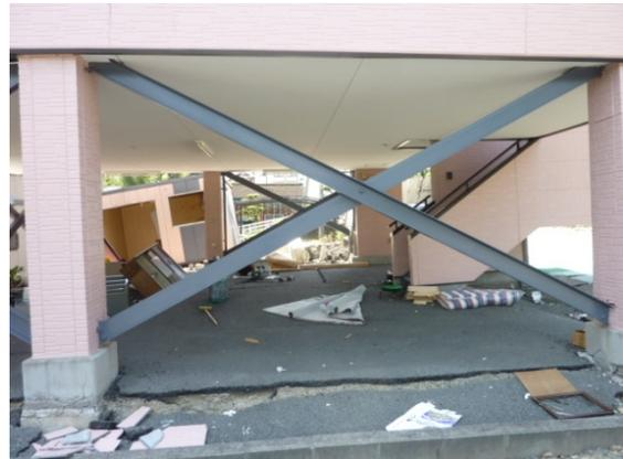
写真 5.4-36 ブレースの状況 (ほぼ無損傷)
