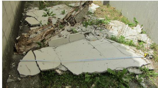
写真 5.4-70 左の壁面から脱落したモルタル (厚さ約 3.5cm)
