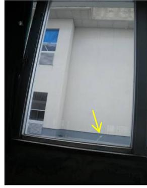
写真 5. 8. 2-92 開口部ガラス破損箇所
