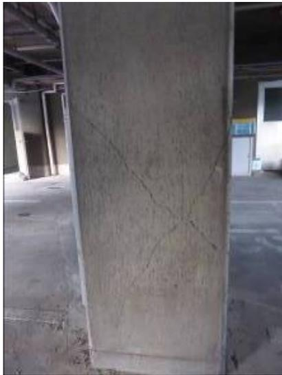
写真5.5-240 1階柱のせん断ひび割れ
