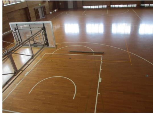
写真 5.4-152 落下したトラス下弦材
