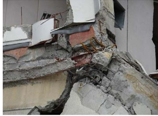
写真5.5-221 柱頭部の破壊（南面）
