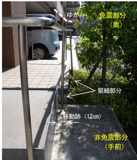
写真 5. 7. 2-56 エキスパンション部の変状 (手すりの変形、移動跡)
