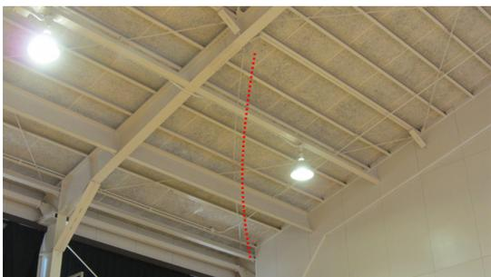
写真 5.4-77 屋根面水平ブレースのたわみ（隅角部）
