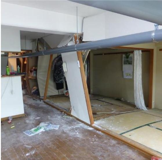
写真5.5-84 1階住戸木間仕切り壁の損壊
