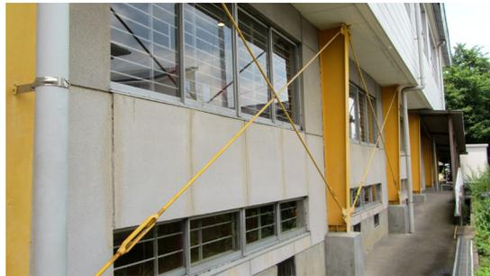
写真 5.4-114 1階の鉛直ブレース
