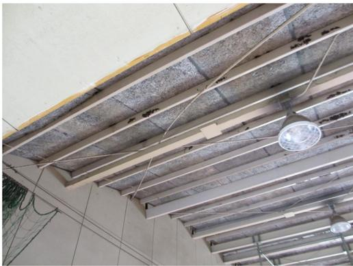
写真 5. 4-47 屋根面水平ブレースの曲がり
