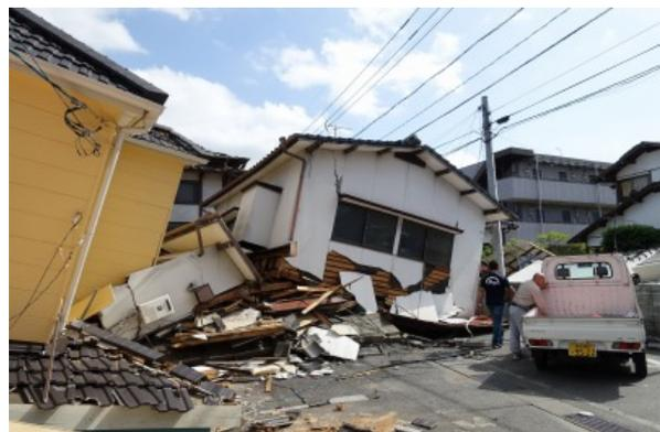
写真 5.3-13 倒壊した木造住宅
