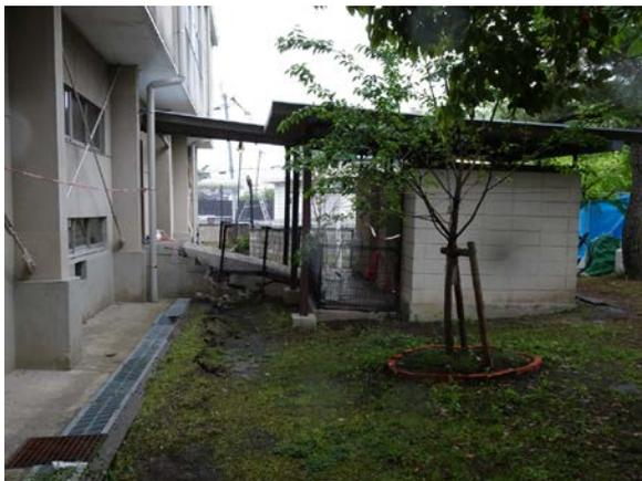
写真 5.6-59 写真 5.6-58 の小学校の体育館の周辺地盤の沈下状況
