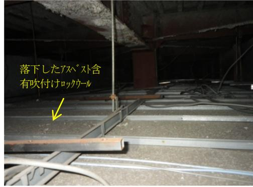
写真 5.8.2-73 1階吊り天井内部
