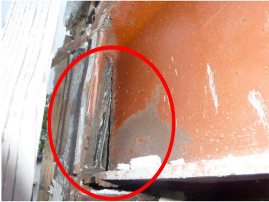
写真 5. 4-27 梁端破断
