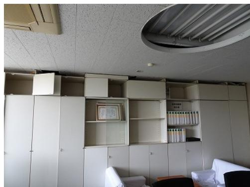
写真5.5-169 什器天端の天井材の被害
