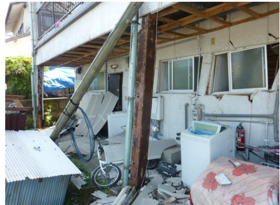
写真 5. 4-30 柱の傾斜
