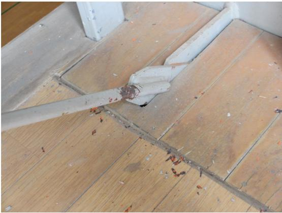
写真 5. 4-45 ブレース端部の塑性化
