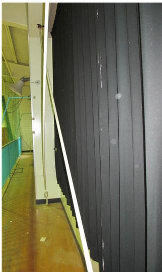
写真 5.4-95 2階ブレースのわずかなたわみ
