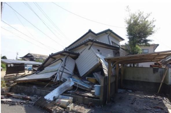
写真 5.3-12 倒壊した木造住宅
