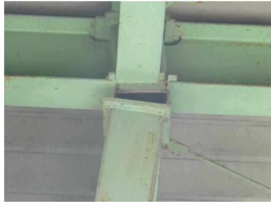
写真 5.4-34 パネルとダイアフラム間の溶接部の破断
