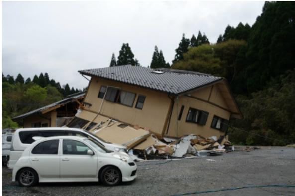
写真 5.3-64 倒壊した木造住宅
