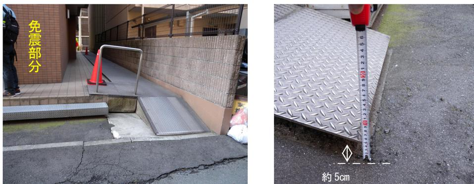
写真 5. 7. 2-58 周囲における地盤沈下の痕跡 (隣接する塀の傾斜、エキスパンション部の隙間)
