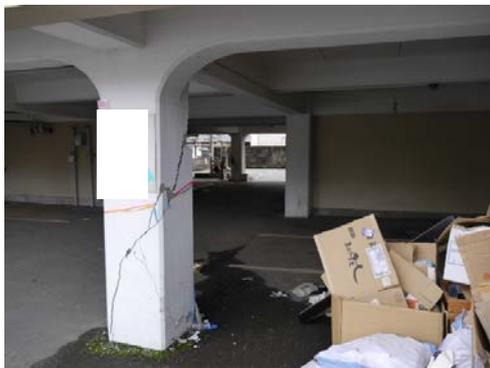
写真5.5-309 建築物北西構面における1階柱のせん断破壊
