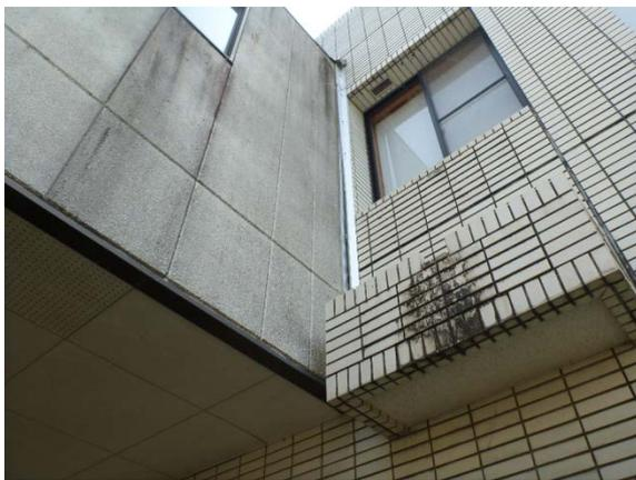
写真5.5-131 エキスパンションジョイント保護カバーの変形（外側）
