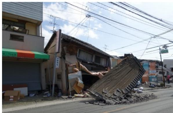
写真5.3-5 倒壊した木造住宅
