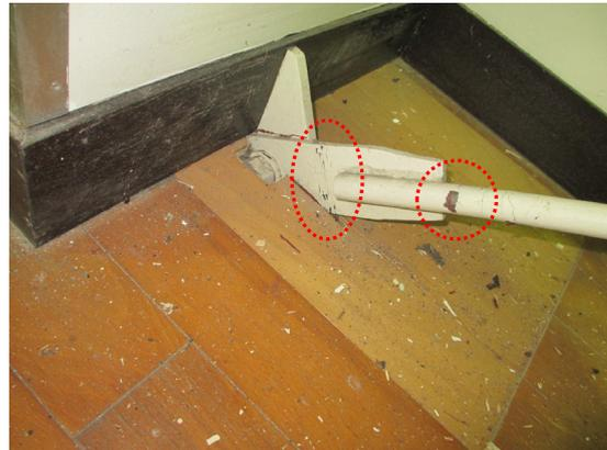
写真 5.4-96 2階ブレース端部の降伏とブレース端部羽子板のわずかな曲がりが見られた
