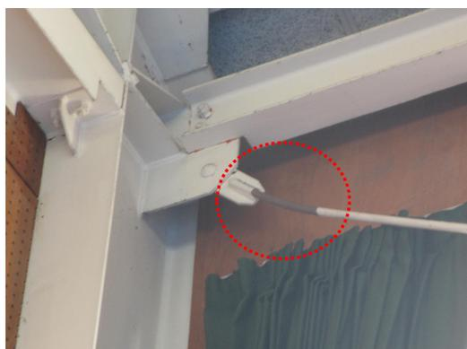
写真 5.4-120 ブレース端部の塑性化の様子
