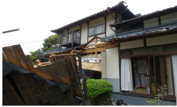
写真 5.3-29 玄関部分が部分破壊した木造住宅
