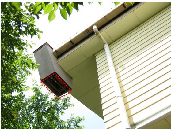
写真 5.4-171 外装材の脱落
