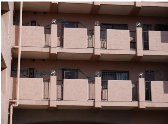
写真5.5-99 共用廊下側の方立壁の損傷
