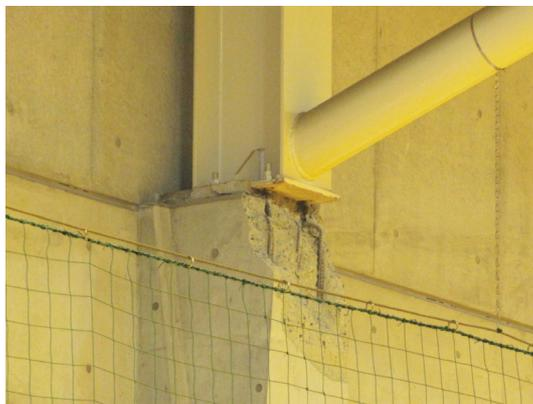
写真 5.4-56 支承部のコンクリートの側方破壊
