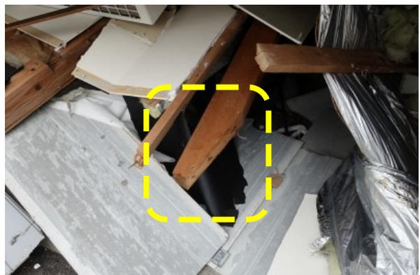
写真 5.3-53 アパート C の筋かい端部 (釘打ち)
