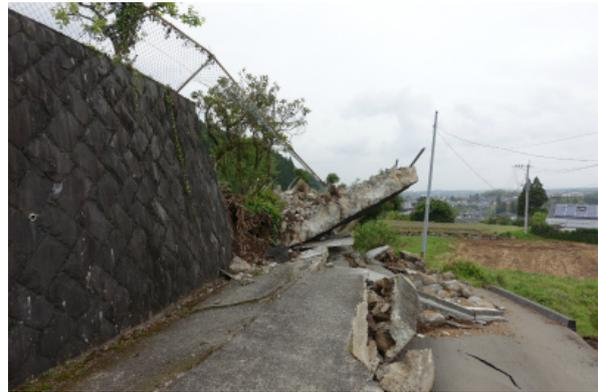
写真 5.3-31 崩壊した擁壁
