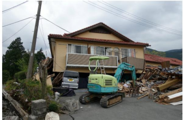
写真 5.3-65 倒壊した木造住宅
