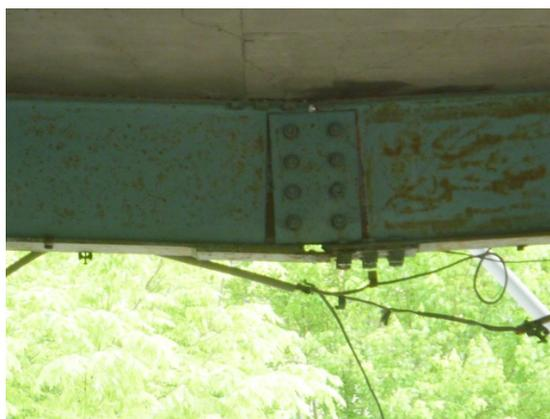
写真 5.4-6 梁下フランジ添え板の孔欠損部破断
