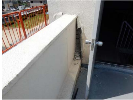
写真5.5-282 3階パラペットの損傷
