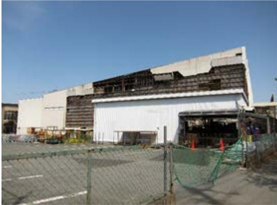
写真 5.8.2-50 湿式工法による壁の脱落
