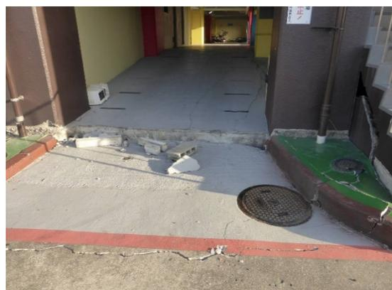
写真5.5-253 地盤変状による建築物と地盤面の段差
