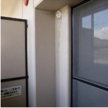
写真5.5-33 バルコニー側柱と袖壁の鉛直ひび割れ
