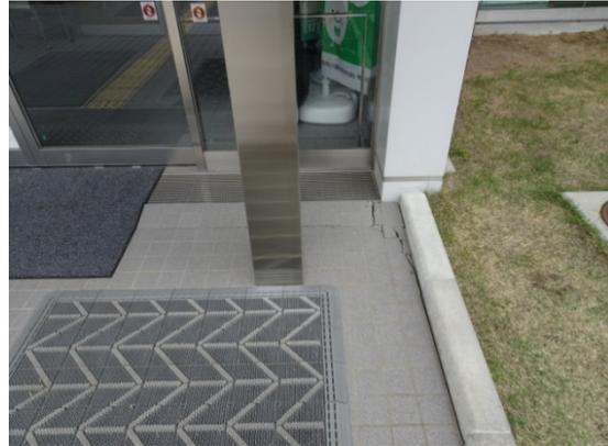
写真5.5-123 エントランス部分の床ひび割れ
