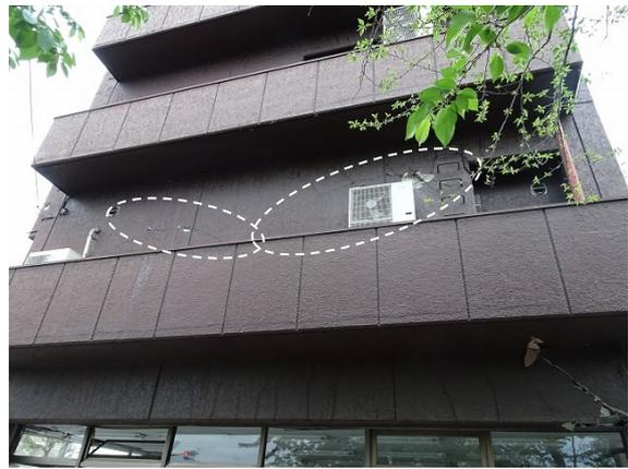
写真5.5-255 耐力壁のせん断ひび割れ (東側)
