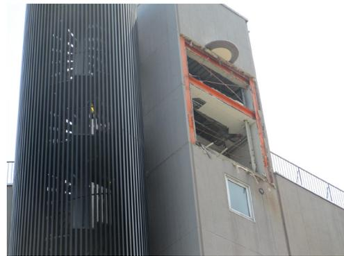
写真 5.4-196 塔屋の外装材の脱落
