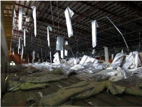
写真 5.8.2-19 天井脱落の状況
