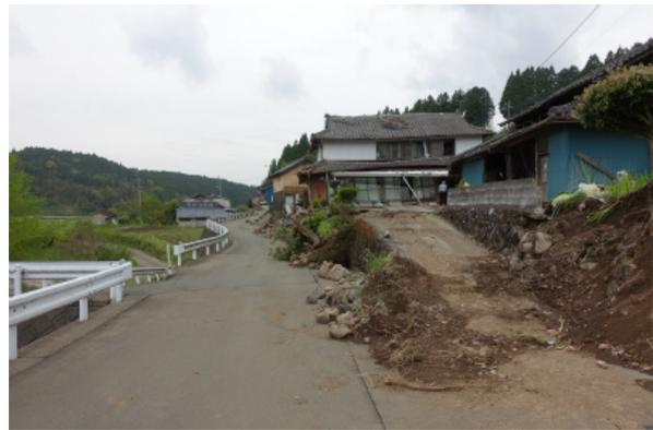
写真 5.3-41 崩壊した擁壁
