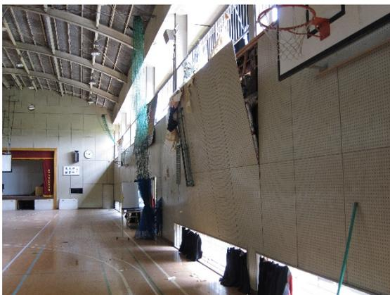
写真 5.4-53 損傷して傾いた内壁
