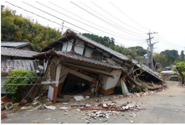
写真 5.3-36 倒壊した木造住宅
