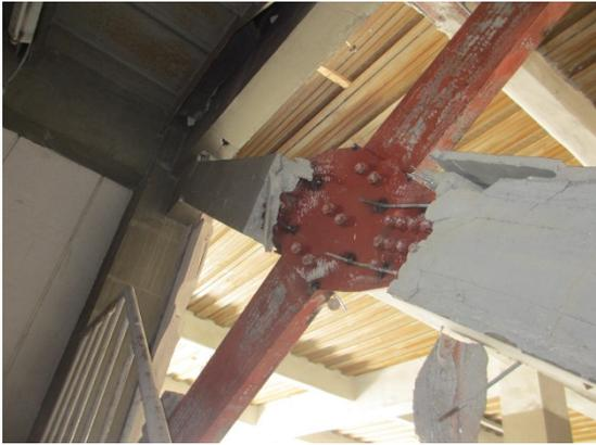
写真 5.4-194 ブレース交差部のガセットプレート接続部の座屈
