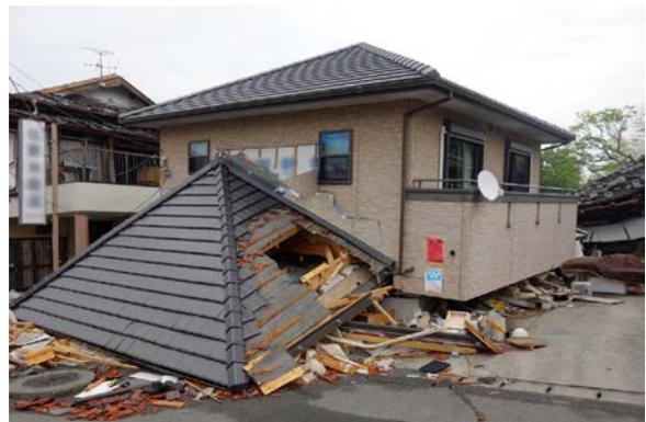
写真 5.6-29 建築年代が新しいと思われる倒壊建築物
