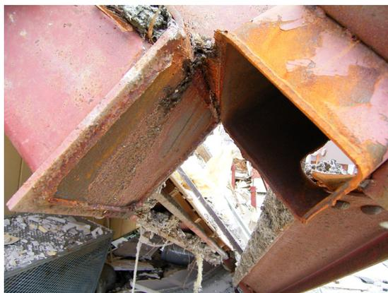
写真 5.4-3 パネルーダイアフラム間の溶接部の破断
