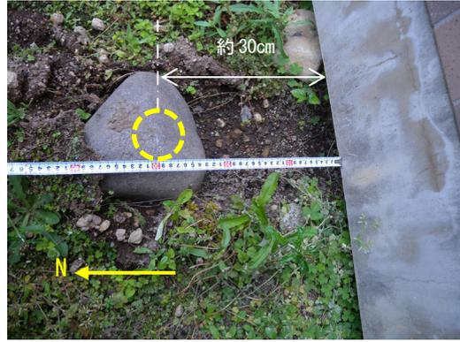
写真 5.7.2-34 免震層周囲の石の移動跡
