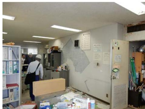
写真5.5-270 仕上げモルタルの剥落
