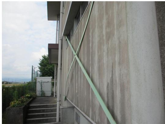
写真 5. 4-127 ブレースのわずかなたわみ
