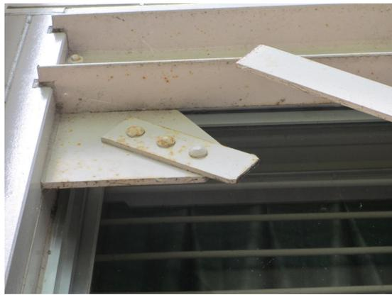
写真 5.4-88 平鋼ブレースの端部での破断 (写真 5.4-87 の拡大)
