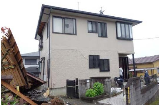
写真 5.6-40 大破と思われるが倒壊には至っていない建築物
