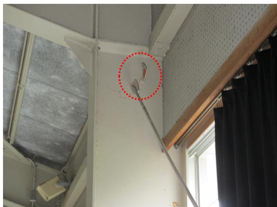
写真 5.4-80 鉛直ブレースのボルト破断
