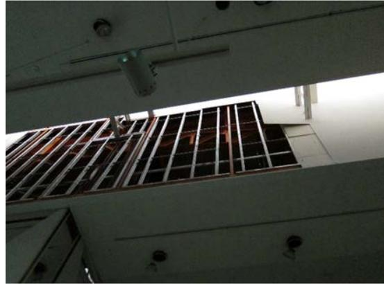
写真 5.8.2-40 吹き抜け部の立ち上がり壁の仕上げ材の脱落
