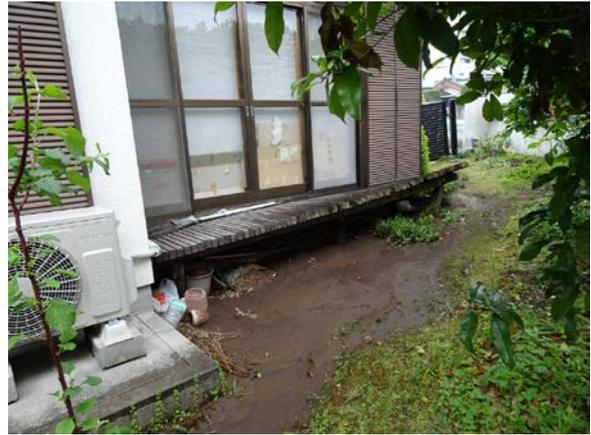
写真 5.6-50 写真 5.6-49 の建築物の縁側部分の沈下状況
