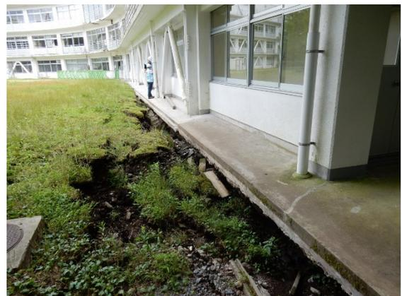
写真5.5-184 建築物北西側における地盤変状
