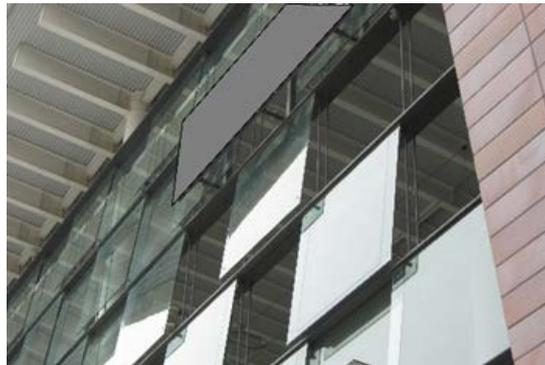
写真 5. 8. 2-38 駅舎のガラスの被害（拡大）
