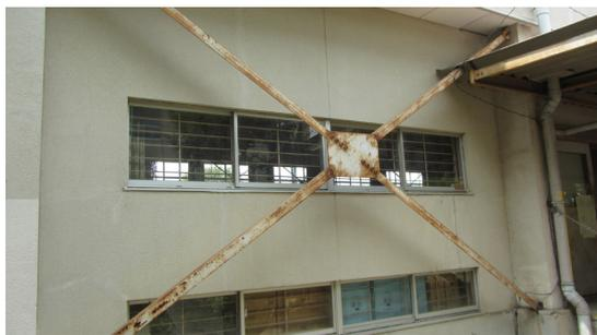
写真 5.4-63 1階鉛直ブレース（被害なし）
