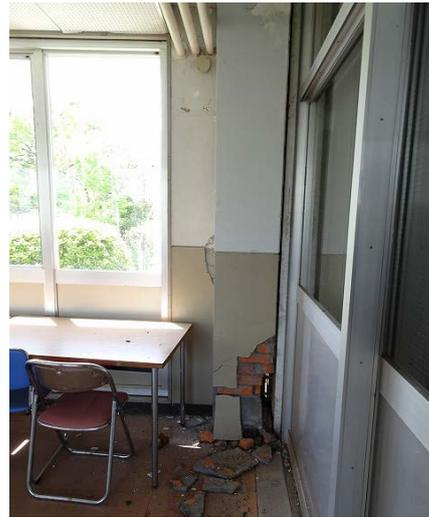
写真5.5-286 エキスパンションジョイント部の破壊
