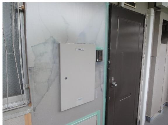
写真 5.8.2-66 方立て壁のせん断被害（等級IV）（RC造、熊本市中央区）
