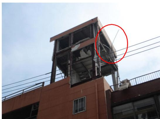
写真 5. 4-201 塔屋のブレースの破断
