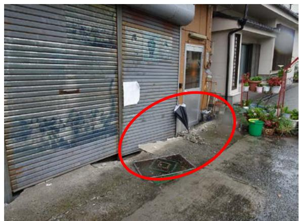
写真 5.6-54 写真 5.6-53 の建築物の1階部分の沈下状況
