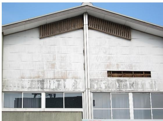
写真 5.4-136 妻面の外装材の脱落
