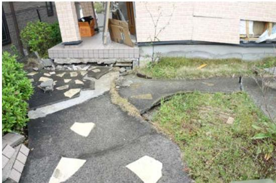
写真 5.6-38 写真 5.6-37 の建築物の周辺地盤。変状は認められるが、基礎の損傷は見えない。
