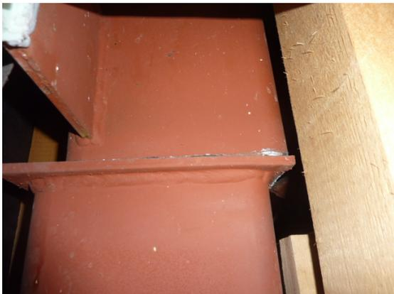
写真 5.4-20 パネルとダイアフラム間の溶接部の破断
