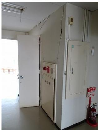
写真5.5-168 非構造壁の損傷
