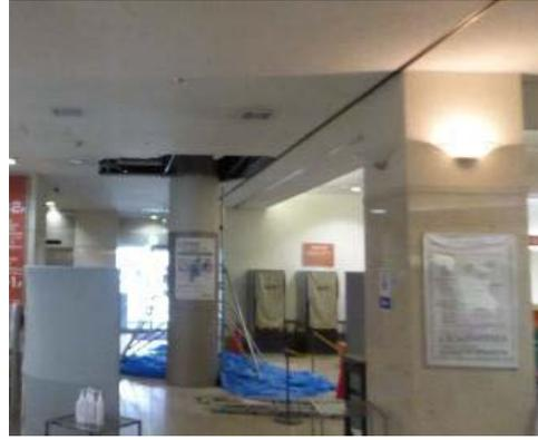
写真5.5-108 天井仕上げ材の脱落（南側病棟）
