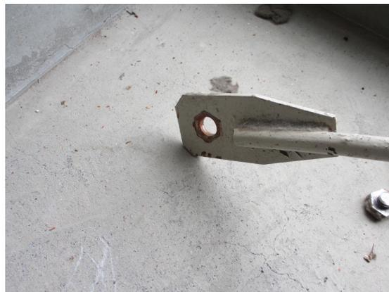
写真 5.4-81 鉛直ブレースのボルト破断
