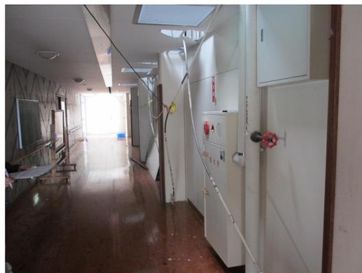
写真 5.4-119 1階の大きくたわんで変形したブレース
