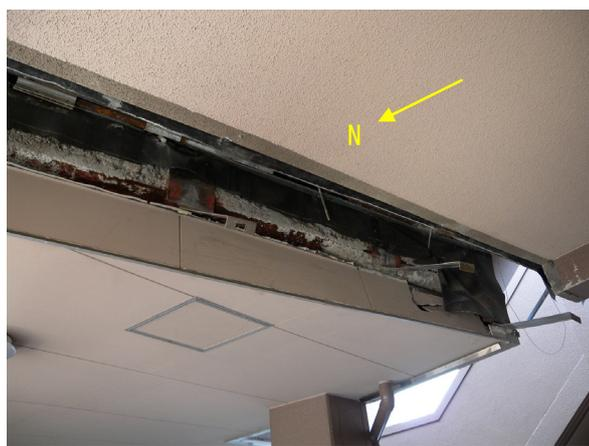
また、A棟の積層ゴム支承で、北に3cm程度の残留変位が観察された（写真5.7.2-38）。この建築物では免震層の定期的な点検の一環として下げ振りをを用いた変位の観測を実施しており、管理会社によれば直近の点検時（約一か月前、3月）にはほぼ原点を示していたとのことで、この残留変位は今回の一連の地震で生じたものと考えられる。
