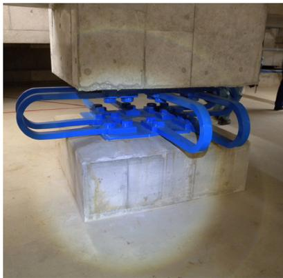
写真 5. 7. 2-26 U形鋼材ダンパーの状況
