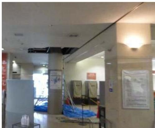
写真 5.8.2-23 天井仕上げ材の脱落 (南側病棟)
