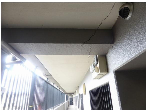
写真5.5-82 1階エントランスホールと住棟本体をつなぐ小梁およびその周辺スラブに生じた曲げひび割れ
