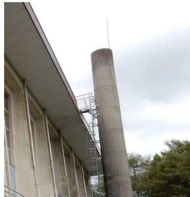
写真5.5-191 隣接する煙突の梯子の変形
