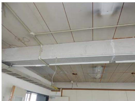
写真5.5-273 大梁のスパン中央付近のひび割れ
