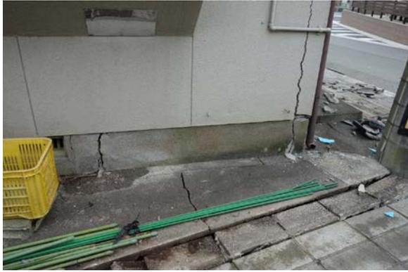
写真 5.6-5 写真 5.6-4 の基礎のひび割れ及び地盤変状を確認
