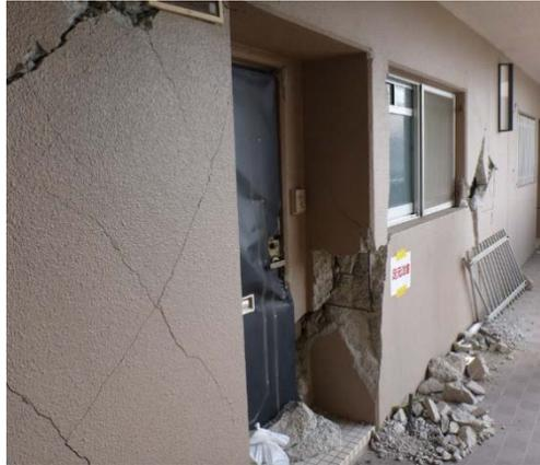
写真5.5-19 2階共用廊下側の方立壁の被害
