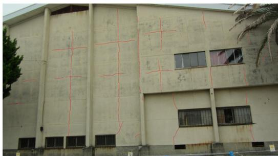
写真 5.4-107 舞台裏妻面（仕上げモルタルにひび割れ（赤線））
