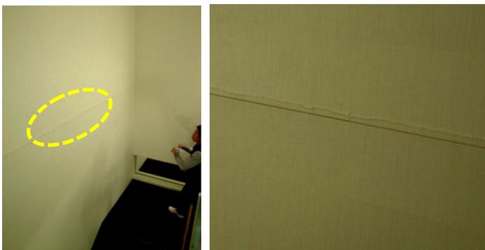
写真5.7.2-12 階段室の内装クロスの上り及び4階の窓サッシ部金具のずれ
