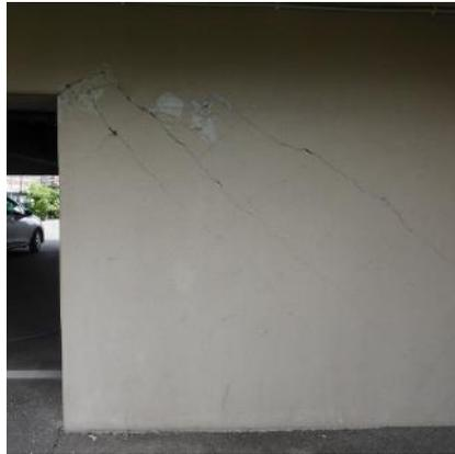
写真5.5-35 1階桁行方向耐力壁のせん断ひび割れ
