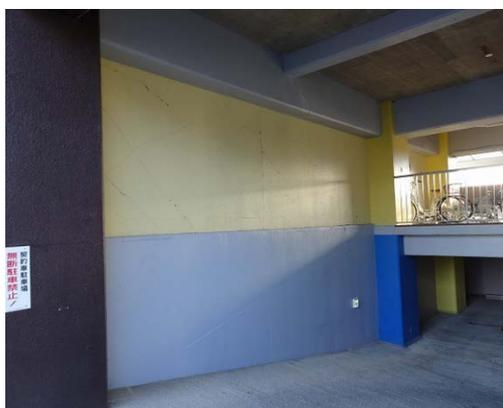
写真5.5-252 1階張間方向の耐力壁のせん断ひび割れ
