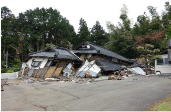
写真 5.3-38 倒壊した木造住宅
