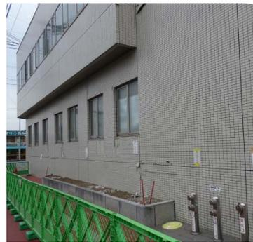
写真5.5-106 外壁タイルの剥落
