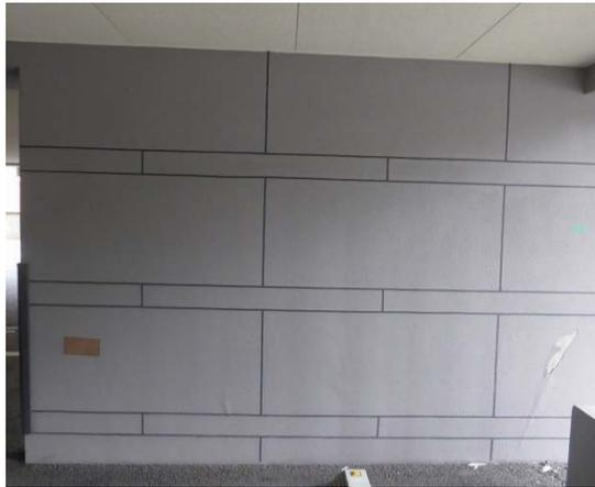
写真5.5-43 1階柱の張間方向に取付く袖壁
