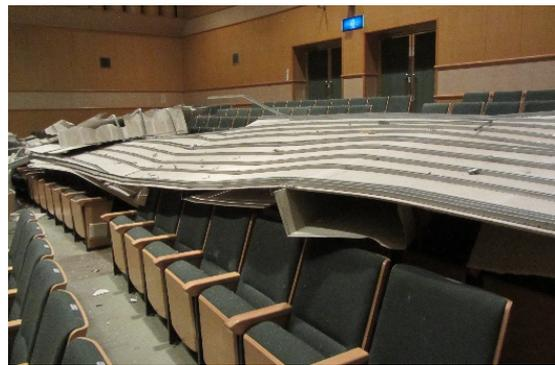
写真 5.8.2-6 脱落した天井面
