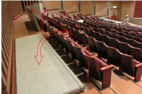
写真 5.8.2-49 最後方の客席とその後ろの通路を隔てる壁の転倒
