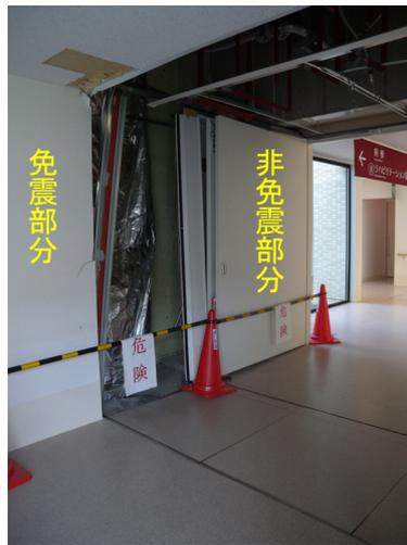
写真 5.7.2-4 破損したエキスパンションカバー（撤去済み）
