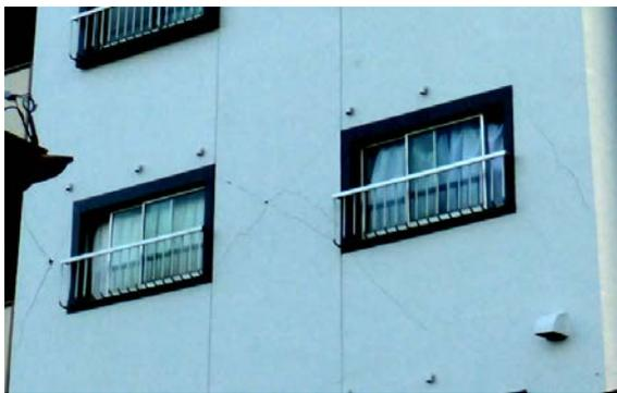
写真5.5-244 張間方向2階の耐力壁と思われる耐力壁のせん断ひび割れ
