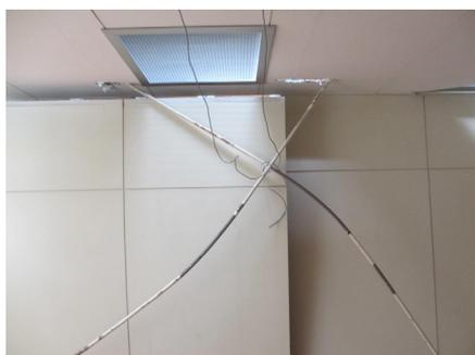
写真 5.4-122 ブレースの変形状況
