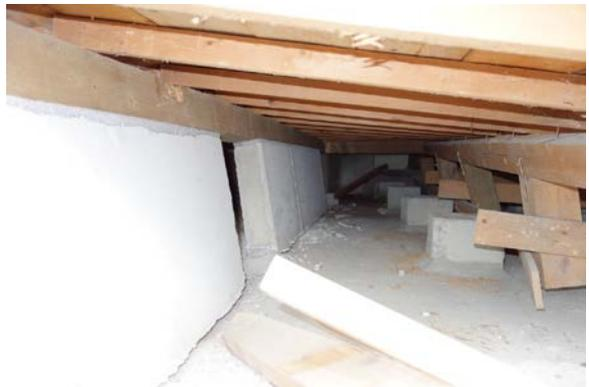
写真 5.6-33 写真 5.6-32 の建築物の基礎。床束は全て外れ、基礎は立ち上がり部で曲げ破壊が生じている。
