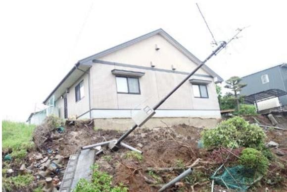
写真 5.6-25 軽微・無被害に見える建築物。擁壁は崩落、基礎に損傷なし（写真 5.6-23 より南の建築物）。
