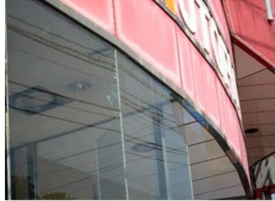
写真 5. 8. 2-36 大判ガラスの損傷
