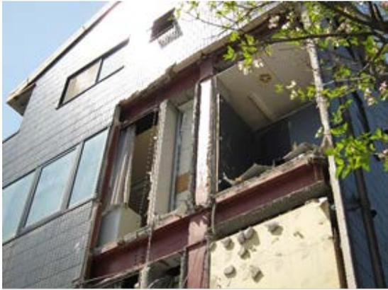
写真 5. 8. 2-54 乾式工法による外壁の脱落
