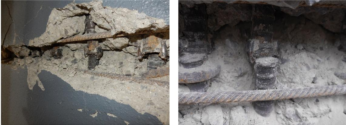
写真5.5-11 主筋破断部の拡大
