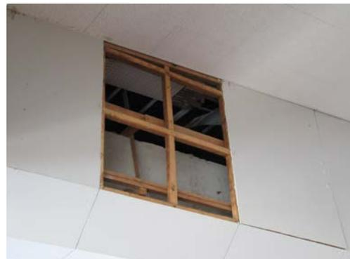
写真 5. 8. 2-88 アリーナ壁面破損状況
