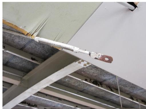
写真 5. 4-48 屋根面水平ブレースのボルト破断
