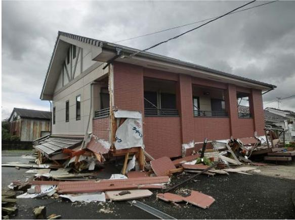
写真5.3-20 倒壊した木造住宅
