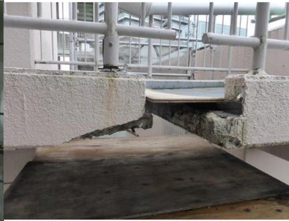
写真5.5-70 エキスパンションジョイント部の損傷・脱落
