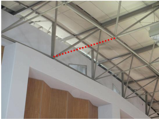
写真 5.4-182 体育館Nのトラス屋根の下弦材の落下
