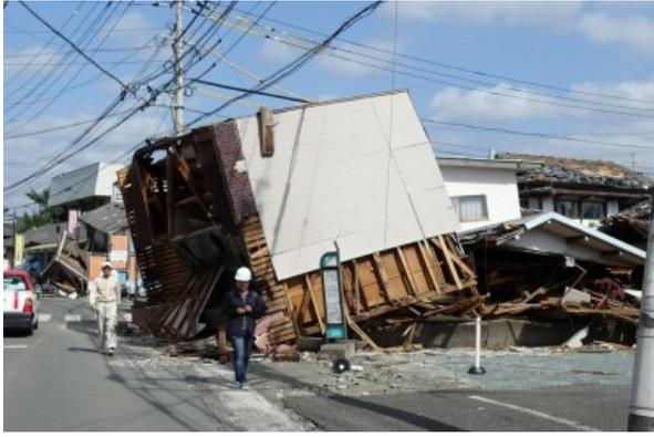
写真 5.3-6 倒壊した店舗併用木造住宅
