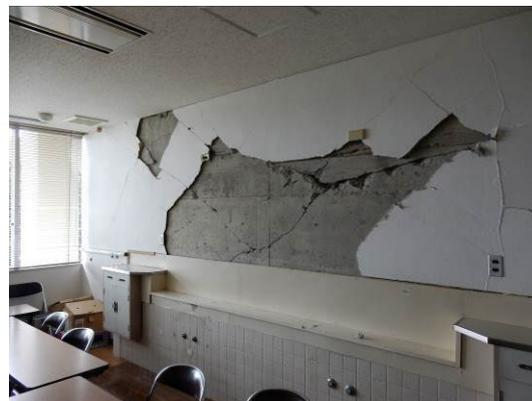
写真5.5-173 耐力壁のせん断ひび割れ
