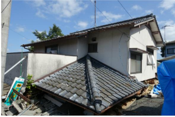
写真 5.3-14 倒壊した木造住宅
