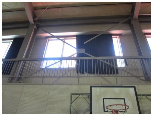
写真 5. 4-164 2階のブレースの破断
