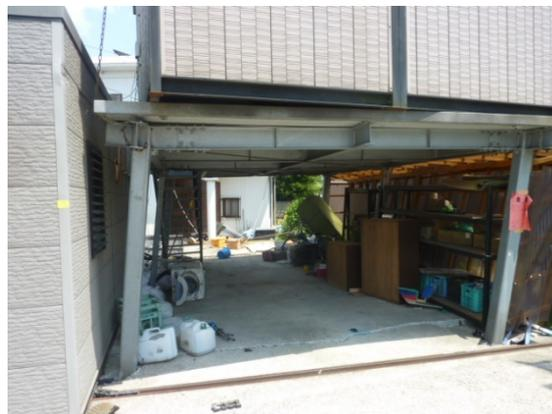
写真 5. 4-40 柱の傾斜
