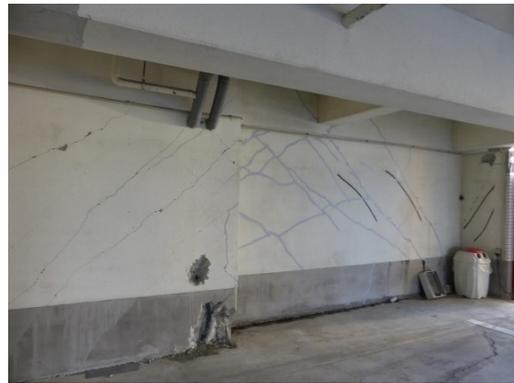
写真5.5-49 桁行方向構面外の非構造壁
