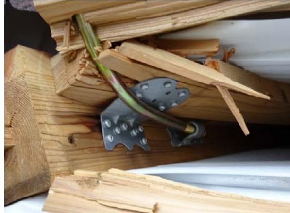
写真 5.3-19 写真 5.3-18 の建物の筋かい端部、
