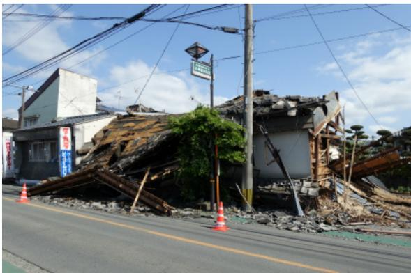
写真5.3-4 倒壊した木造住宅
