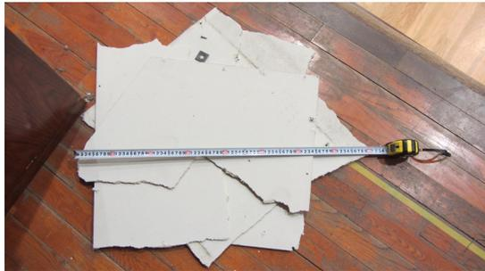
写真 5.4-103 落下した舞台上部内壁の仕上げ材
