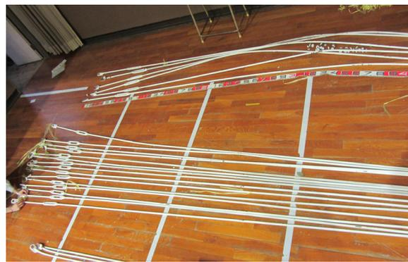
写真 5. 4-100 撤去された屋根面の水平ブレース
