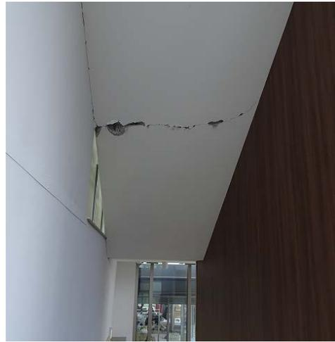
写真5.5-127 階段底面に見られたひび割れ
