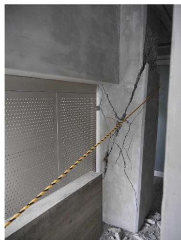
写真5.5-264 2階柱のせん断破壊
