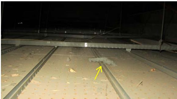
写真 5. 8. 2-85 アリーナ上部吊り天井裏落下物
