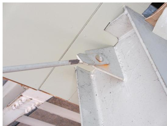
写真 5. 4-46 ガセットプレートの曲がり
