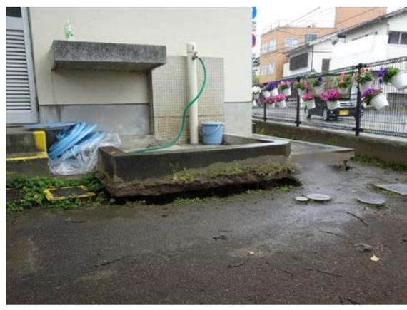
写真 5.6-58 小学校校舎の周辺地盤の沈下状況（熊本市南区近見）
