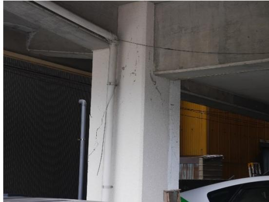
写真5.5-229 隣接建築物のピロティ柱のせん断ひび割れ
