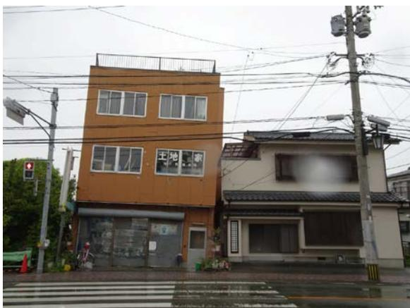
写真 5.6-53 地盤の液状化により沈下・傾斜したと思われる3階建て商用建築物
