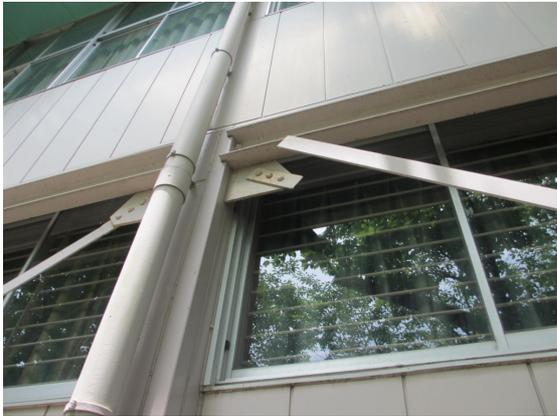
写真 5.4-87 平鋼ブレースの端部での破断
