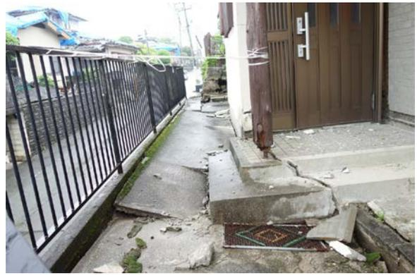
写真 5.6-24 写真 5.6-23 の建築物周辺地盤の様子。盛土擁壁に変位した形跡あり。
