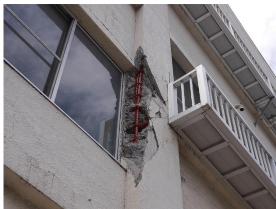
写真5.5-302 2階柱のコンクリートの剥落
