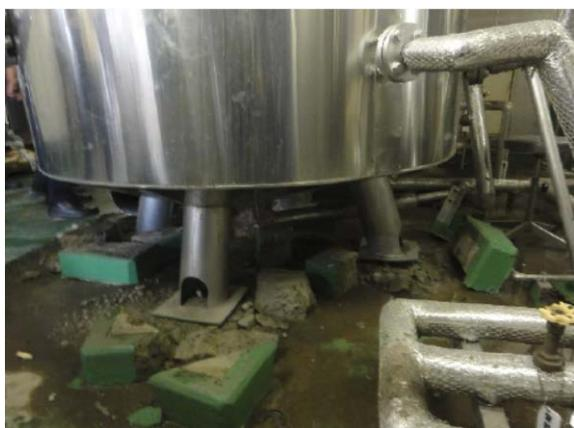
写真 5.8.3-9 機械室内貯湯槽の基礎部の損傷
