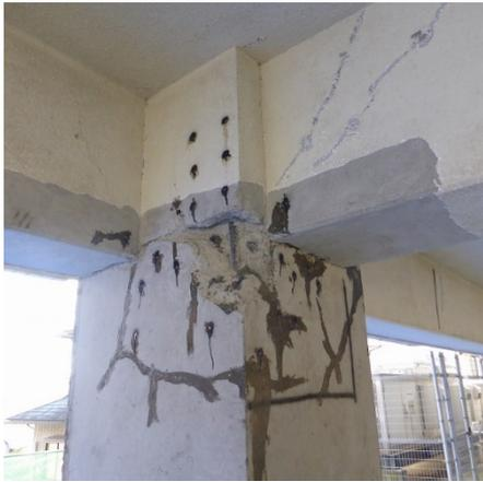
写真5.5-46 1階柱頭のコンクリート剥落
