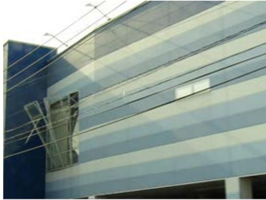
写真 5.8.2-31 窓サッシの損傷・外れ（熊本市）
