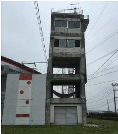
写真5.5-24 本震後の主訓練塔の被災状況
