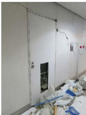
写真 5.8.2-61 戸枠の歪みにより開放できなくなった防火戸（益城町、RC+S 造）
