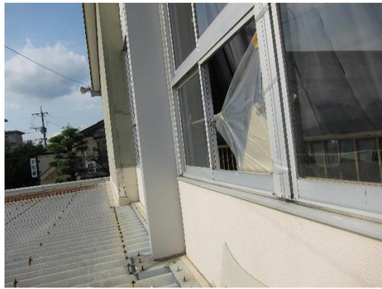
写真 5. 8. 2-34 妻面の窓ガラスの損傷
