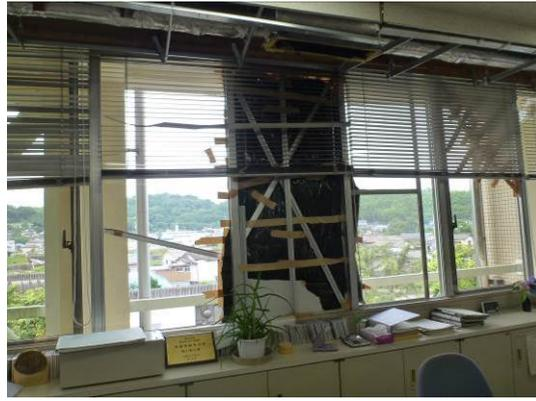
写真5.5-175 窓ガラスの破損
