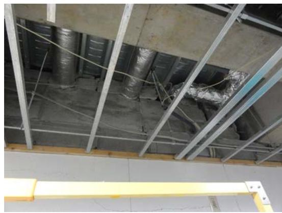
写真 5.8.2-42 ブロック壁（天井裏界壁）の被害
