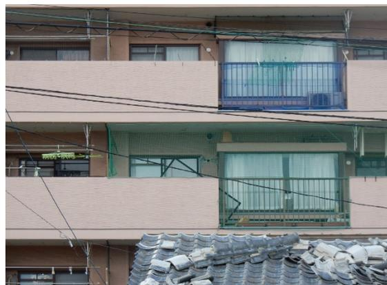
写真5.5-100 バルコニー側の方立壁の損傷
