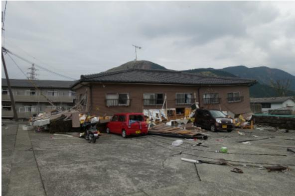
写真 5.3-56 倒壊した木造アパート E
