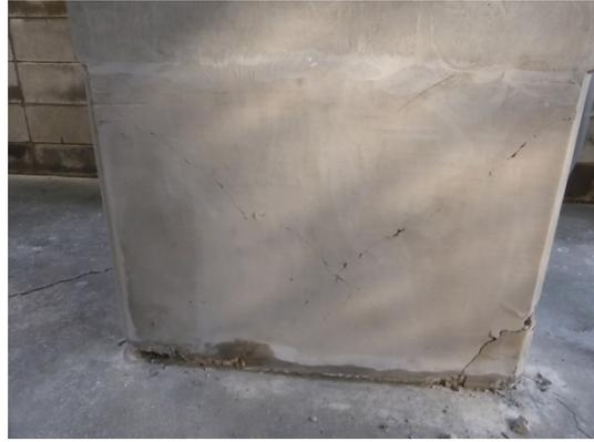
写真5.5-47 1階柱脚のせん断ひび割れ
