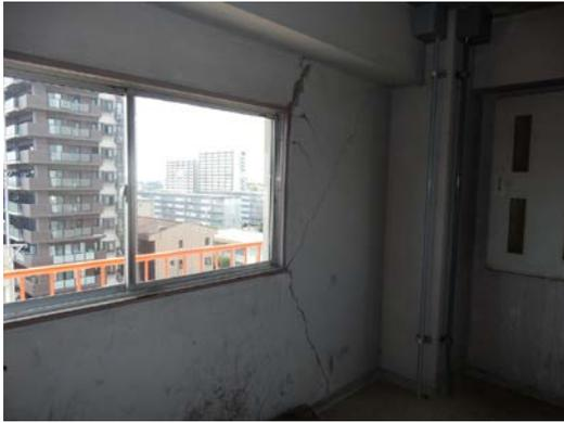
写真5.5-281 訓練塔の非構造壁のひび割れ
