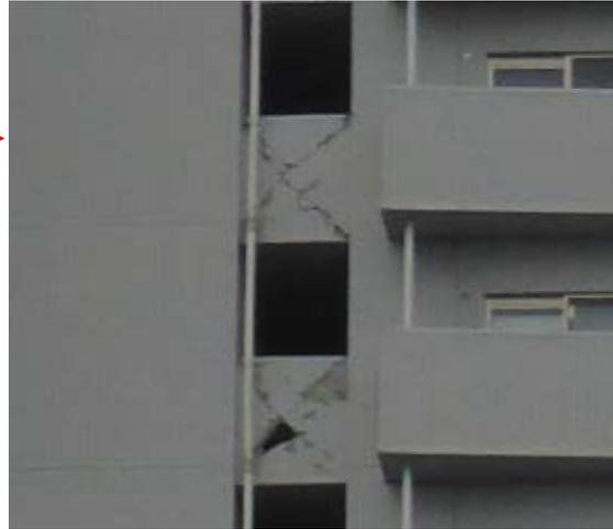
写真5.5-104 廊下手摺壁のせん断破壊
