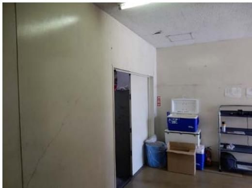
写真5.5-280 耐力壁のせん断ひび割れ
