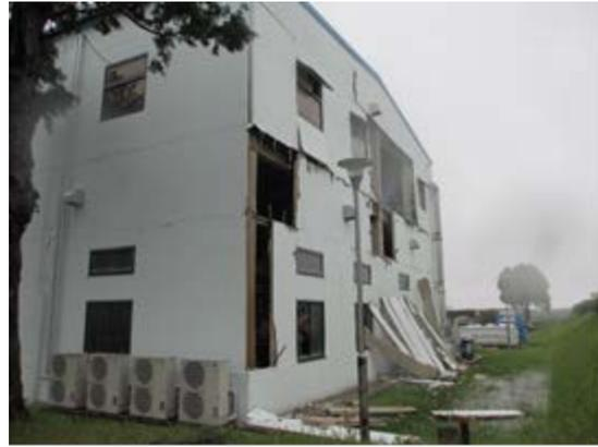
写真 5. 8. 2-55 工場の外壁の被害
