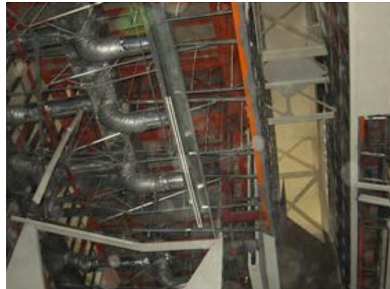
写真5.8.2-12 天井裏の状況（天井脱落箇所）
