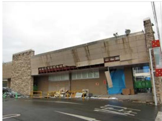
写真 5. 8. 2-57 外壁の損傷・傾斜
