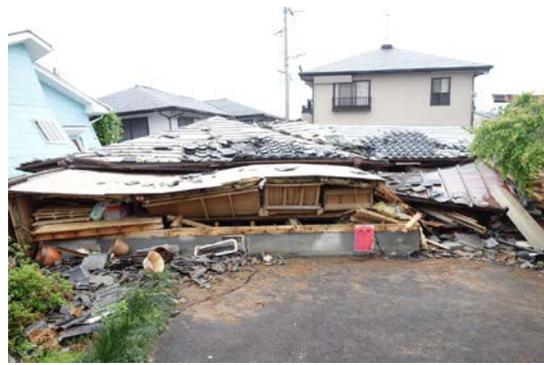
写真 5.6-39 被害の大きい建築物。周辺地盤の変状が認められ、基礎の損傷も認められる。
