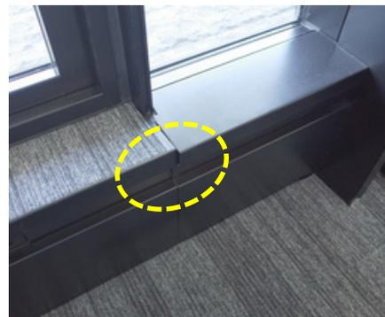
写真5.7.2-13 窓サッシ部金具のずれ
