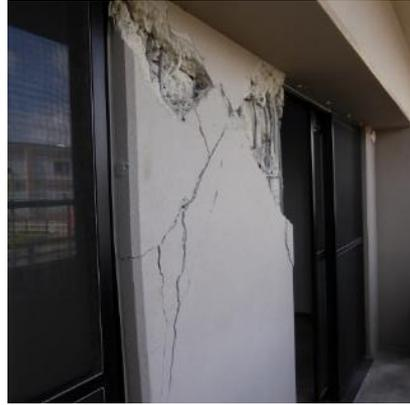
写真5.5-34 バルコニー側方立て壁のせん断破壊
