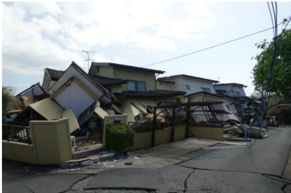
写真 5.3-16 倒壊した木造住宅
