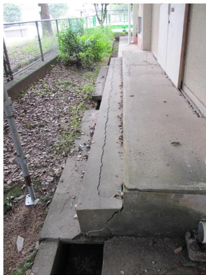
写真 5.4-52 周辺地盤の沈下
