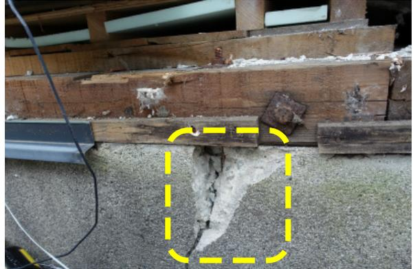
写真 5.3-49 アパート B の基礎亀裂部
