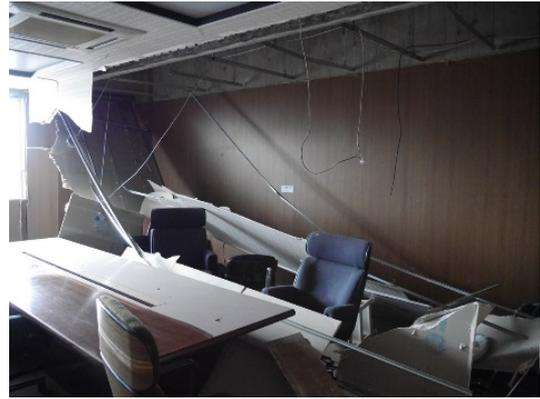
写真5.5-266 天井材の落下被害
