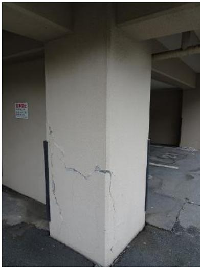
写真5.5-54 1階柱のひび割れ
