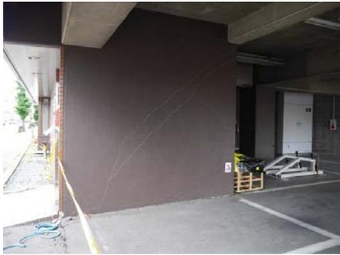
写真5.5-248 1階耐力壁のせん断ひび割れ
