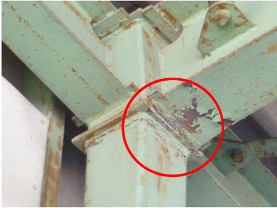
写真 5.4-33 梁端溶接部の破断
