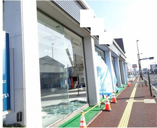
写真5.5-216 隣接店舗はガラス破損のみ
