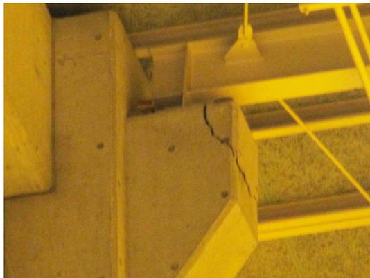
写真 5.4-58 支承部のコンクリートのひび割れ
