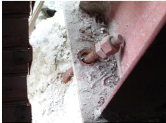
写真 5.4-17 柱脚部の損傷状況
