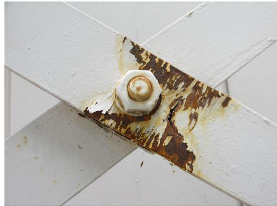
写真 5.4-92 ブレース交差部の塑性化と破断
