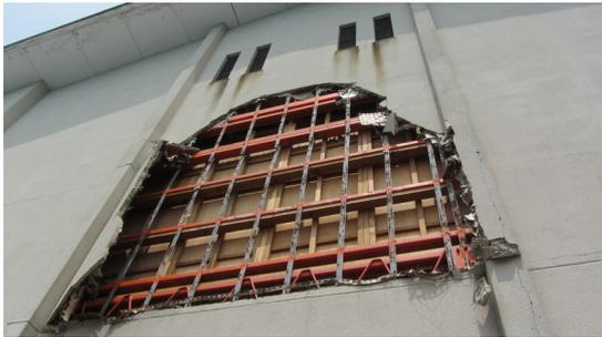
写真 5.4-69 舞台裏 ラスモルタル外壁の落下
