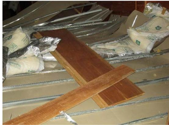
写真 5.8.2-20 脱落した天井材
