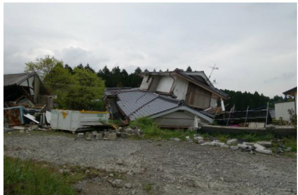
写真 5.3-67 倒壊した木造住宅
