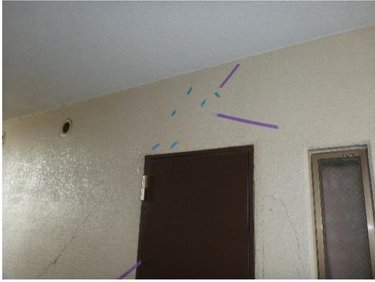
写真5.5-62 ドア開口上の大梁のひび割れ
