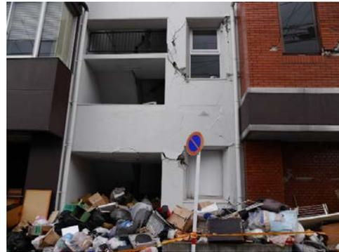
写真5.5-249 2階階段室の柱の損傷
