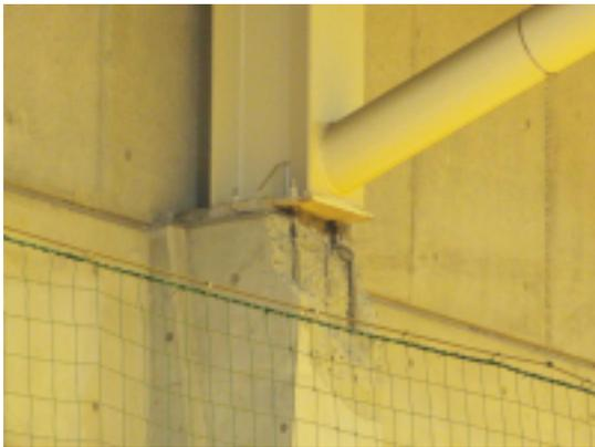
写真 5.4-184 体育館Bの屋根支承部のコンクリートの側方破壊
