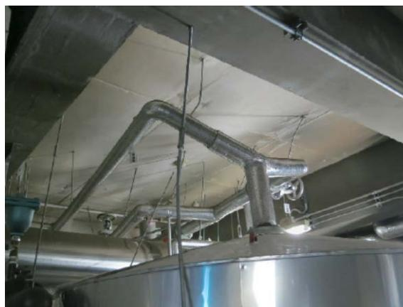
写真 5.8.3-10 機械室内貯湯槽の配管の損傷
