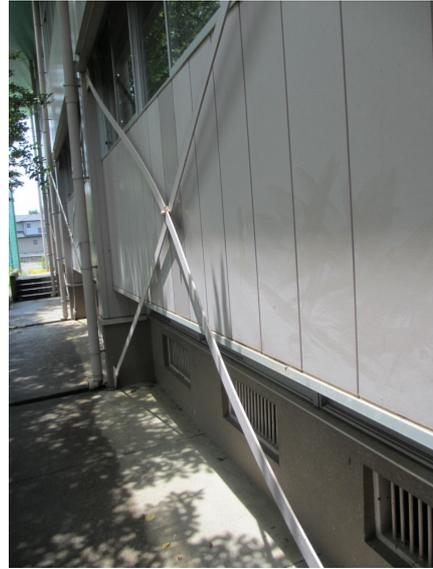
写真 5.4-86 平鋼ブレースのたわみ
