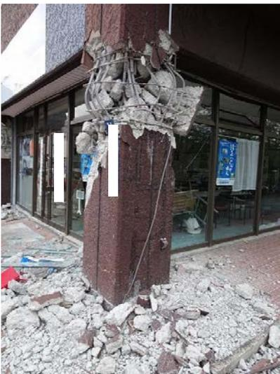
写真5.5-256 1 階柱の大破 (南東側)
