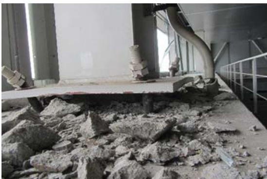
写真 5.8.2-44 屋根支承部の被害 (d ホール)
