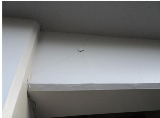
写真5.5-245 桁行方向の梁端のせん断ひび割れ
