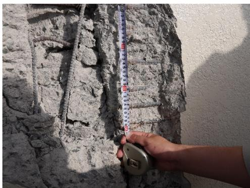
写真5.5-26 柱帯筋の配筋
