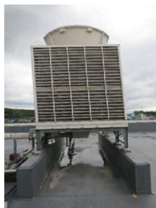
(b) 基礎部分から傾斜した冷却塔
