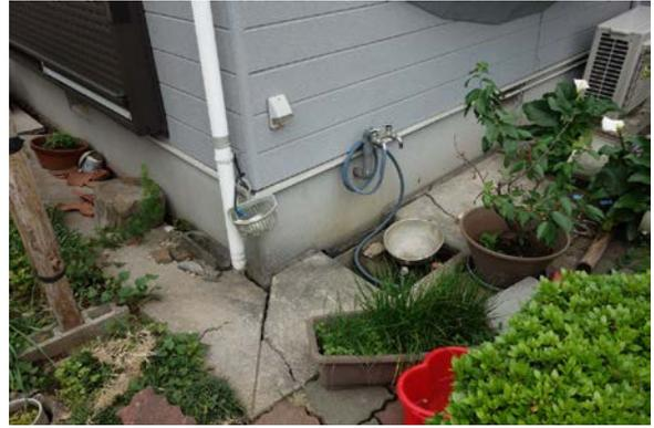
写真 5.6-15 写真 5.6-14 の基礎周りの様子。地盤変状が生じていると思われる損傷が見られる。
