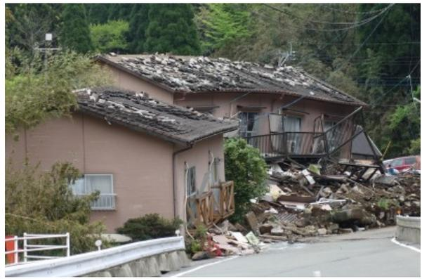
写真 5.3-63 倒壊した木造アパート
