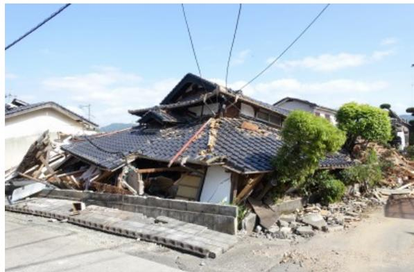
写真5.3-3 倒壊した木造住宅
