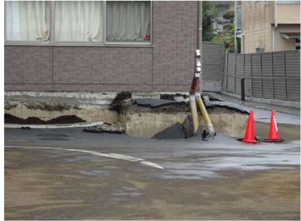
写真 5.6-56 写真 5.6-55 の建築物の周辺地盤の沈下状況（平成 28 年 4 月 23 日午後撮影）
