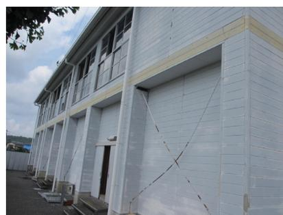
写真 5.4-123 1階のブレースの様子
