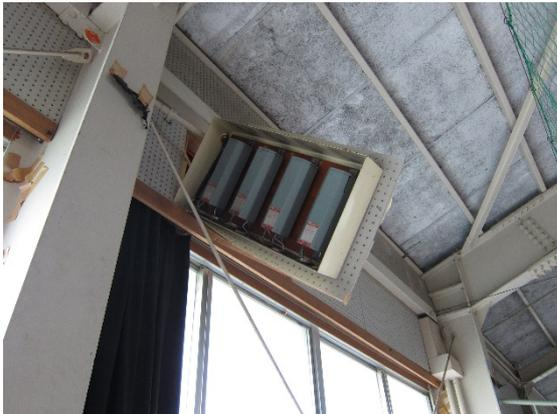
写真 5.4-84 安定器を留め付けた板の外れ
