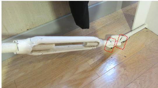
写真 5.4-76 鉛直ブレース（2階）の軸部及び羽子板の変形
