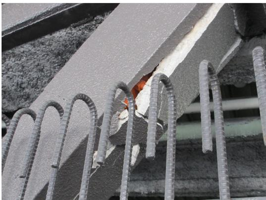
写真 5.4-197 ブレース端部の耐火被覆の亀裂
