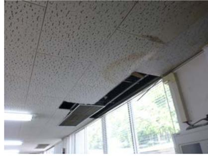
写真5.5-276 天井材の脱落
