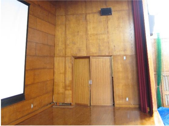
写真 5. 4-124 舞台壁の損傷、引き戸の外れ
