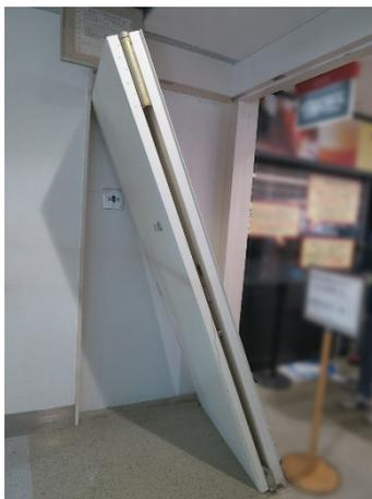
写真 5.8.2-60 ヒンジから脱落した防火戸（益城町、RC+S 造）
