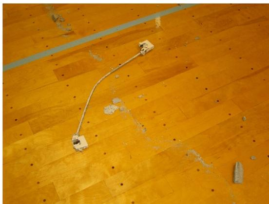
写真 5.4-60 落下した吊り金具
