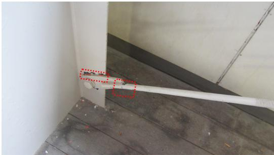
写真 5.4-113 2階鉛直ブレース下端接合部
