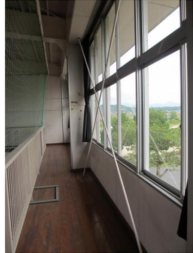
写真 5.4-129 2階のブレースのわずかなたわみ
