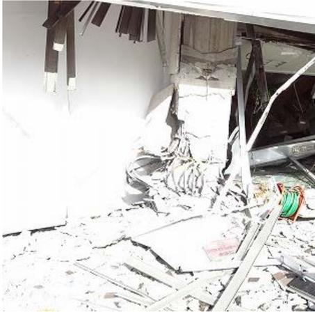
写真5.5-215 柱の軸崩壊、鉄筋座屈
