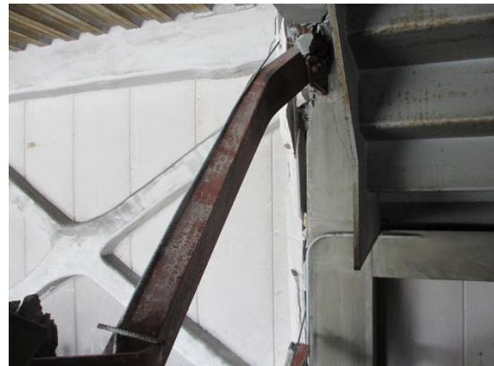
写真 5.4-193 溝形鋼ブレース端部の座屈
