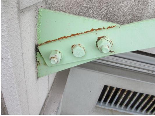
写真 5.4-128 ブレース接合部におけるブレースのわずかな滑り
