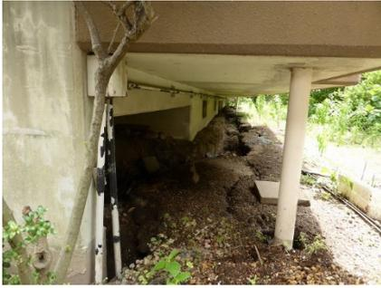
写真5.5-92 建築部外周部の地盤の亀裂
