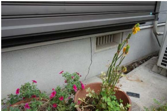
写真 5.6-16 写真 5.6-14 の建築物の基礎の様子。ひび割れを確認
