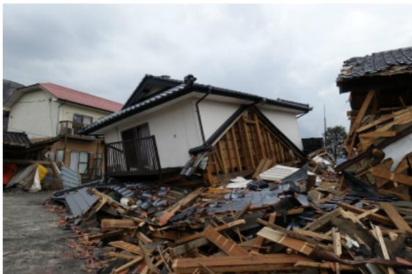
写真 5.3-66 倒壊した木造住宅
