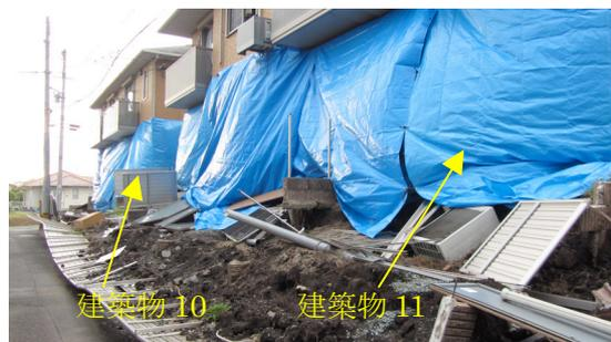
写真 5.4-24 宅地擁壁部分の崩壊
