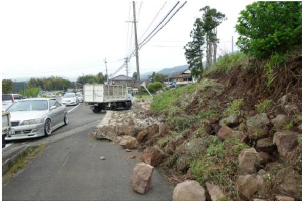
写真 5.3-30 崩壊した擁壁
