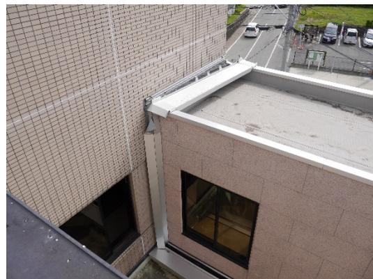
写真5.5-116 エキスパンションジョイントの破損
