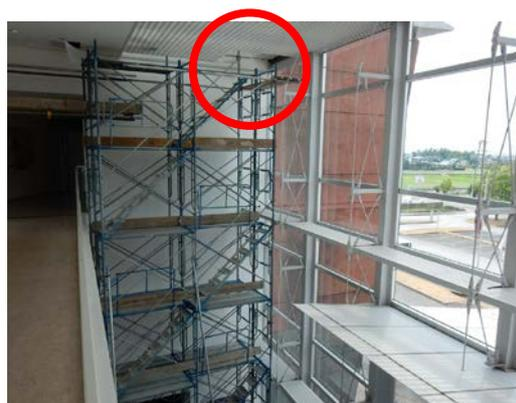
写真5.5-120 エントランス屋根上の鉄骨梁を支える RC 造コーベルの損傷
