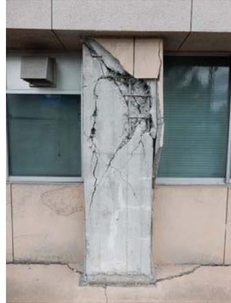
写真5.5-306 1階柱のせん断破壊
