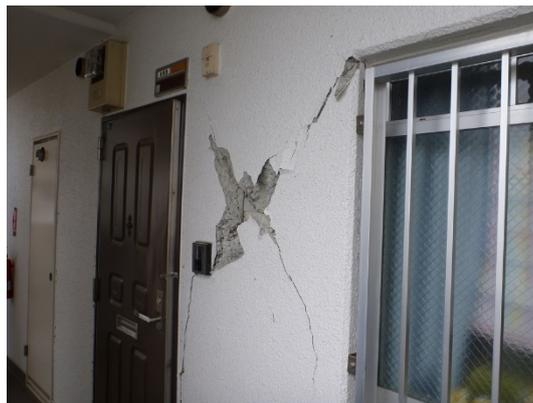
写真5.5-65 桁行方向の共用廊下側の構面における方立壁の被害
