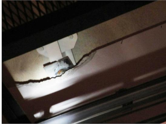
写真 5.8.2-48 ステージ上の下屋の支承部コンクリートの破損、落下
