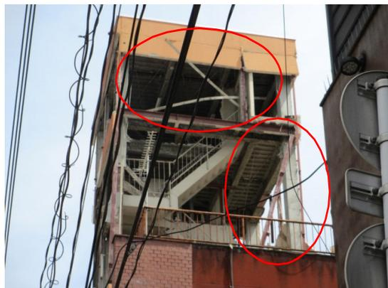
写真 5. 4-200 塔屋のブレースの破断
