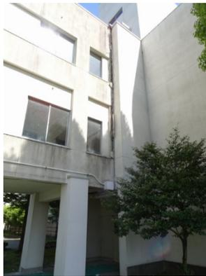
写真5.5-291 渡り廊下エクspansionジョイント部の破壊
