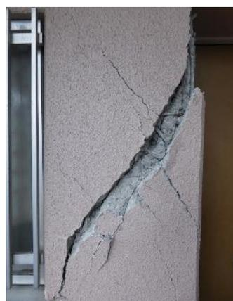
写真5.5-68 方立て壁のせん断破壊
