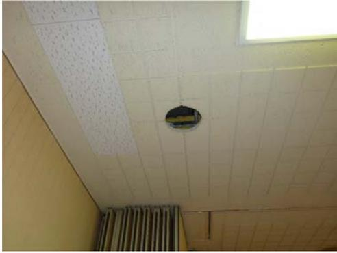
写真5.5-135 天井材の脱落
