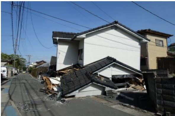
写真 5.3-10 倒壊した木造住宅
