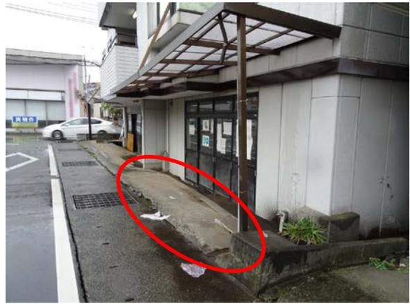
写真 5.6-61 写真 5.6-60 の建築物の 1 階部分の沈下状況
