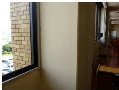
写真5.5-134 腰壁付き柱の曲げひび割れ
