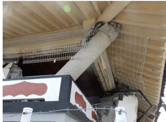
写真5.5-226 柱頭部の配筋
