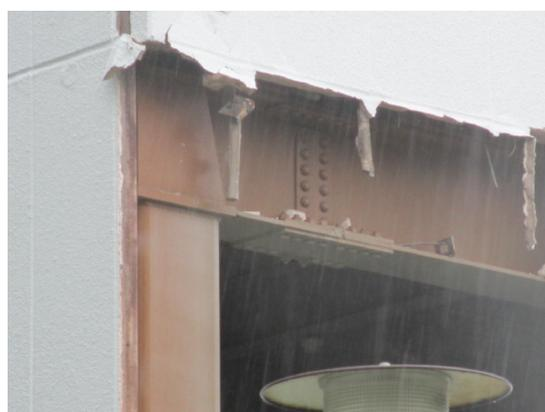
写真 5. 4-204 外壁落下で露出した柱梁接合部
