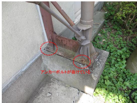
写真 5. 4-150 柱脚のアンカーボルトの破断
