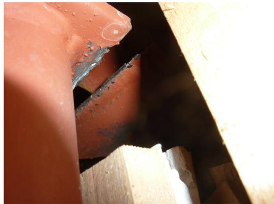
写真 5.4-19 梁端破断
