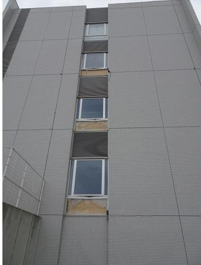
写真 5.8.2-28 境界梁部分にある窓ガラスの破損・落下
