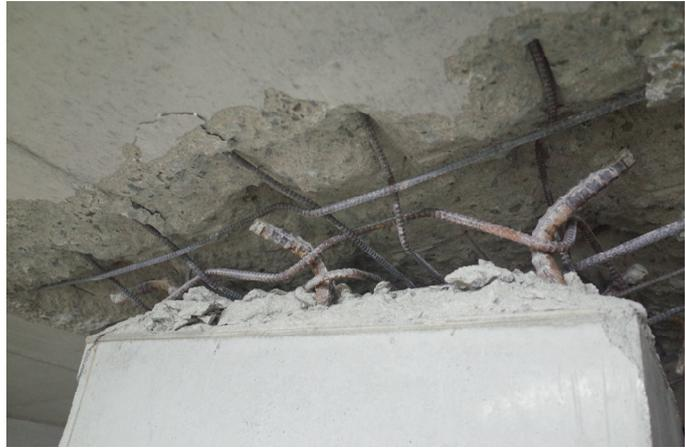
写真 5. 7. 2-50 鉛ダンパー取付け基部の損傷
