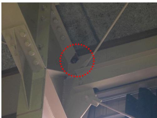
写真 5.4-135 取り替えられていない屋根面水平ブレースのボルト破断
