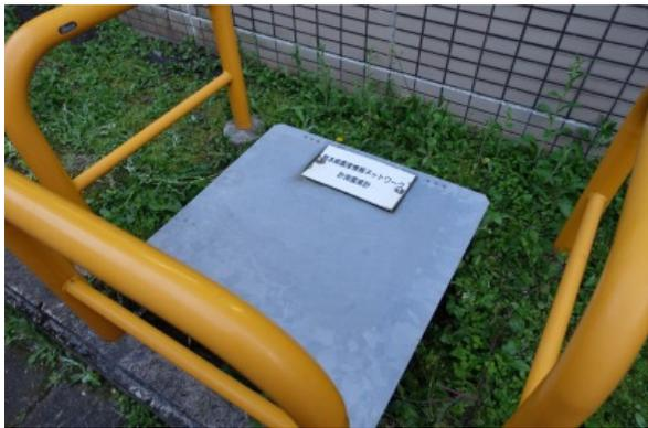
写真 5.3-25 震度計の設置状況
