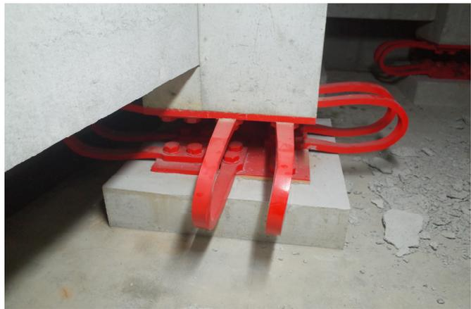
写真 5. 7. 2-51 鋼材ダンパー取付け
