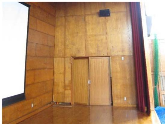
写真 5.8.2-43 舞台壁の損傷、引き戸の外れ
