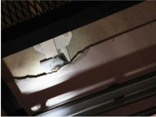
写真 5.4-186 体育館Nのステージ上の屋根支承部のコンクリートの破壊
