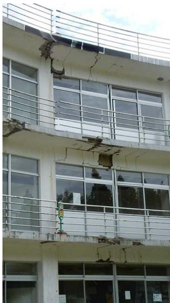
写真5.5-185 大梁の破壊
