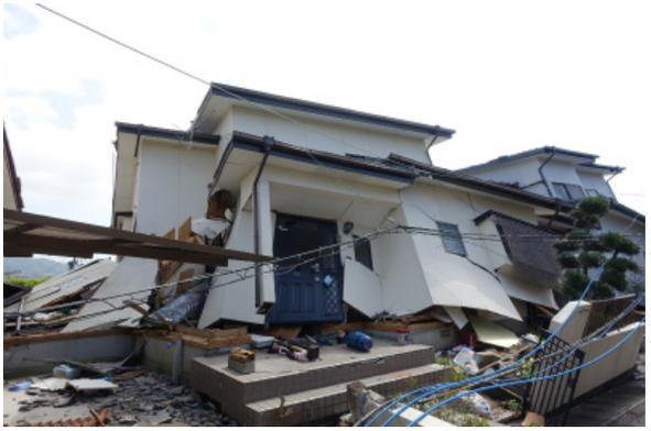
写真 5.3-8 倒壊した木造住宅
