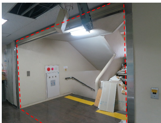
写真 5. 8. 2-64 自動閉鎖したのち開放できなくなっていた防火シャッター（RC 造、御船町）
