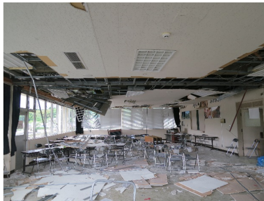
写真 5.8.2-24 天井材の被害
