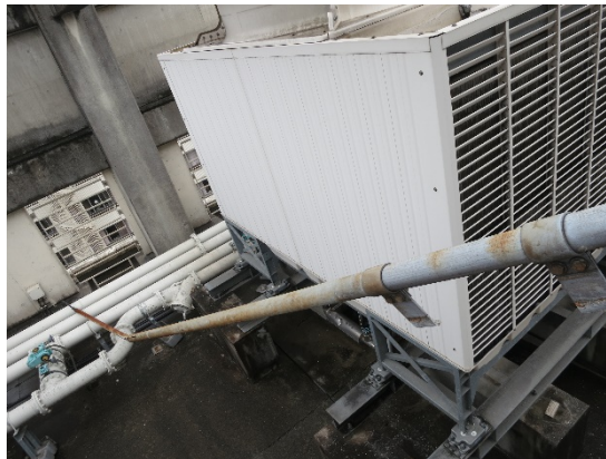
写真 5.8.3-17 病院Aにおける支持部の破損により転倒した避雷針
