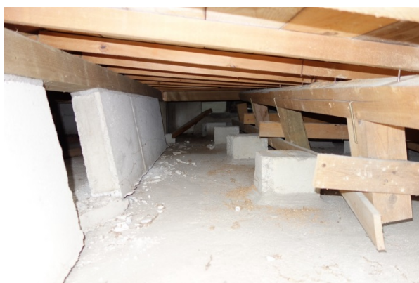
写真 5. 6-44 地盤変状が認められ、基礎に損傷が著しい事例 1
