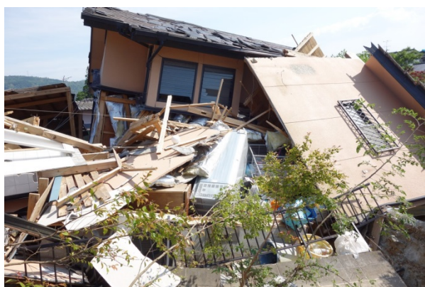
写真 5. 6-45 地盤変状が認められ、基礎に損傷が著しい事例 2
