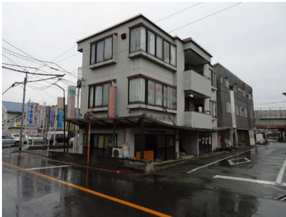
写真 5.6-60 地盤の液状化により沈下・傾斜したと思われる 3 階建て店舗併用住宅
