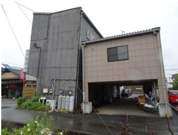
写真 5.6-62 地盤の液状化によると思われる隣接建築物同士が近づくような傾斜形態
