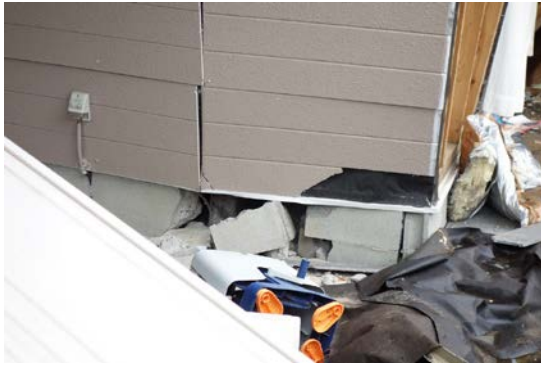
写真 5.6-36 写真 5.6-35 の建築物の基礎。破壊しているが打継があるようにも見える。
