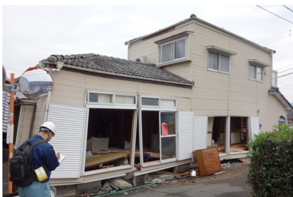
写真 5. 6-44 地盤変状が認められ、基礎に損傷が著しい事例 1
