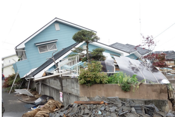
写真 5. 6-43 建築物の倒壊により基礎もしくは敷地地盤全体の状況確認が困難な事例（2 例）
