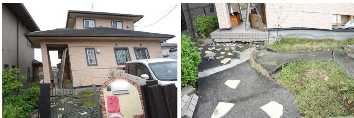
写真 5. 6-46 地盤変状が認められるが、基礎の損傷が軽微・無損傷の事例
