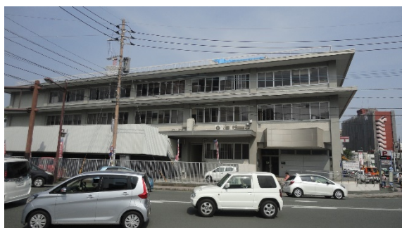
写真5.5-182 建築物外観（西側）
