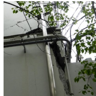
写真5.5-198 北東側2階脚部
