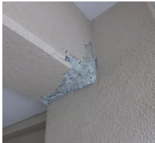
写真5.5-55 梁端部のかぶりコンクリートの剥落
