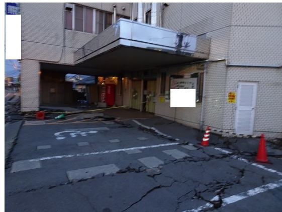
写真5.5-259 地盤の亀裂
