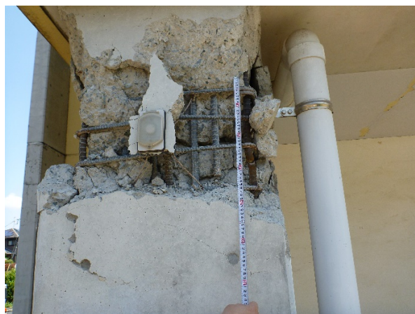
写真5.5-2 1階柱頭部の拡大
