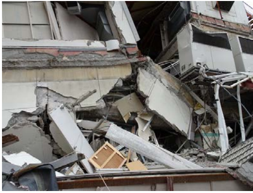
写真5.5-220 エクスパンションジョイント部（南面）
