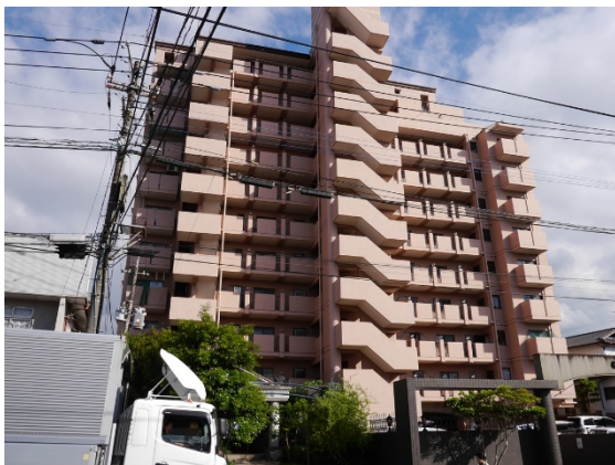
写真5.5-97 建築物北西側
