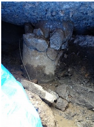
写真5.5-160 庁舎棟南西側コンクリート杭
