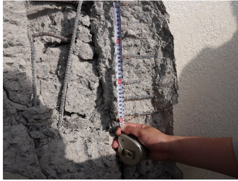
写真5. 5-26 柱帯筋の配筋
