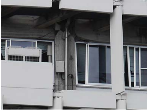
写真5.5-194 西側4階柱-5階梁接合部
