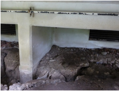
写真5.5-94 建築部外周部の地盤の亀裂
