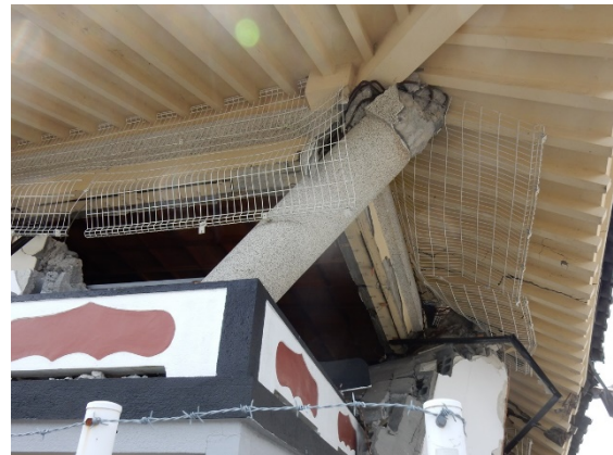
写真5.5-226 柱頭部の配筋
