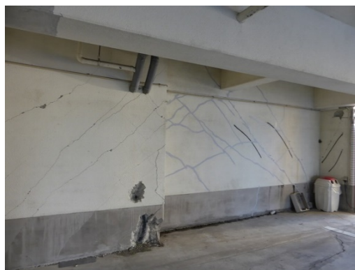
写真5.5-49 桁行方向構面外の非構造壁 のせん断ひび割れ
