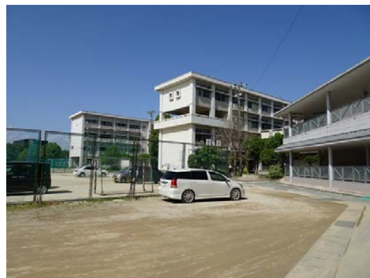
写真5.5-288 校舎外観（奥 2 棟）
