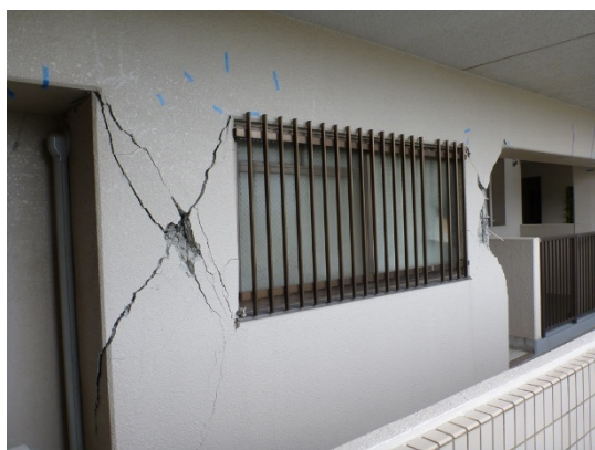
写真5.5-61 桁行方向の共用廊下側の構面における被害
