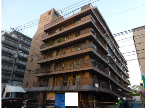
写真5.5-205 外観（南西側、県道側、東西軸住棟）
