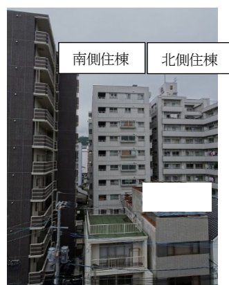
写真5. 5-74 隣接建築物から撮影した外観
