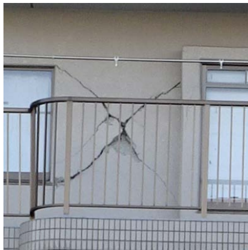
写真5.5-60 桁行き方向バルコニー側の方立て壁のせん断破壊
