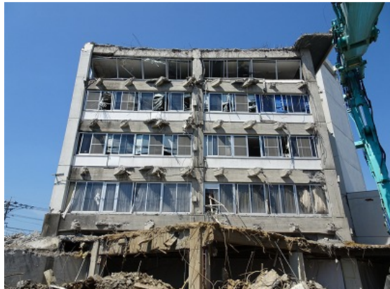
写真5.5-200 一部解体後の外観（南東側）
