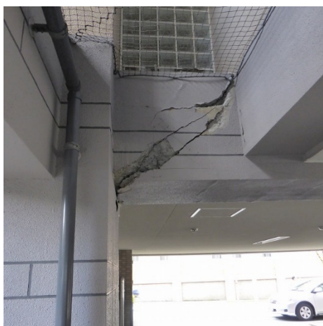
写真5.5-40 張間方向中構面 2 階大梁端部のせん断ひび割れ
