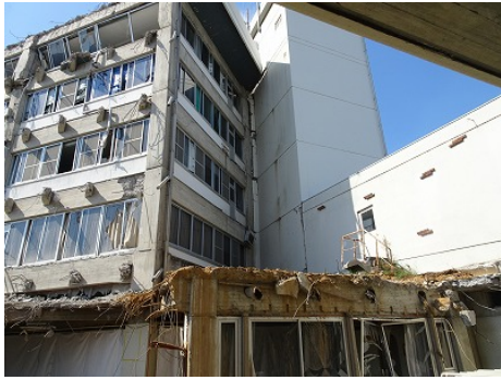
写真5.5-203 一部解体後の外観（東側）
