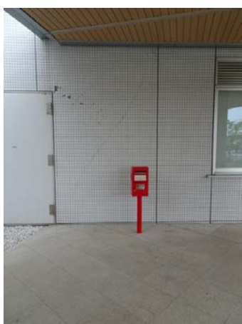
写真5.5-111 耐力壁のせん断ひび割れ
