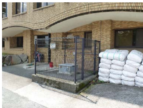
写真5.5-136 地震計設置状況
