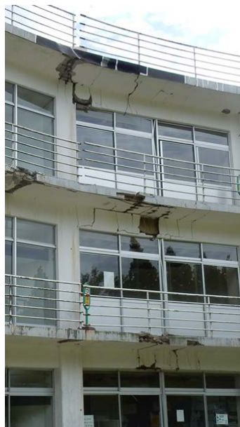
写真5.5-185 大梁の破壊
