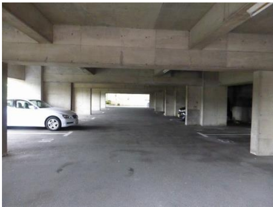
写真5.5-71 駐車場階（1階）全景
