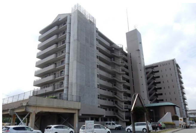
写真5. 5-59 建築物（北西側）
