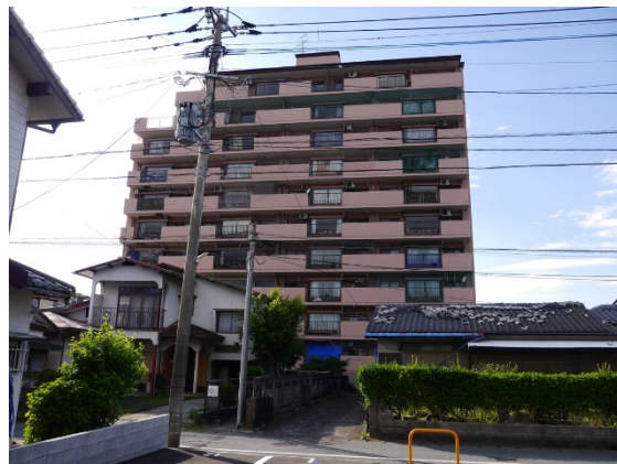
写真5.5-98 建築物南東側
