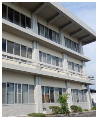
写真5.5-179 3F 外周部の手すりの撤去
