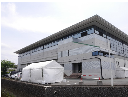
写真5.5-118 隣接する体育館
