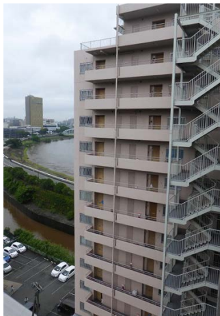
写真5.5-67 14 階建て建築物西面
