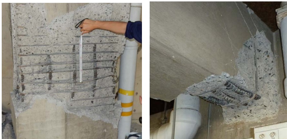
写真5.5-16 1階柱主筋、2階大梁（張間方向）の配筋
