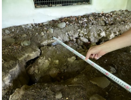
写真5.5-94 建築部外周部の地盤の亀裂
