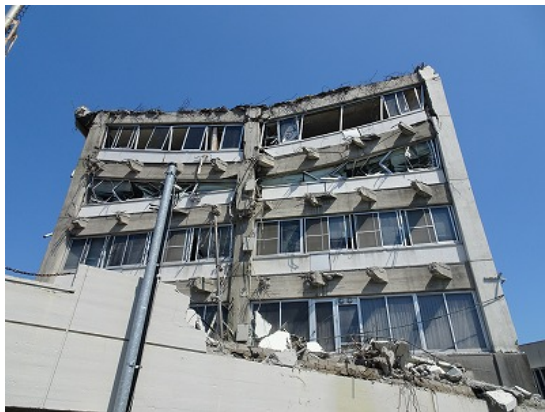
写真5.5-199 一部解体後の外観（南西側）
