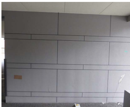
写真5.5-43 1階柱の張間方向に取付く袖壁
