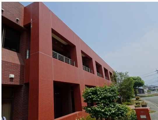
写真5.5-165 外付けフレーム側面
