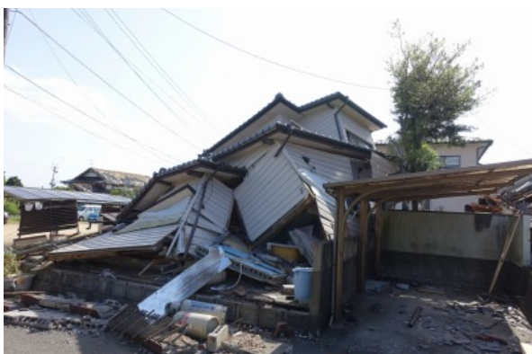
写真 5.3-12 倒壊した木造住宅
