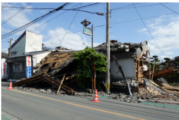
写真5.3-4 倒壊した木造住宅
