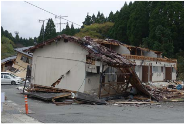
写真 5.3-54 倒壊した木造アパート D
