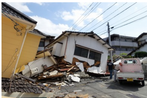
写真 5.3-13 倒壊した木造住宅
