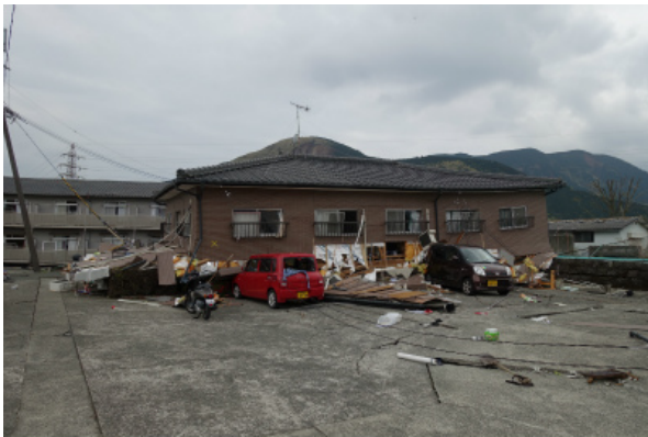
写真 5.3-56 倒壊した木造アパート E
