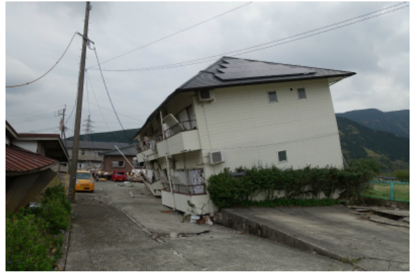
写真 5.3-59 横ずれした木造アパート
