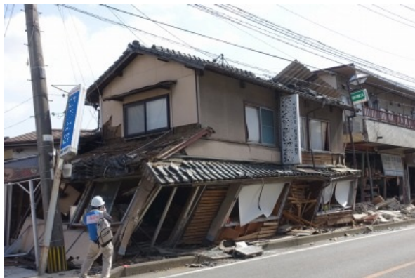
写真 5.3-7 大きく傾斜した店舗併用住宅
