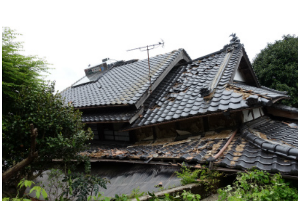
写真 5.3-26 倒壊した木造住宅
