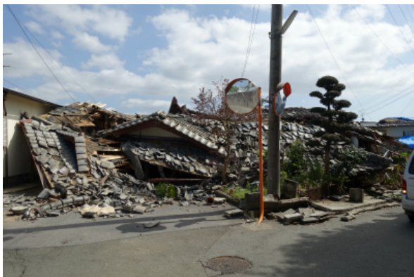
写真5.3-2 倒壊した木造住宅
