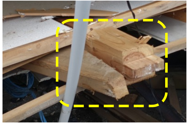
写真 5.3-55 アパート D の柱頭部 (柱脚、筋かい端部は釘打ちのみ)
