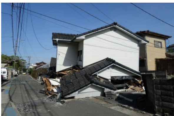
写真 5.3-10 倒壊した木造住宅
