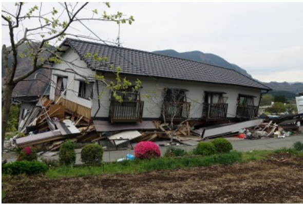
写真 5.3-58 倒壊した木造アパート
