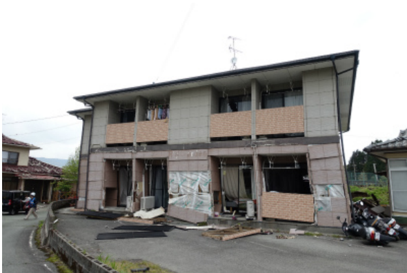
写真 5.3-60 傾斜した木造アパート
