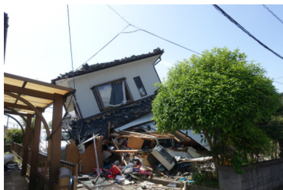
写真 5.3-9 倒壊した木造住宅
