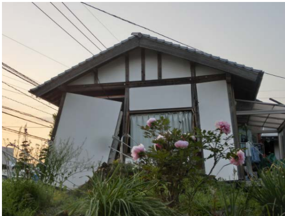
写真5.3-1 4/15時点では壁が外れただけの木造住宅(左)が本震で倒壊(右)した例
