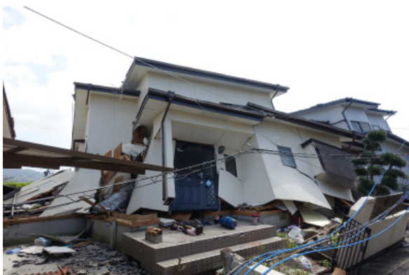
写真 5.3-8 倒壊した木造住宅
