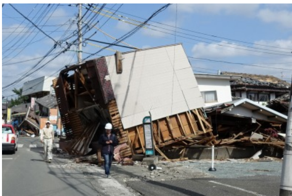
写真 5.3-6 倒壊した店舗併用木造住宅
