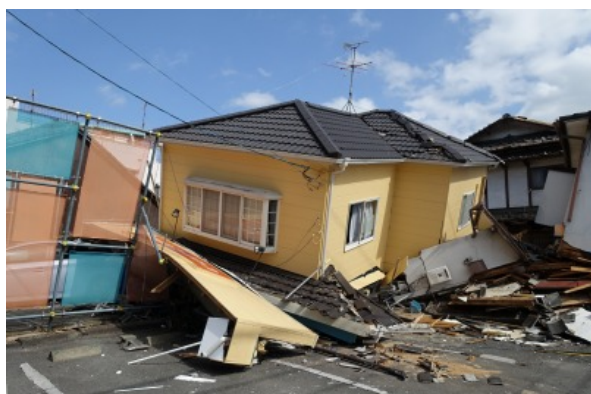
写真 5.3-11 倒壊した木造住宅
