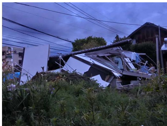
写真5.3-1 4/15時点では壁が外れただけの木造住宅(左)が本震で倒壊(右)した例
