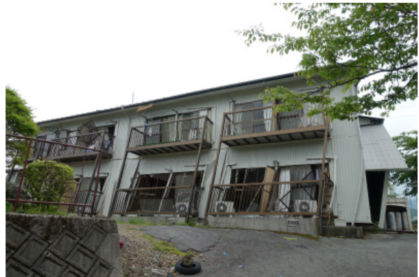
写真 5.3-61 傾斜した木造アパート
