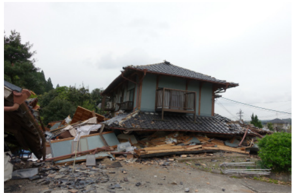
写真 5.3-27 倒壊した木造住宅
