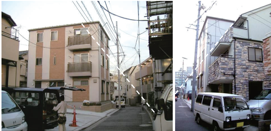
図1-11 街並み誘導型地区計画の認定を受けた建て替え事例（東京都品川区戸越一丁目地区）
