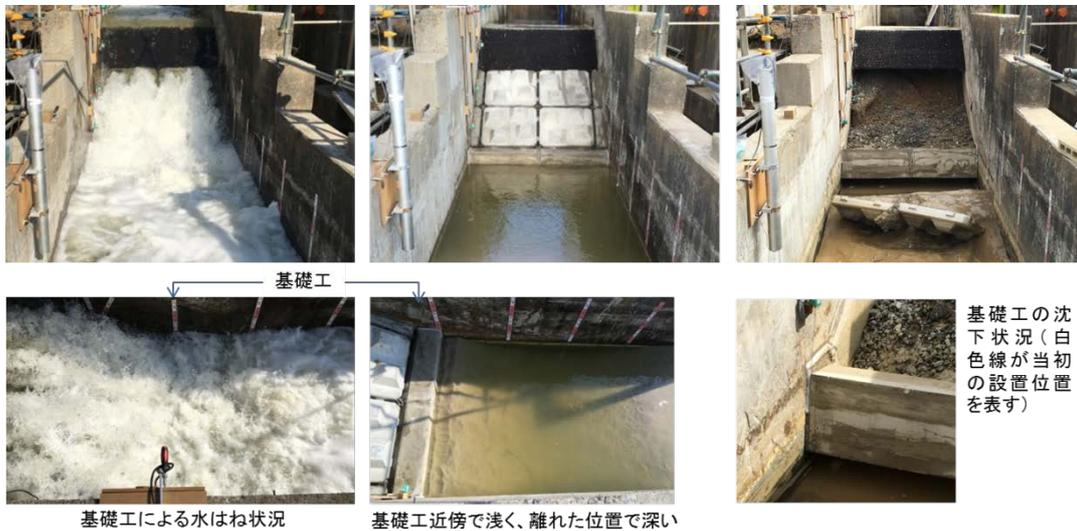
写真-11 のり尻補強工：実物矩形での越流\*・洗掘\*・破壊状況（\*：越流水深 30cm）
