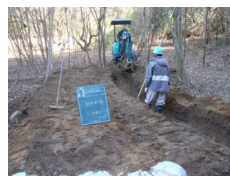
導水路造成（掘削）
