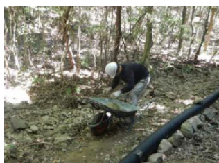
↑台風影響の修復：導水管下部の 先掘箇所補修
