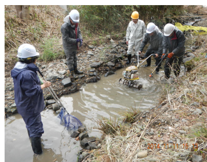
↑ 耕運機を用いて石礫を攪拌
