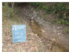
ガリーへの堰の造成（作業前）
