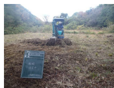
移設地整備範囲の伐根 作業
