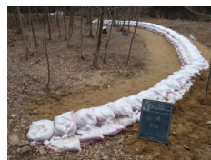
湿地(ビオトープ池)完成
