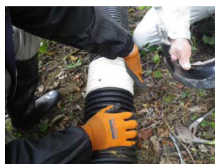
↑接合部損傷：止水テープ補強
