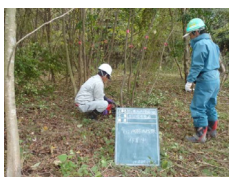
ハンノキ林内の支障木 の伐採作業
