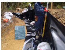
遮水シート設置
