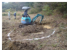
湧水箇所の確認（試験掘削）
