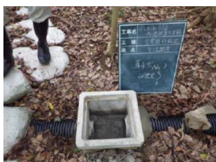
↑会所部分漏水：補修・調整作業
