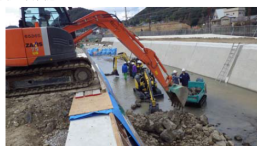
< 河床材料投入（バックホウ） >
