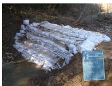
完成後の堰（上流側）
