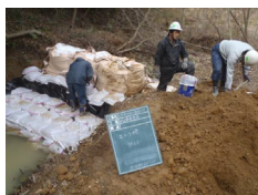
小型土嚢積み
