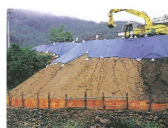
↑シート張り養生
