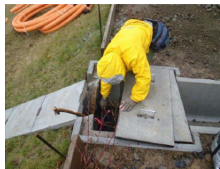
↑ 集水桝の確認状況
