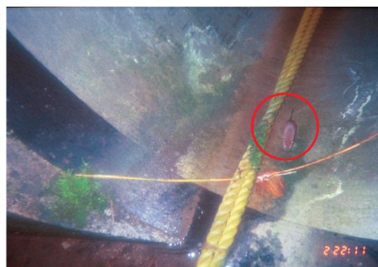
写真1-12 ロープ付き施設(ネズミ類) 〈豊富バイパス〉
