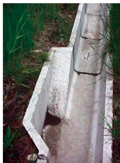
写真1-7 片側スロープ式側溝
