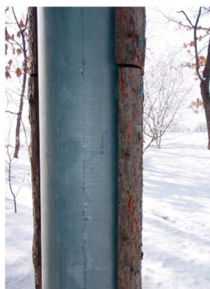
写真1-25 支柱に取付けられたカラマツ材
