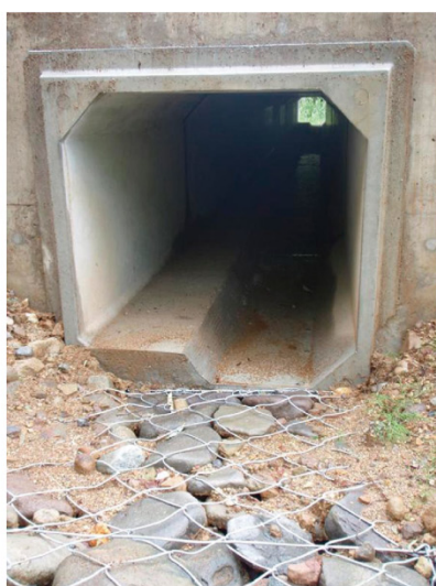
写真1-8 クロサンショウウオ用 ボックスカルバート〈八十里越道路〉
