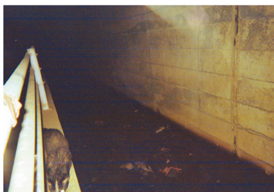
写真1-6 手すり下を利用するハクビシン 〈東富士五湖道路〉
