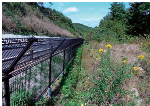
写真1-21 フェンス上部の工夫 〈荷路夫 にちぶ バイパス〉
