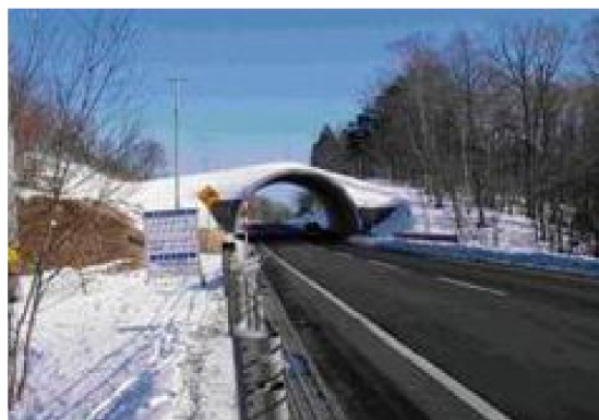
写真1-15 オーバブリッジ 〈一般国道44号〉
