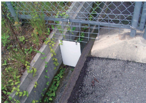
写真1-19 側溝の隙間対策 〈江津道路〉
