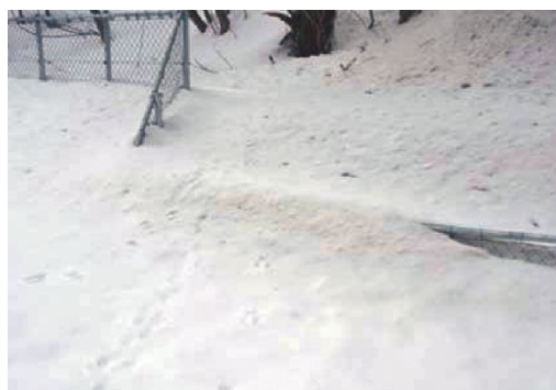
写真1-17 積雪で埋没した侵入防止柵 (甲子道路)
