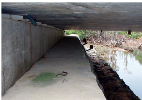
写真1-10 イリオモテヤマネコ用橋梁 〈沖縄県道215号白浜南風見線〉
