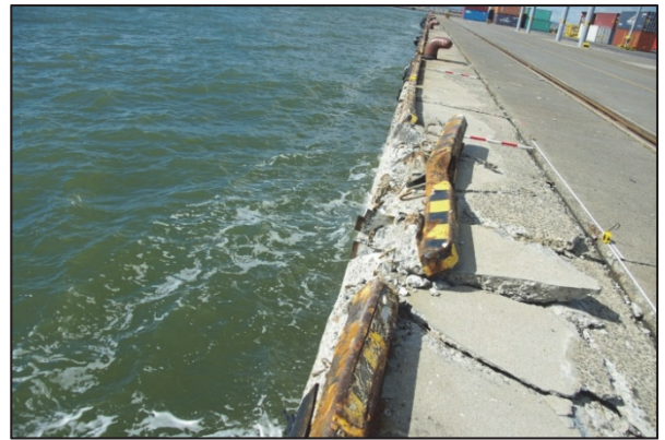
写真-5.8 上部工の損傷（西港区第3埠頭） （提供：釧路港湾事務所）
