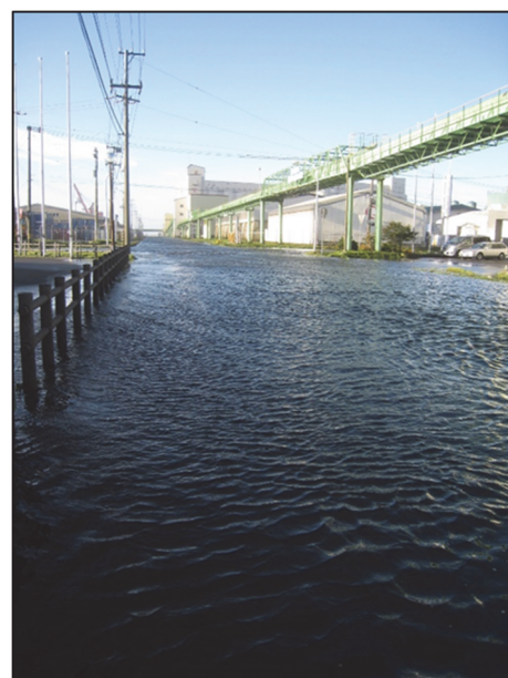
写真-5.5 西港区の浸水状況 (地点②) (10月2日6時55分撮影) (提供：釧路市水産港湾部)
