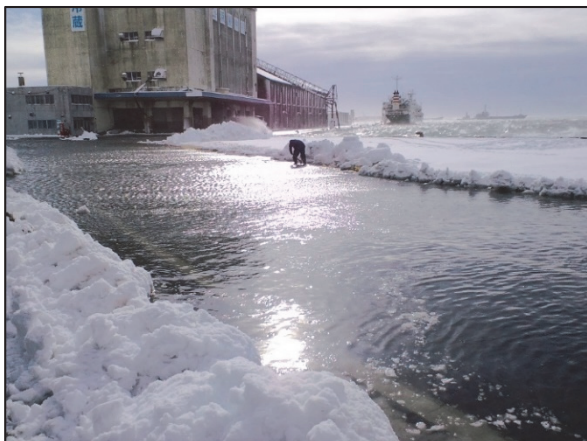
写真-5.3 東港区の浸水状況 (地点③) (2014 年 12 月 17 日) (提供：釧路市水産港湾部)
