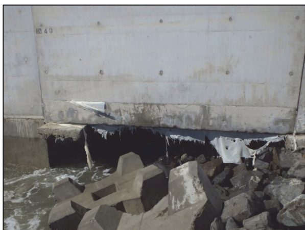
写真-5.13 捨石の流失 (西港区海面処分場) (提供：釧路港湾事務所)
