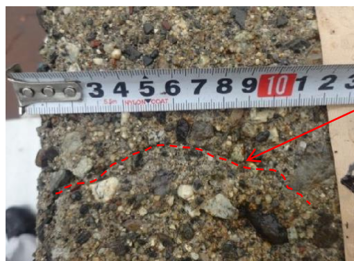
写真-3.1.1 地覆コンクリート表面状況 (図-3.1.4: 写真番号8)
