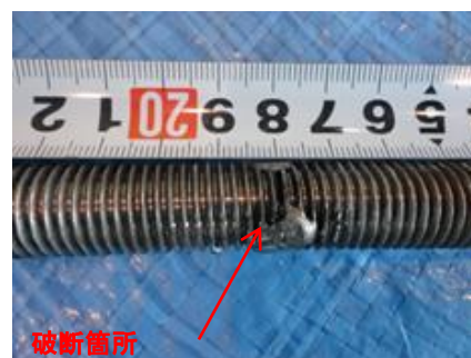
写真-3.2.2 破断ボルト（点付け溶接）
