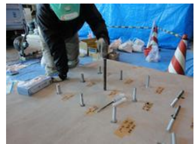
写真-3.2.21 打ち込み量の管理
