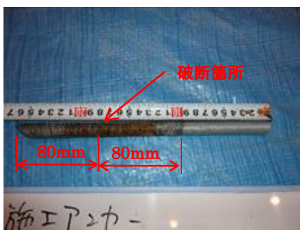
写真-3.2.1 破断ボルト（全景）
