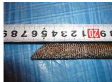
写真-3.2.18 腐食状況
