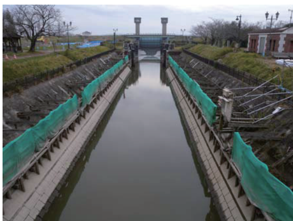
図-12 水抜き作業中の横利根閘門の閘室（下流側を望む） （撮影：阿部，2013.11.15）
