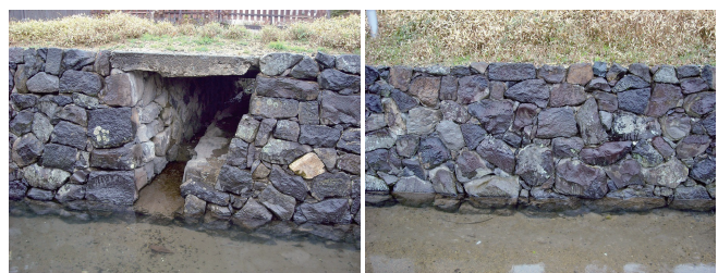
写真-2 整備後の護岸の石積みと目地の様子
