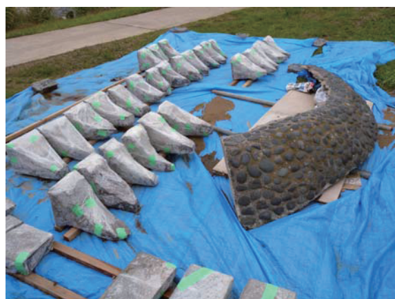
図-16 補修のために取り外された横利根閘門の護岸石材 （撮影：阿部，2013.11.15）
