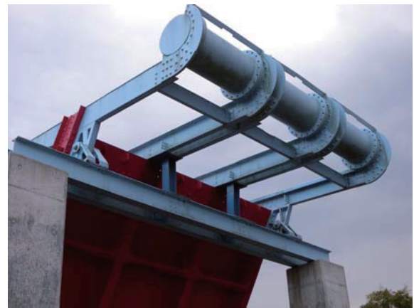
図-8 移設保存されている月浜第一水門のバランスゲート 中央 2 か所の支承部が取り外され転用された (撮影：阿部，2013.10.31)
