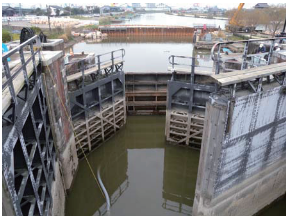
図-11 水抜き作業中の横利根閘門（上流側閘扉部） （撮影：阿部，2013.11.15）
