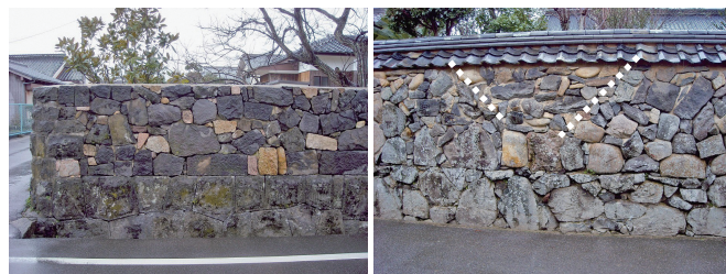
写真-3 全面改修実施区間
