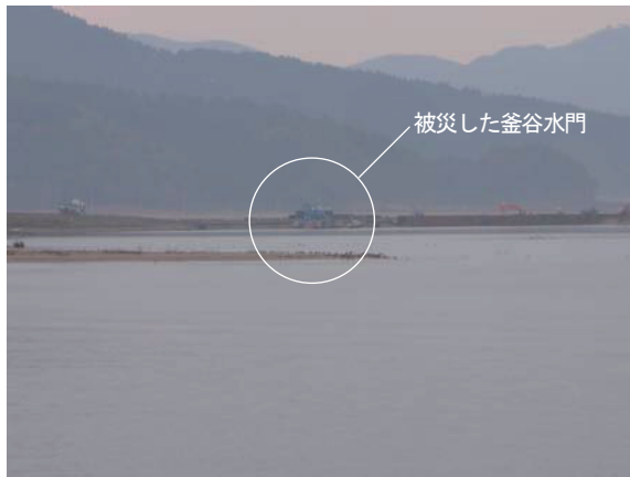
図-9 釜谷水門の遠景（北上川左岸側から撮影） 護岸の復旧が進む中、被災時のまま存置されている （撮影：阿部，2013.10.31）
