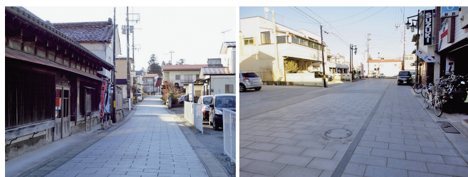
写真-5 舗装整備後の様子 （左：老舗通り、右：一番町大工町線）
