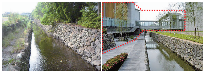
写真-1 藍場川の様子（左：整備前、右：整備後） 整備後の赤枠は美術館増築部分
