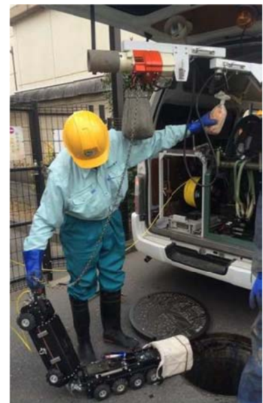
図 4-18 機材挿入状況
