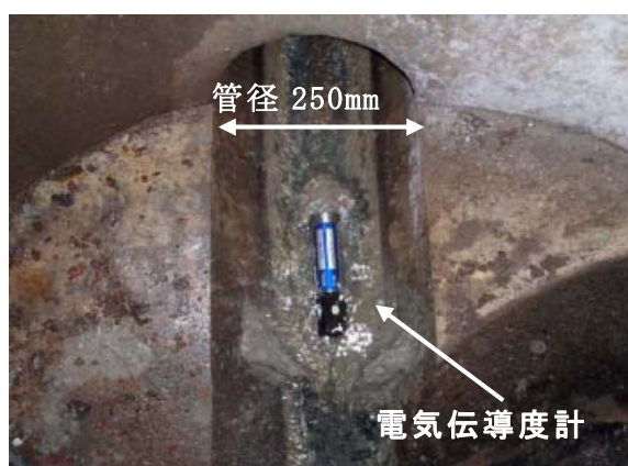
図 1-3 電気伝導度計の設置状況
