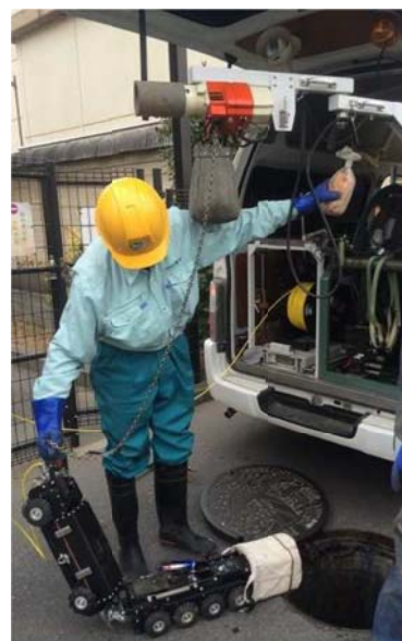
図 4-18 機材挿入状況
