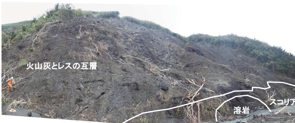
写真 3.1.1 大金沢源頭部の崩壊状況
