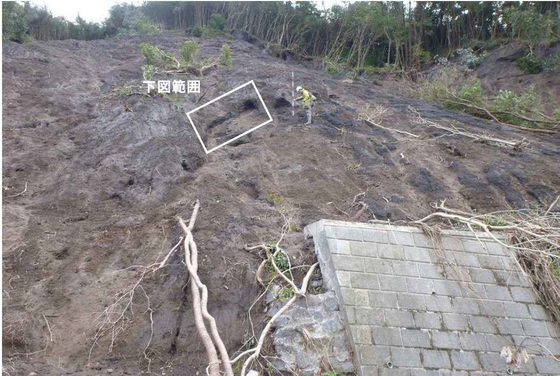
写真 3.1.13 土層観察箇所⑥の崩壊地全景
