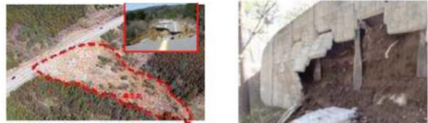
排水不良に起因する法面崩落
