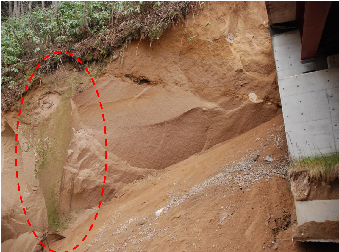
写真- 2.3.7 A1 橋台前面 左側（谷筋下流側）の斜面の状況（点線内に苔が確認できる）
