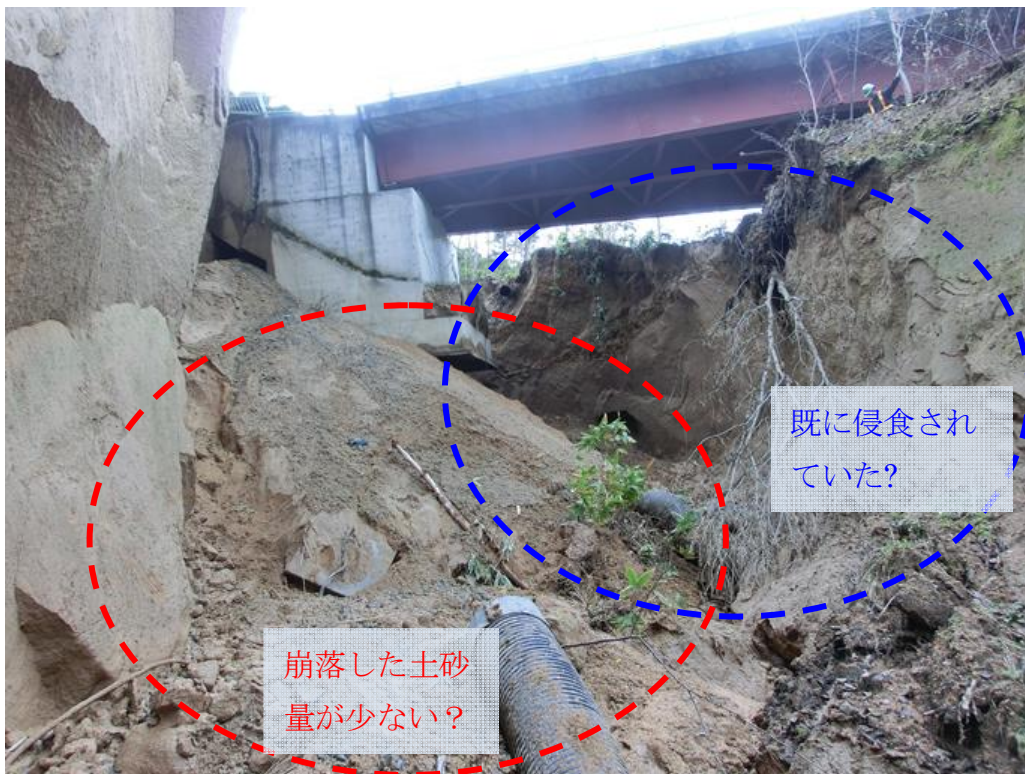
写真- 2.3.8 A1 橋台下側の土砂崩落の状況
