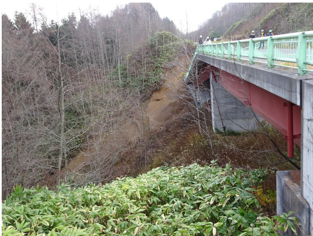
写真-2.3.2 対岸（A2 橋台側）から見た状況（向こう側が崩落した A1 橋台）
