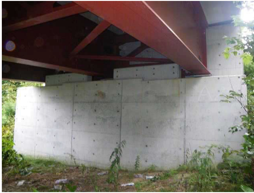
写真- 2.3.6 被災前（平成 24 年度橋梁点検時）の A1 橋台前面の状況
