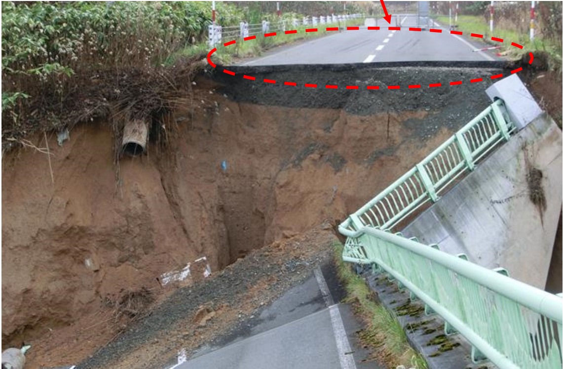
写真- 2.3.3 A1 橋台背面の状況
