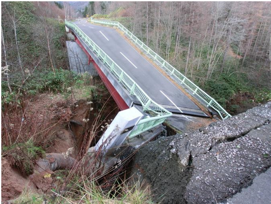
写真- 2.3.1 崩落した A1 橋台から見た落橋状況
