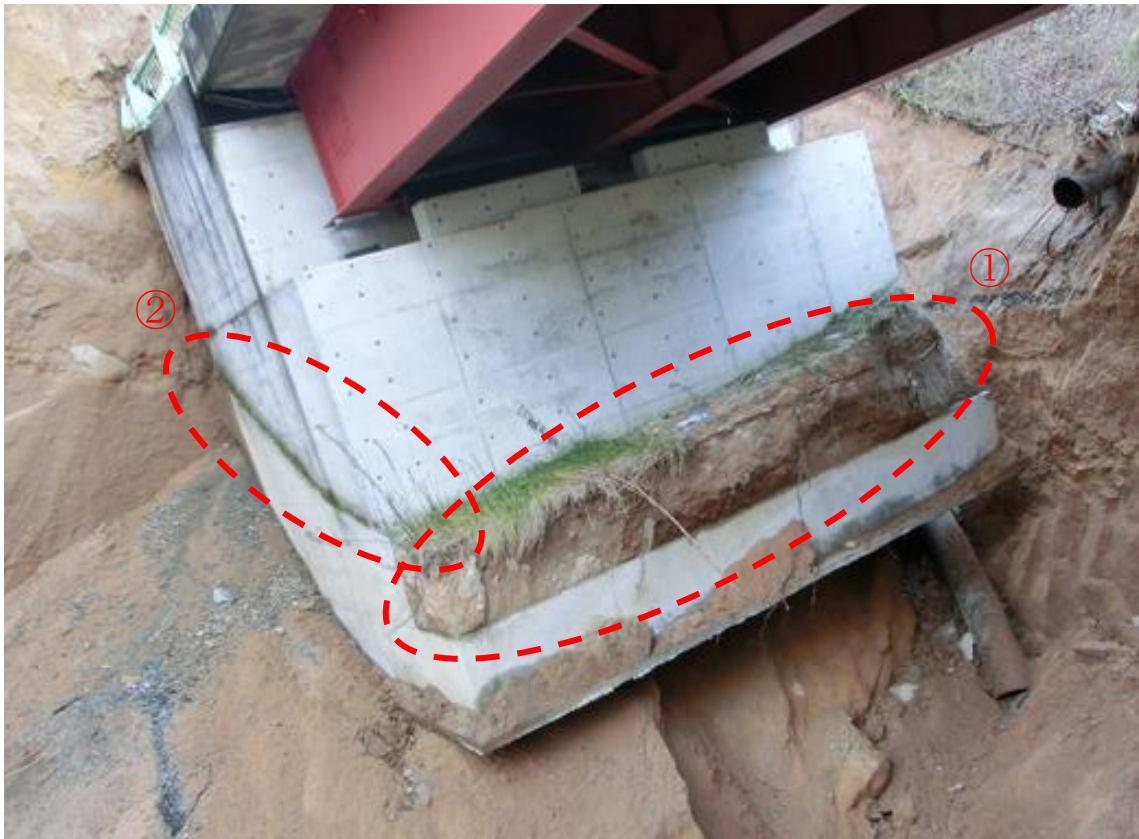
写真- 2.3.5 A1 橋台前面 左側側面の状況
