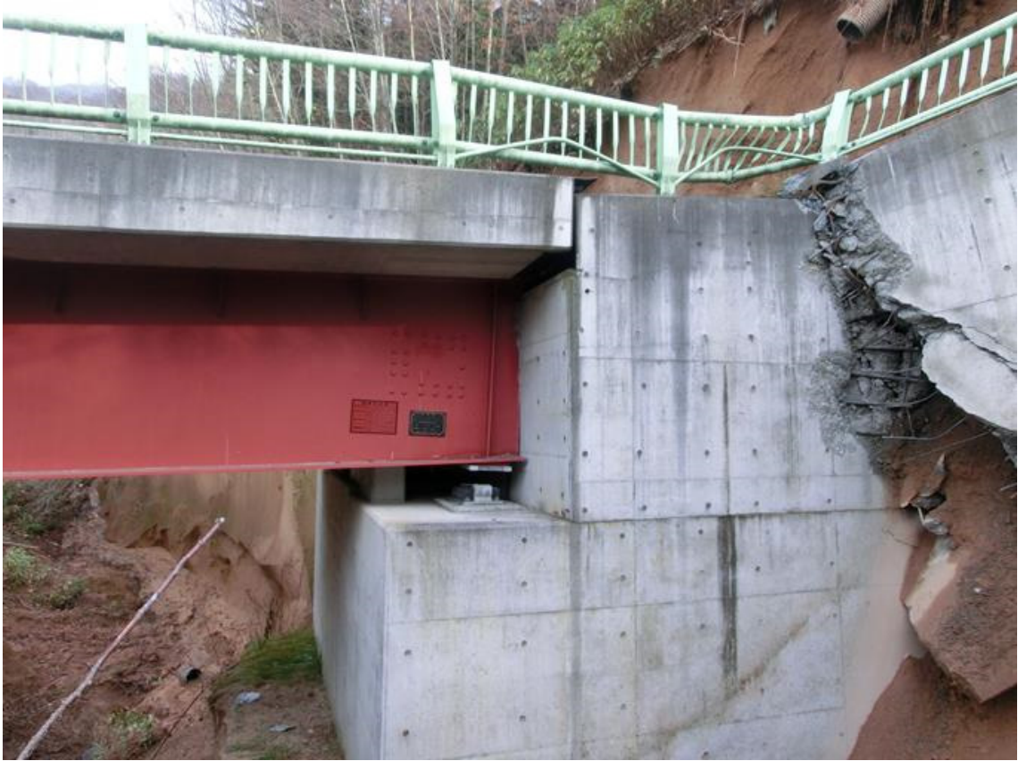
写真- 2.3.4 A1 橋台と上部工端部の状況
