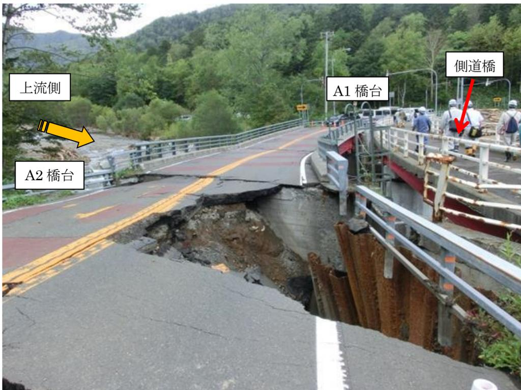
写真-1.5.22 奥漁川橋路面状況（A2 橋台背面）
