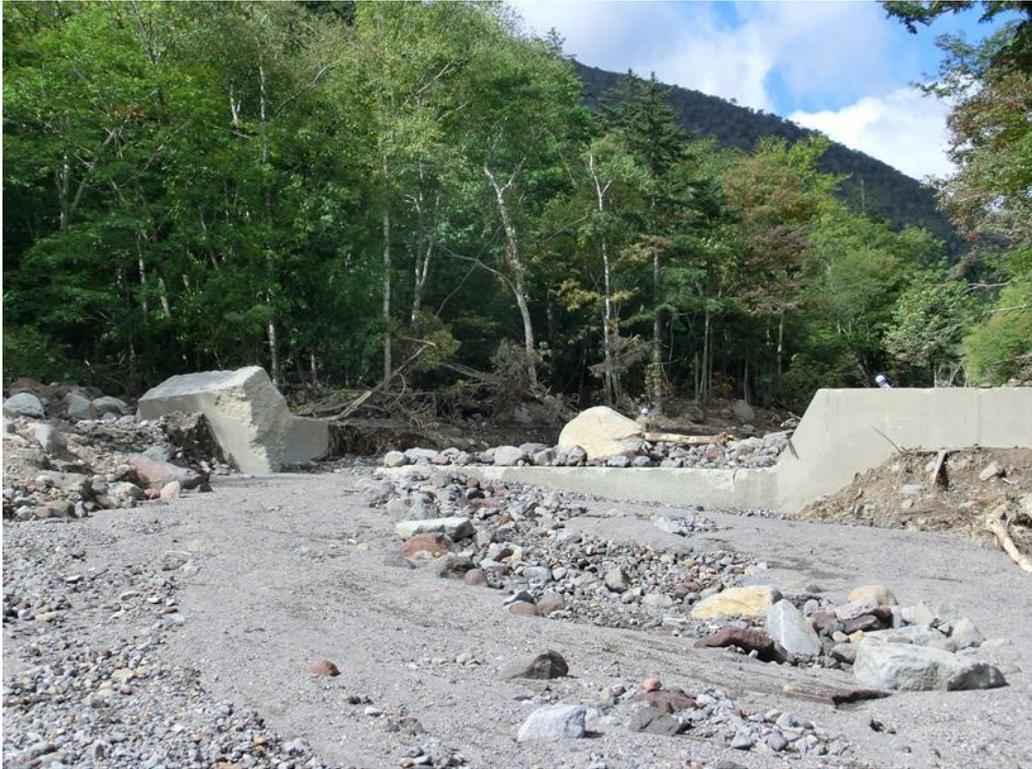
写真- 1.5.13 丸駒橋上流の治山堰堤破壊状況（丸駒橋から上流約100m）
