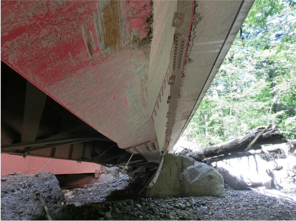
写真- 1.5.8 上流側鋼桁中央部外面の状況
