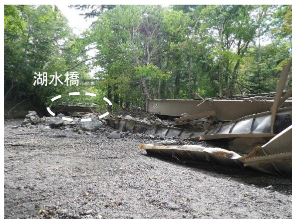
写真- 1.5.20 丸駒橋側道橋流失桁から下流
