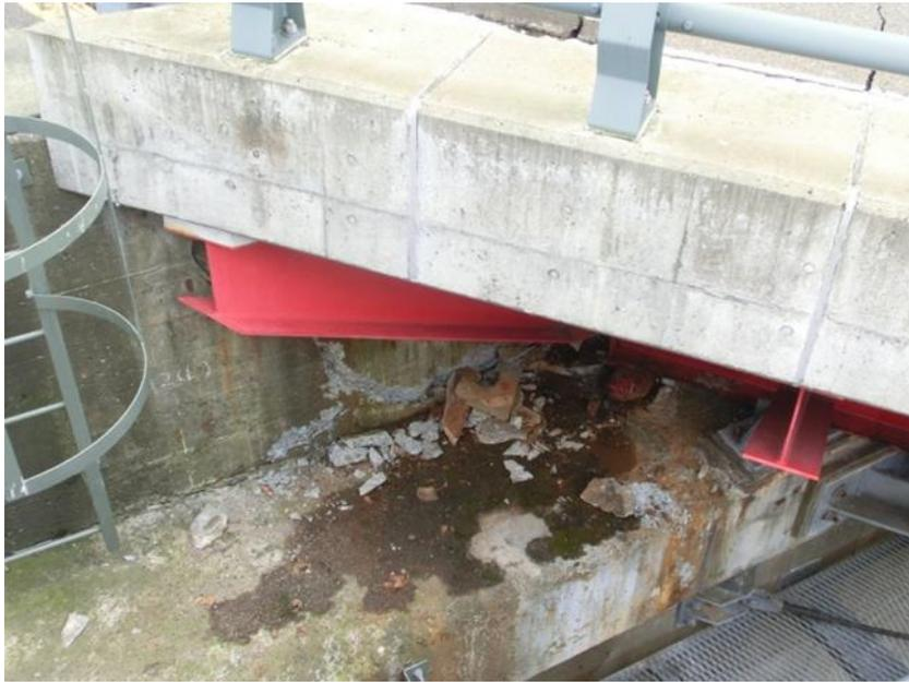
写真- 1.5.29 A2 橋台下流側支承部の状況
