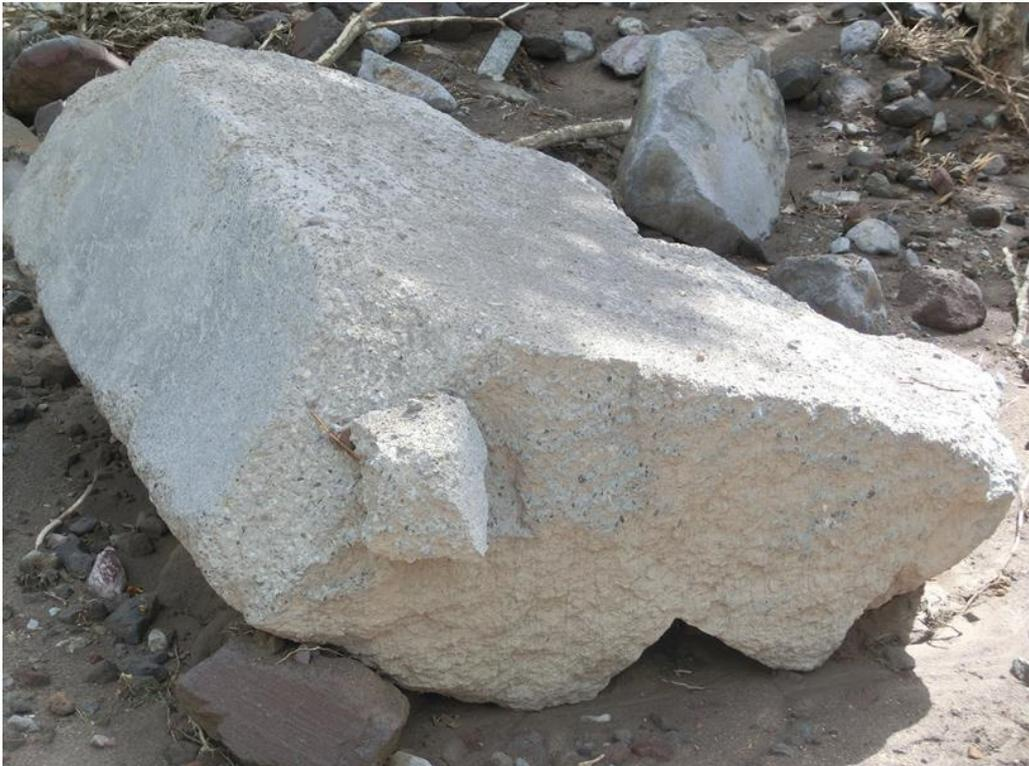
写真- 1.5.14 治山堰堤の破壊状況（丸駒橋 A2 橋台下流部）
