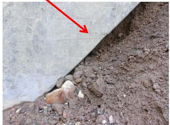
写真- 1.5.12 A2 橋台（上流側）ウイングの損傷状況
