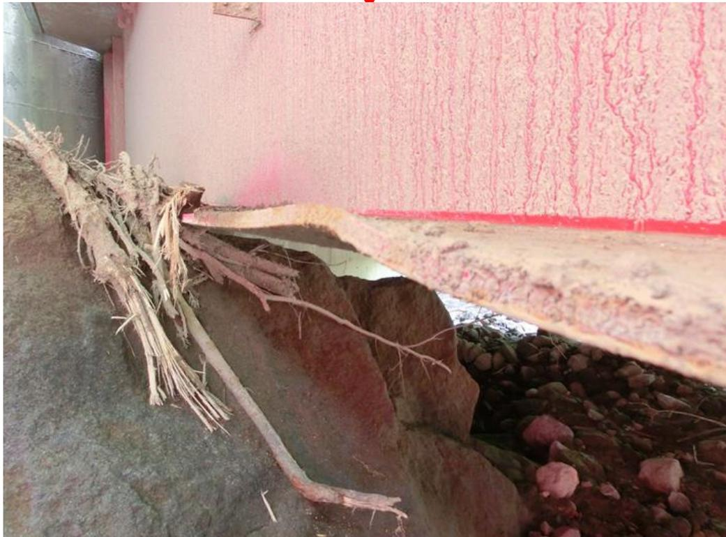
写真- 1.5.2 上流側鋼桁への岩塊の衝突状況 (A2 側)
