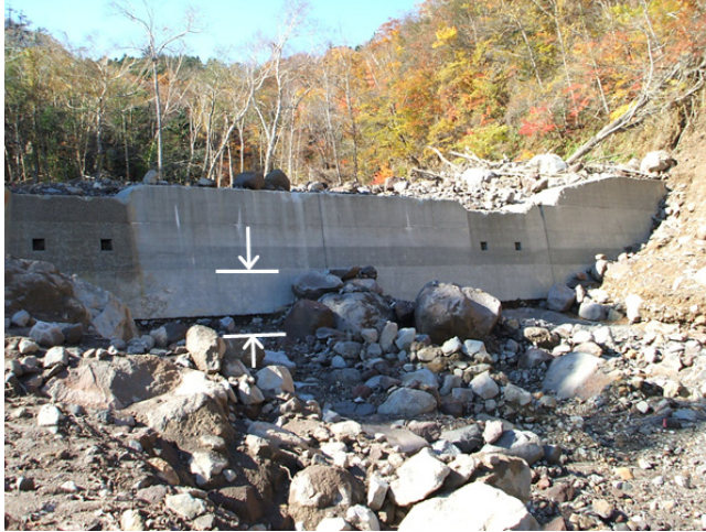
写真- 1.4.1 下流部が洗掘を受けた治山堰堤
