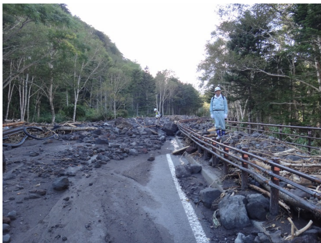
写真- 1.4.16 国道に堆積した礫径が小さい土石(KP35.4km 付近)
