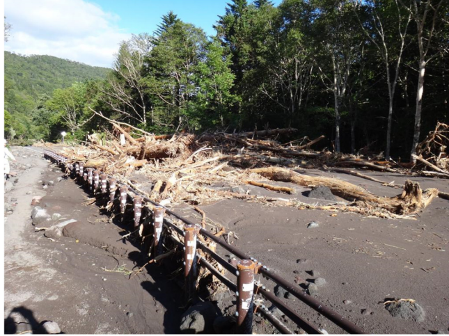
写真- 1.4.17 国道に堆積した土砂及び流木(KP35.6km 付近)
