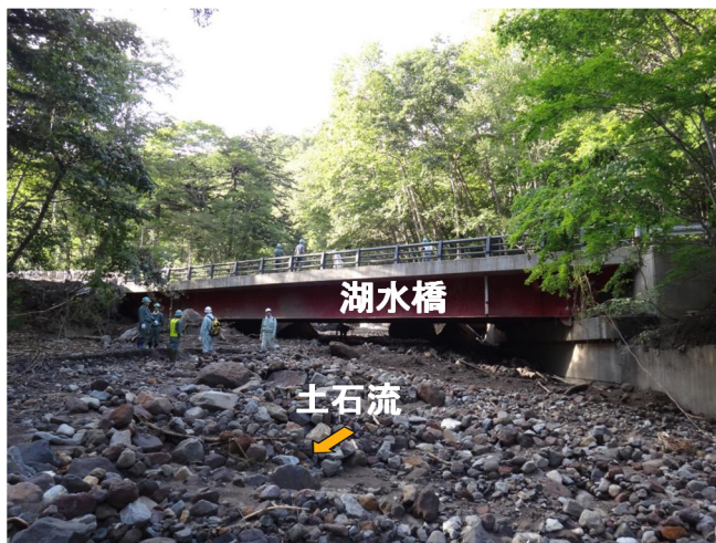
写真- 1.4.9 湖水橋の桁下高と下流の土砂堆積状況（下流から撮影）
