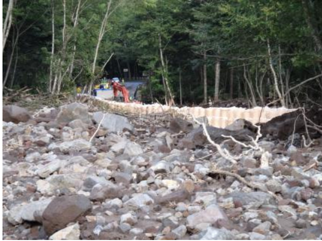
写真- 1.4.7 湖水橋上流右岸に堆積した土石流本体
