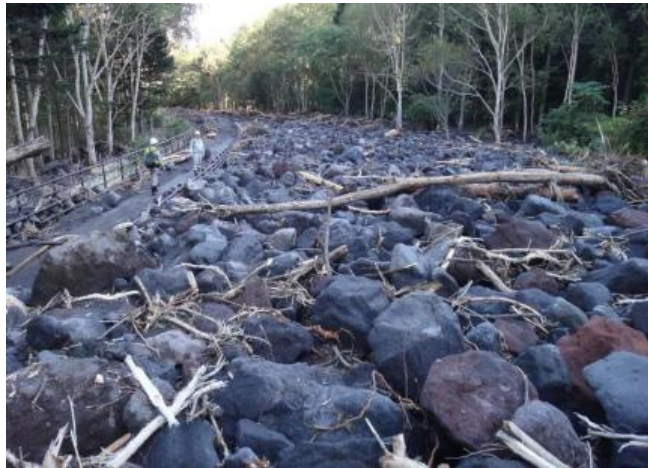
写真- 1.4.15 KP35.1km から路面を流下し国道に堆積した土石流
