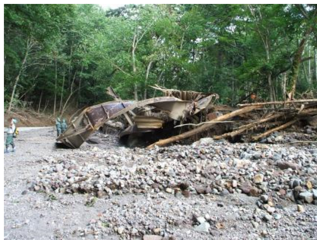
写真- 1.4.6 流失した丸駒橋の側道橋桁
