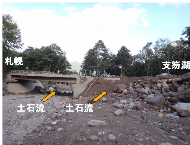
写真- 1.4.5 上流側から見た丸駒橋の災害復旧状況（9月13日撮影）
