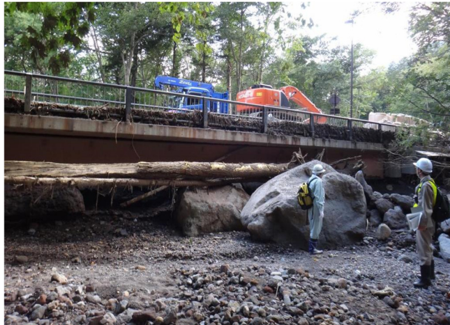
写真- 1.4.8 湖水橋桁下の土砂堆積状況（上流から撮影）
