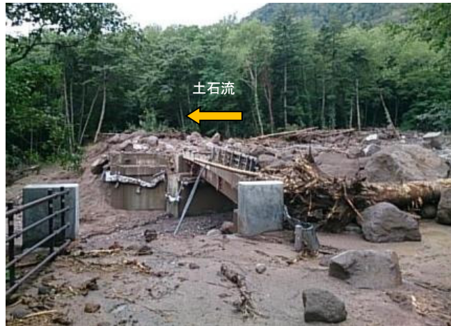
写真- 1.4.4 丸駒橋の被災状況（9月11日撮影 左側は流失した側道橋桁部）
