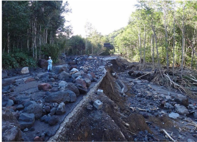
写真- 1.4.14 北麓沢の出口で国道を横断及び流下した土石流 (KP35.1km 地点)
