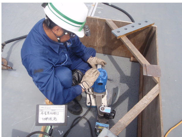
写真-4.3.10 吊ピース切断機
