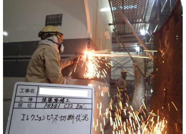
写真-4.3.8 溶断時の局所養生
