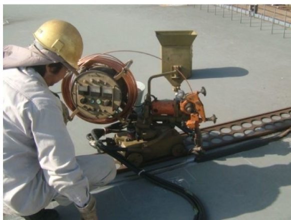
写真-4.2.5 サブマージアーク溶接機の例
