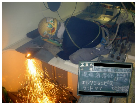
写真-4.3.2 溶断作業
