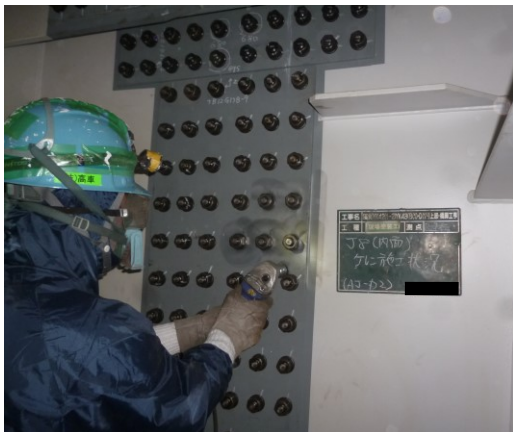
写真-4.3.12 素地調整（動力工具）
