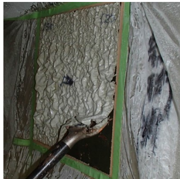
塗装剥離状況
