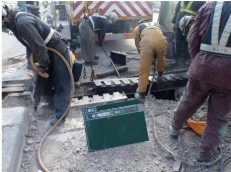
写真-4.1.4 伸縮装置撤去状況
