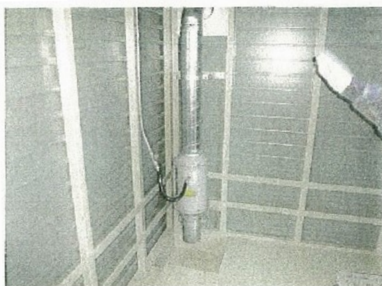
強制換気装置
