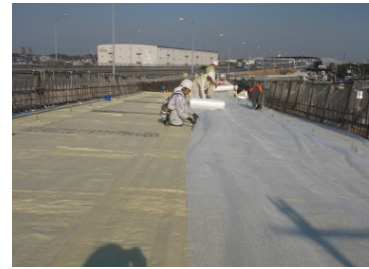
写真-3.3.6 養生シートの例
