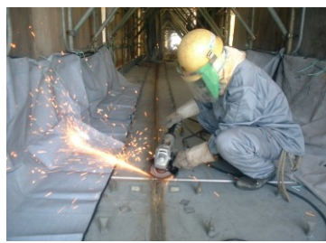
写真-3.3.5 不燃シートの例
