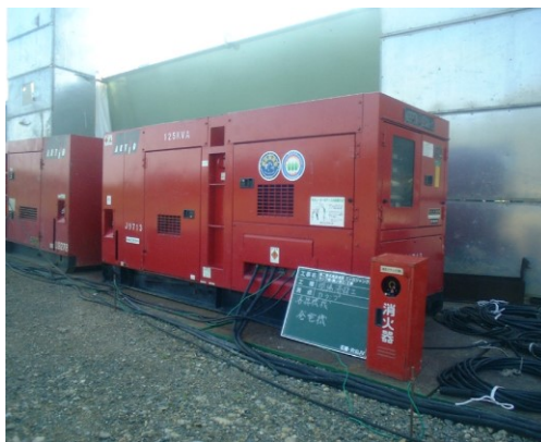
写真-3.2.1 発電機の例
