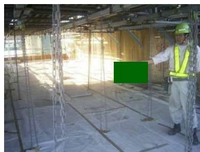
写真-3.3.11 パネル式吊足場内部の例 写真-3.3.12 パネル式吊足場にシート張防護の例
