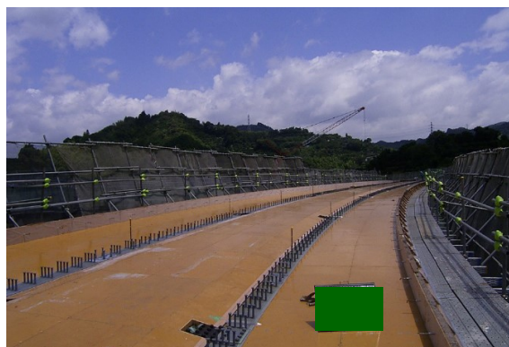
写真-3.3.13 床版型枠の例
