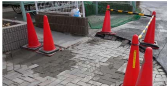
写真 2.3-2 周辺地盤の液状化の様相
