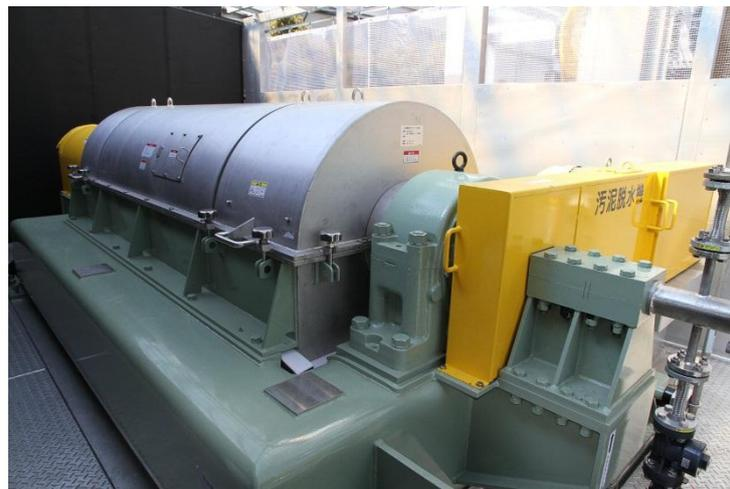
図 2-8 実証設備における機内二液調質型遠心脱水機の外観
