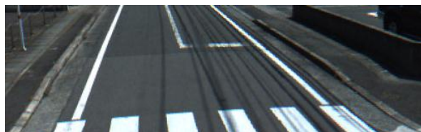
車道外側線が設置されている例
