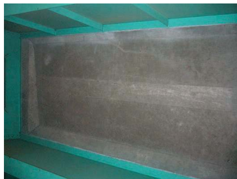
写真-5.2.2 床版下面損傷状況
