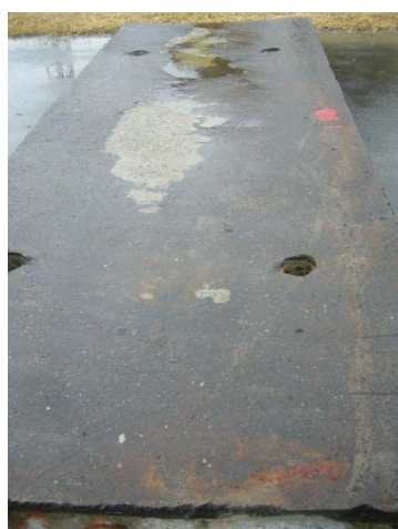
写真-5.2.3 舗装の摩耗状況
