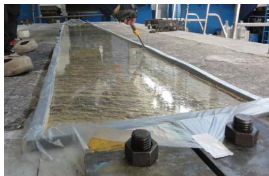
写真-5.2.7 床版上面平滑化加工状況 (エポキシ樹脂塗布)
