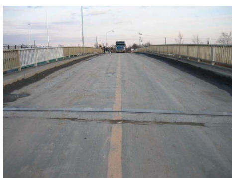
写真-5.2.4 床版上面の状況
