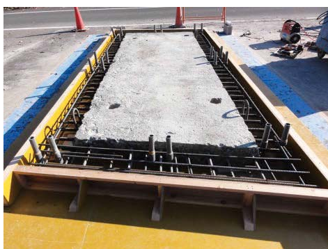
写真-5.2.6 床版加工状況
