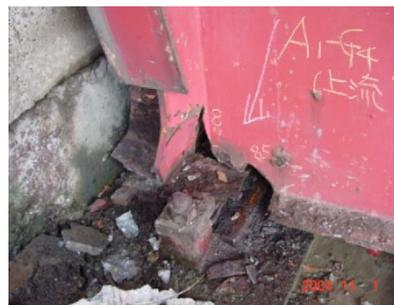
腐食、破断
