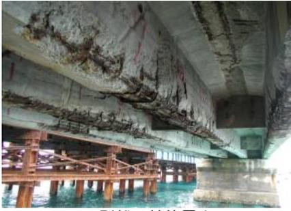
剥離・鉄筋露出
