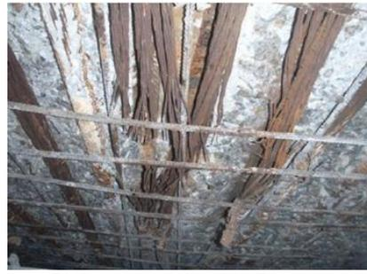
剥離・鉄筋露出、PC鋼材破断
