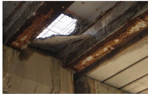
鋼板接着補強されたコンクリート床版の抜け落ち
