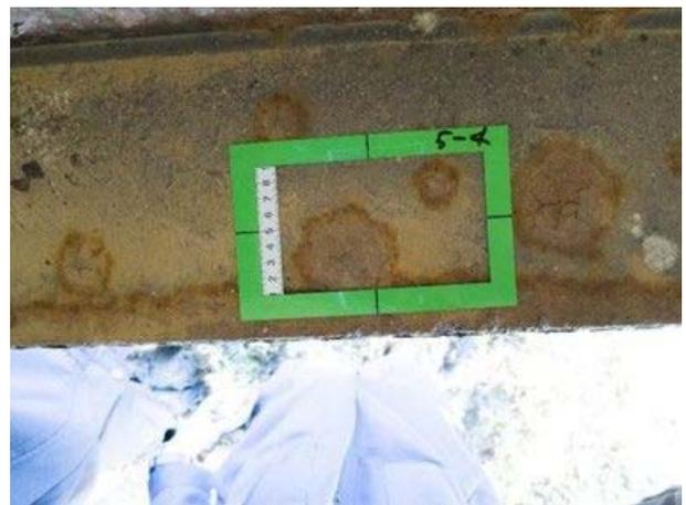
図-3.17 コブ状さびの色調補正した近景写真の例
