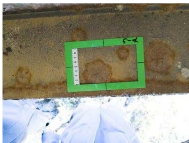
図-3.17 コブ状さびの色調補正した近景写真の例
