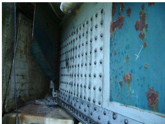
図-1.4 当て板による補修事例
