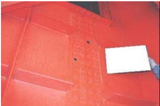
図-1.3 高力ボルト脱落の実例
