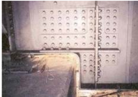
図-1.3 高力ボルト脱落の実例
