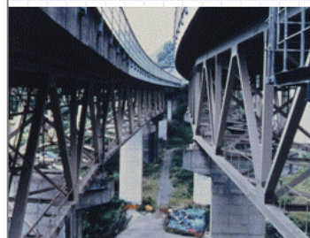
東名高速道路、上路トラス 主構トラス上弦材と床トラスの接合部 設計では単純支持。フランジ間をつなげた ディテールの橋もあり。亀裂の発生はない。
