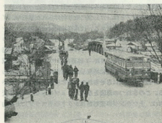
写真-2 重量制限された橋 (ペンシルベニア州)
