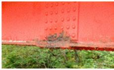
高力ボルト連結部の腐食
