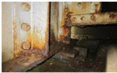
桁端部の腐食
