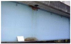
排水装置直下の腐食
