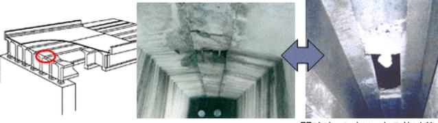
PCT桁の間詰め部での漏水 間詰めコンクリートの抜け落ち
