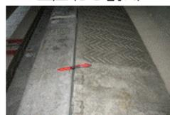
土圧(側溝・監査歩廊変形)
