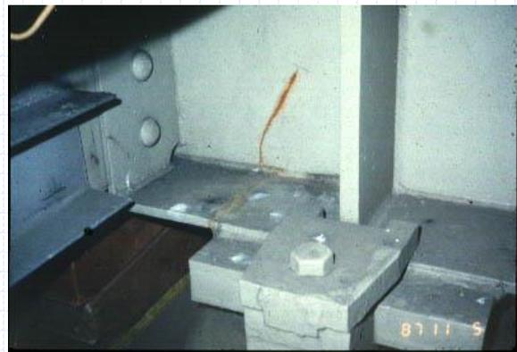
と固定端モーメントが出るわけです。固定端モーメントといのうは両端を Fix にすると真ん中に起きるモーメントよりも、固定端モーメントのほうが大きいのです。そうするとこういうことがソールプレート（床板）の取付部に起きてくる。これはもう危ないのです。もうすぐ脆性破壊します。
