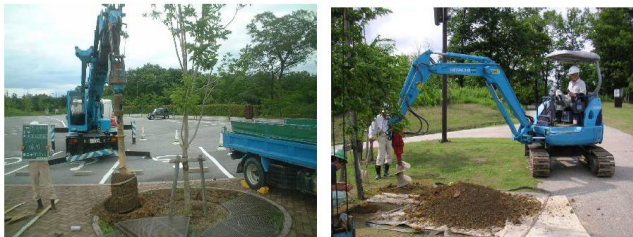
(機械掘削による改良)
