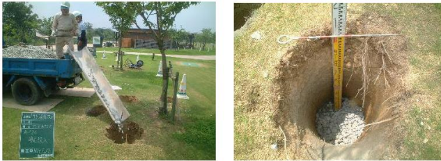
(人力掘削による改良)
