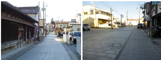
写真-5 舗装整備後の様子 （左：老舗通り、右：一番町大工町線）
