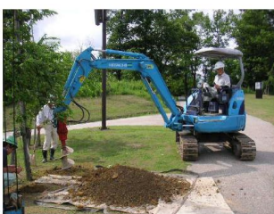
(機械掘削による改良)
