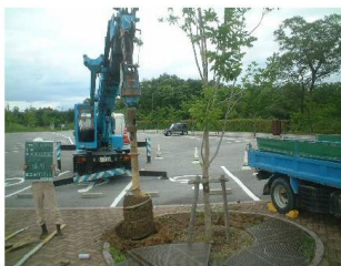
(機械掘削による改良)
