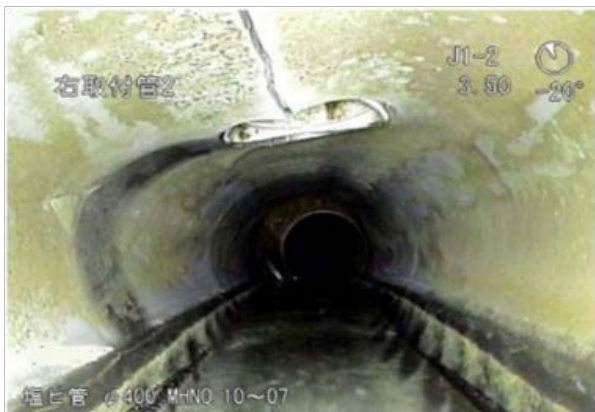
写真-1 破損の事例
