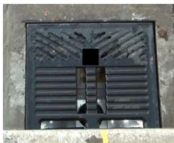
図7 改良型雨水枡蓋
