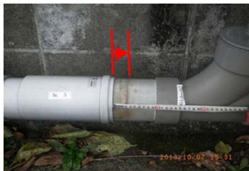
写真1 伸縮による継ぎ手部のズレ
