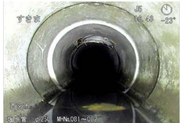
写真-2 継手ズレの事例
