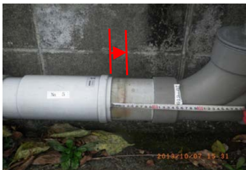
写真1 伸縮による継ぎ手部のズレ
