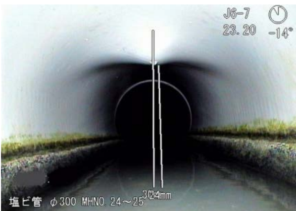
写真-3 変形の事例
