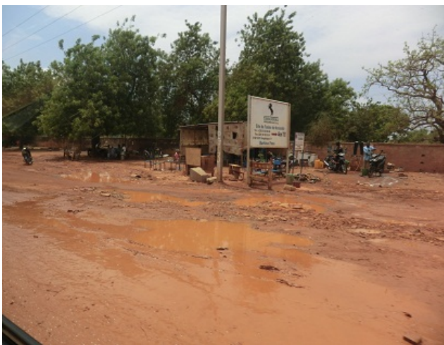
写真3 現地訪問期間中の降雨後の道路の様子 短時間の降雨であったが、浸透せず水たまりとなっている。
