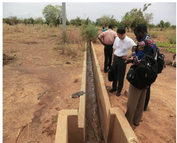
写真 2 処理水放流口と農地 ここから流出する処理水を農業利用している。
