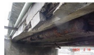
高齢化に伴い損傷が進行した橋
