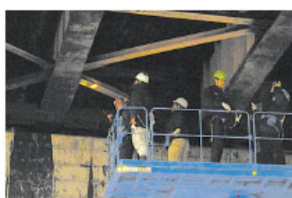
老朽化橋梁点検に関する技術指導
