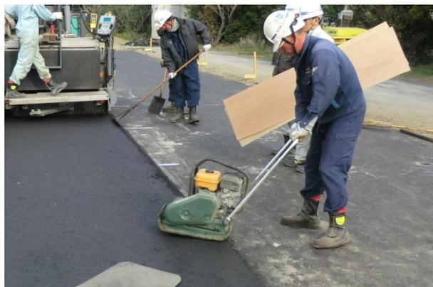
写真-2 ジョイント部の施工状況
