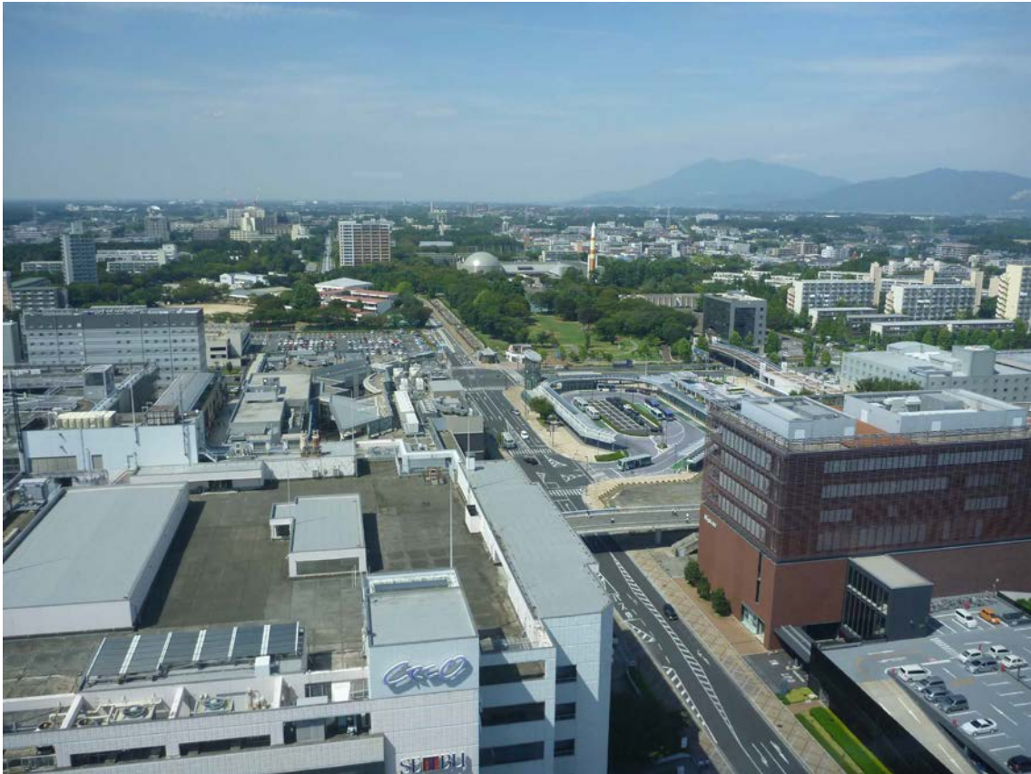
写真 3-3 つくば三井ビルディングから都心地区北部を望む（2011 年 9 月撮影）
