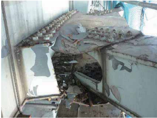
(a) 横支材－下横構間の取付部材(図中①) (b) 横支材－対傾構間の取付部材(図中②) 写真-2.7.1.2 湾754橋脚におけるトラス部材の損傷状況(資料提供：首都高速道路(株))
