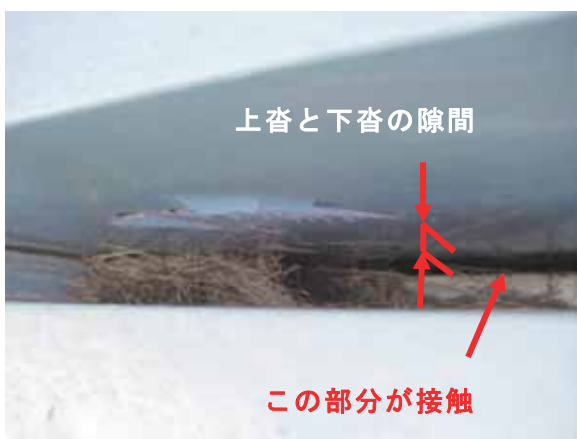
(a) 海側ウインド支承(S2 支承)接触痕
