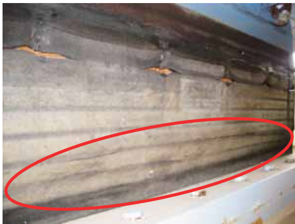
(a) P36 橋脚側より
