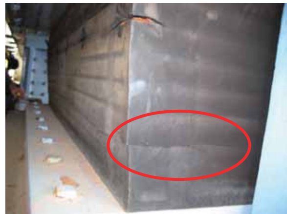
(b) P36 橋脚側山側より
