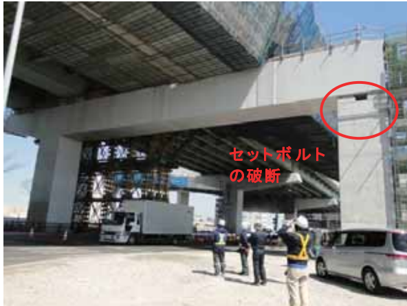
写真-2.2.1.7 P56橋脚：鋼横梁を支持する柱上のゴム支承セットボルトが破断
