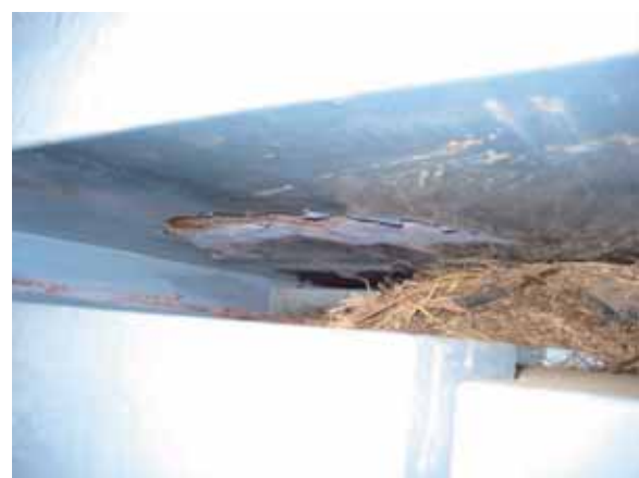
(b) 山側ウインド支承(S3 支承)接触痕
