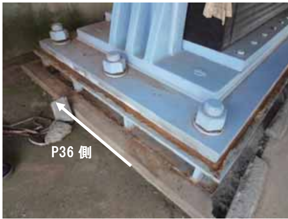
(a) P34 橋脚側より
