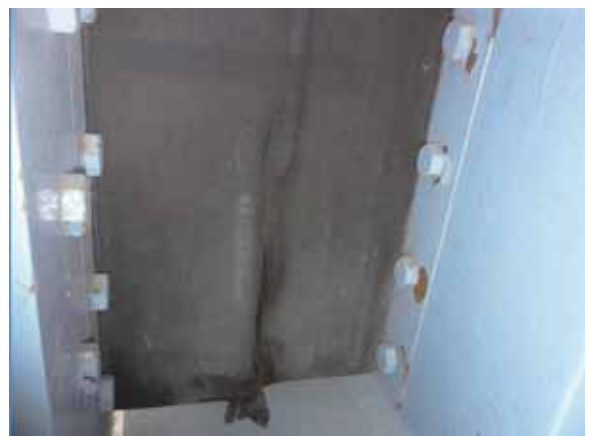
(b) P36 橋脚側より
