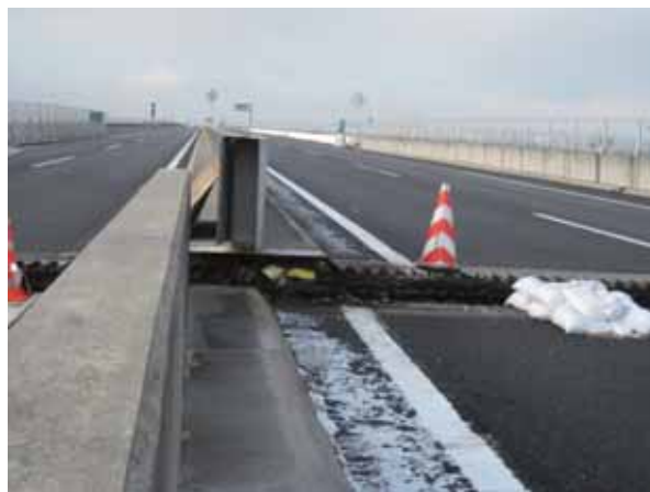
写真-2.2.1.4 P56橋脚上の直角方向及び鉛直方向の桁のずれ (写真提供：東日本高速道路(株))
