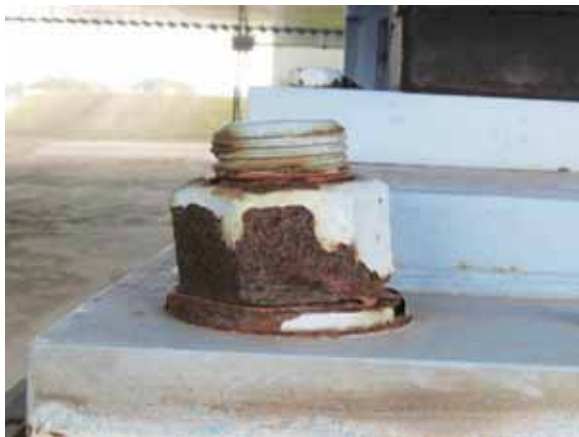
(a) アンカーボルトの損傷
