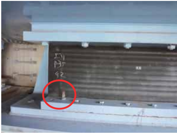
(a) 損傷の状況
