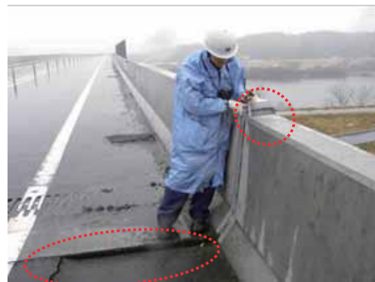
写真-2.1.2.3 橋台背面の沈下による段差
