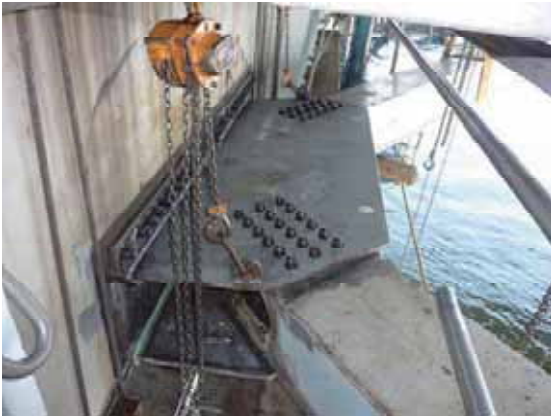
(a) 横支材－下横構間の取付部材(図中①) (b) 横支材－対傾構間の取付部材(図中②) 写真-2.7.1.3 湾754橋脚におけるトラス部材の復旧状況(資料提供：首都高速道路(株))
