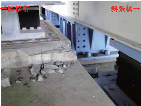
(a) 隣接桁の台座コンクリートの損傷
