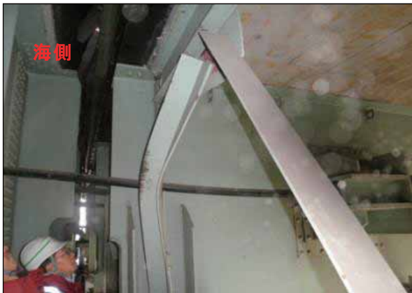
写真-2.2.1.14 P56橋脚上の鋼桁端部の対傾構の座屈(写真提供：東日本高速道路(株))
