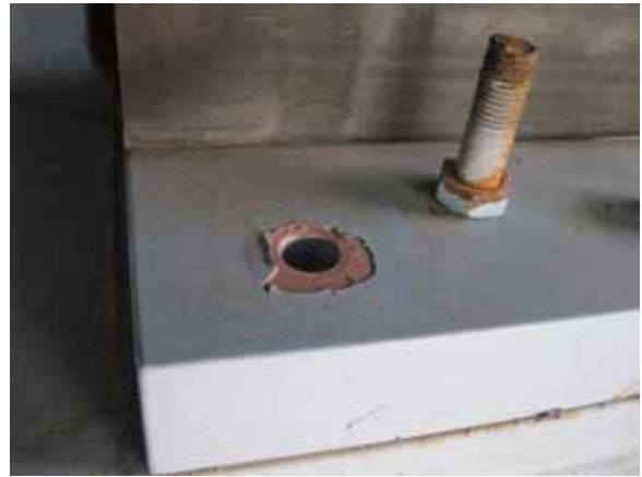
(b) 破断した固定ボルト
