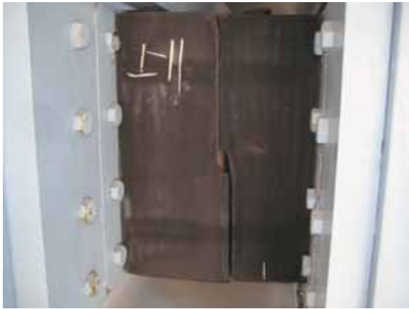
(a) P34 橋脚側より
