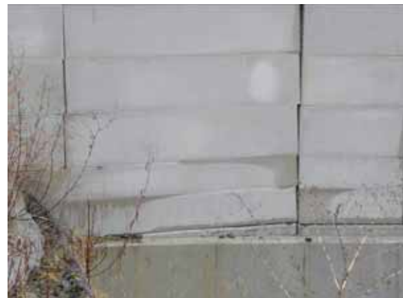
写真-2.1.2.4 橋台取付部の化粧板の目地ずれ
