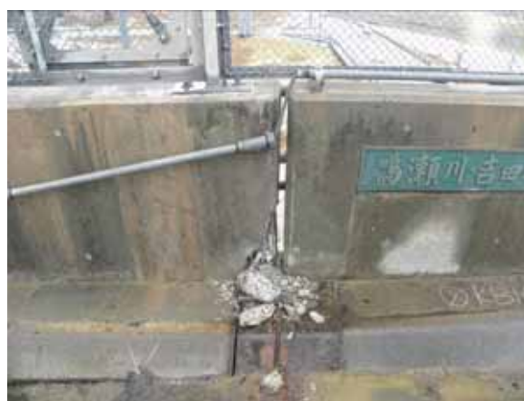
写真-2.1.4.3 A1 橋台と隣接桁の衝突による防護壁の損傷(下り線側)
