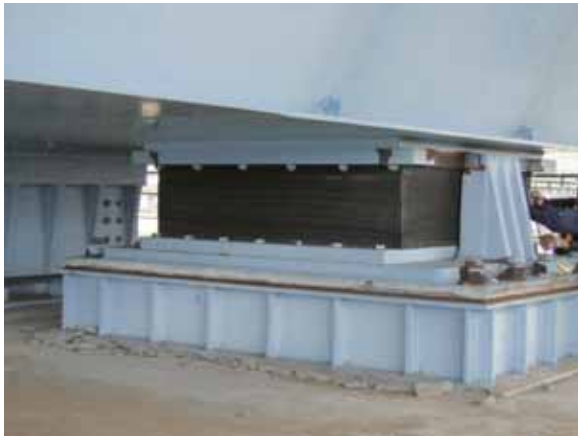
(a) 支承全景
