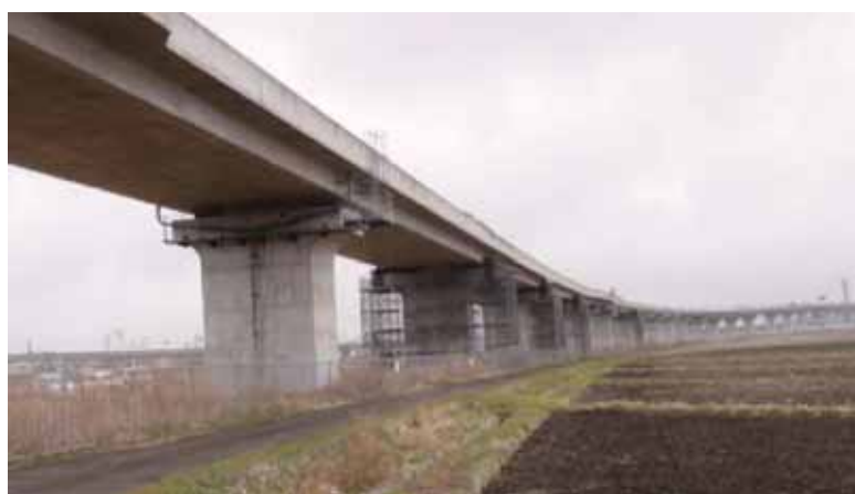
写真-2.3.1.1 利府高架橋(資料提供：東日本高速道路(株))
