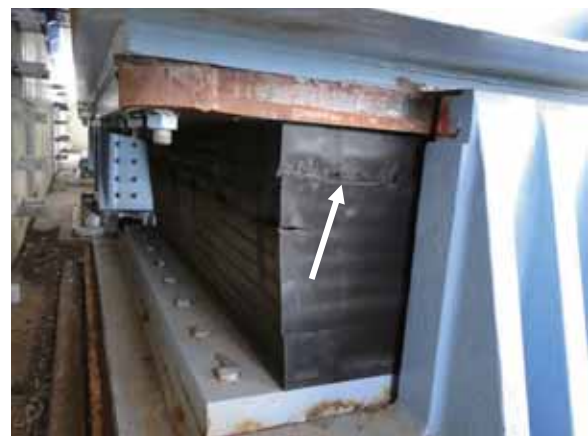
(b) P36 橋脚側山側より
