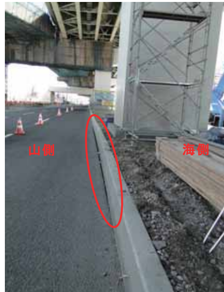
写真-2.2.1.21 P56橋脚から見たP57 橋脚：路面と中間分離帯間にすき間
