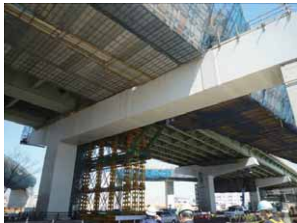
写真-2.2.1.2 P56橋脚及びP58側の状況
