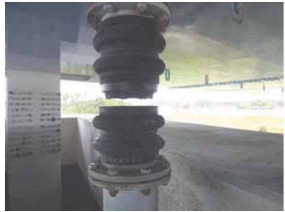
(b) 排水管ジョイント損傷
