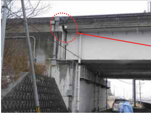
写真-2.1.4.4 A1 橋台と隣接桁の衝突による橋台パラペットのひび割れ(上り線側)
