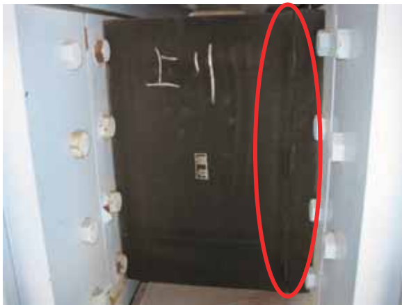
(a) P34 橋脚側より
