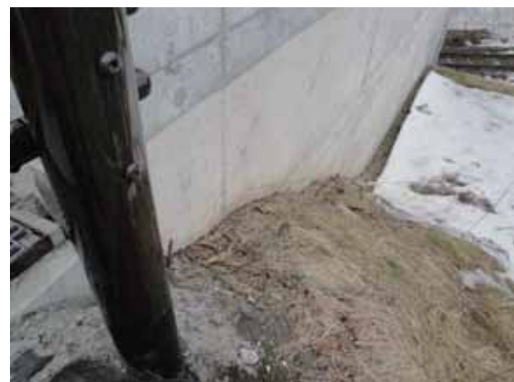
(b) 側面の盛土の沈下
