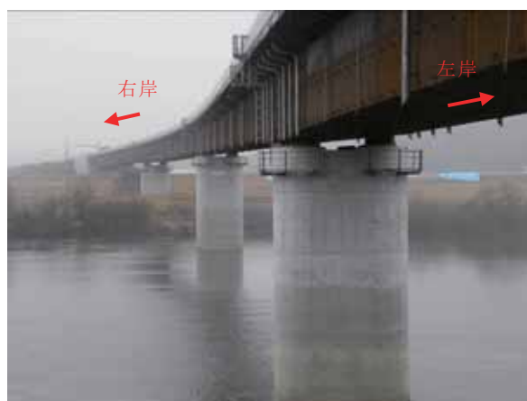
写真-2.1.2.1 新米谷大橋(東和町側より)
