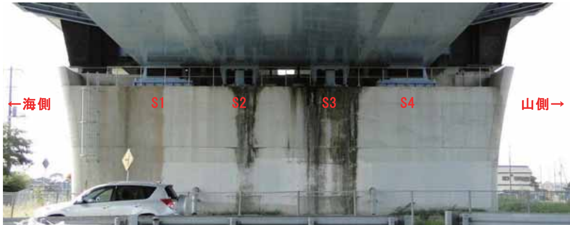
写真-2.6.1.3 P31橋脚正面(P32橋脚側より)
