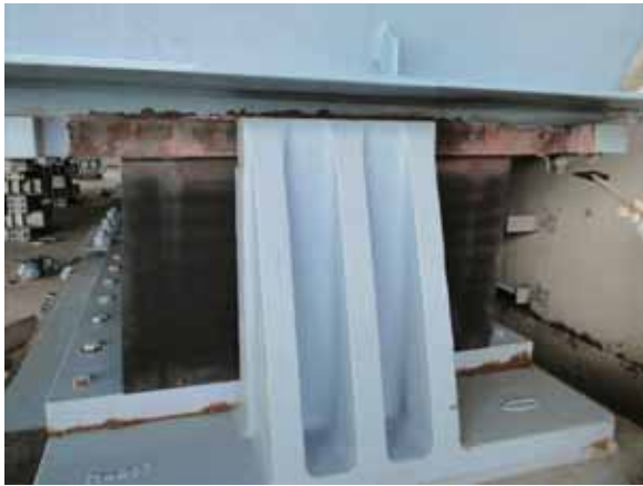
(a) 支承の状況(海側より)
