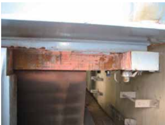
(a) 海側・P36 橋脚側の接触痕
