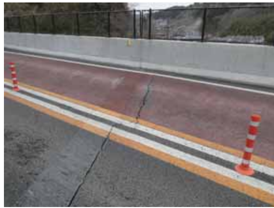
写真-2.1.1.4 A1橋台取付部の埋設ジョイント部の路面のひび割れ(幅15mm)
