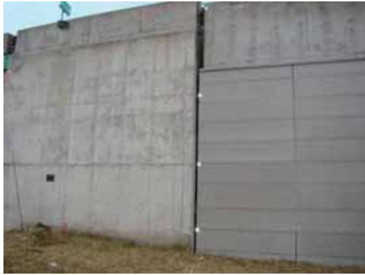
写真-2.1.3.2 A2 橋台と背面盛土の遊間及び沈下
