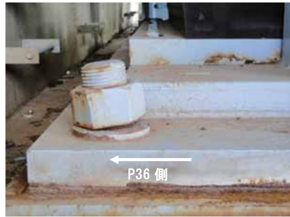
(b) P36 橋脚側より
