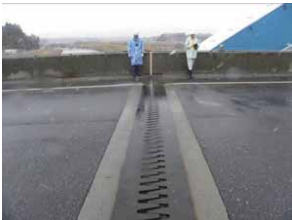
写真-2.1.4.6 P2 橋脚上の伸縮部 (下り線)
