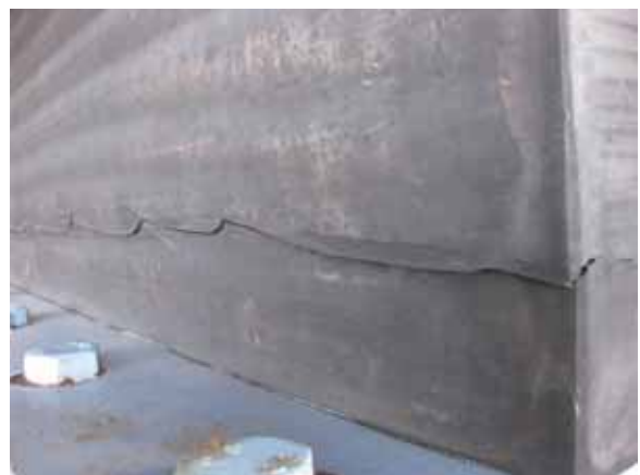
(b) 亀裂部拡大
