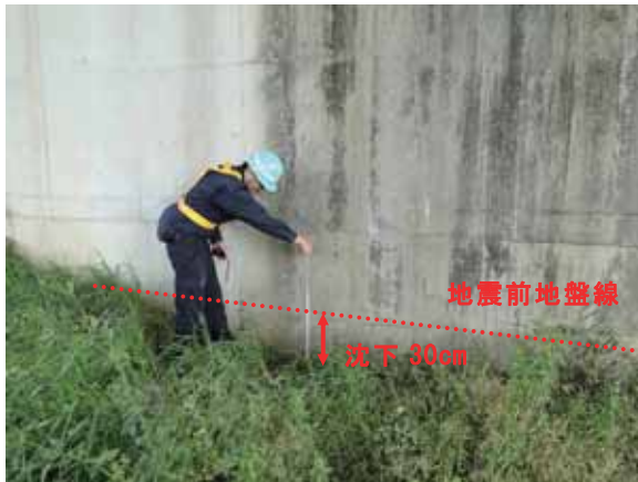
(a) P31 橋脚周辺の地盤沈下 (P30 橋脚側より)
