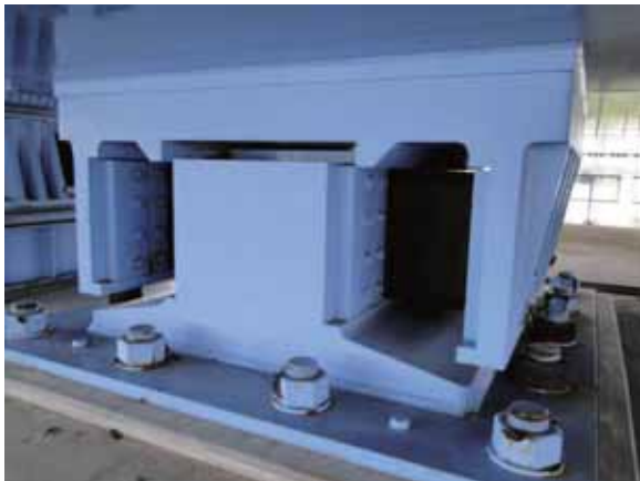
(a) 海側ウインド支承(S2 支承)
