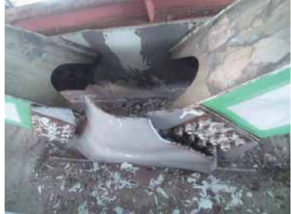
(a) 横支材－下横構間の取付部材(図中①) (b) 横支材－対傾構間の取付部材(図中②) 写真-2.7.1.2 湾754橋脚におけるトラス部材の損傷状況(資料提供：首都高速道路(株))
