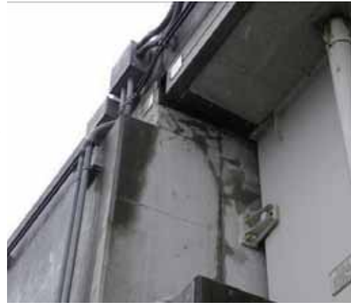
写真-2.1.4.4 A1 橋台と隣接桁の衝突による橋台パラペットのひび割れ(上り線側)
