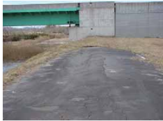
写真-2.1.3.3 A2 橋台付近の河川堤防
