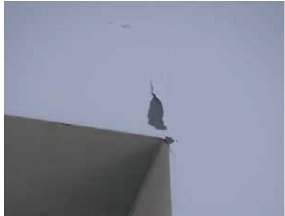
写真-2.2.1.19 P54橋脚山側隅角部の塗膜剥がれ
