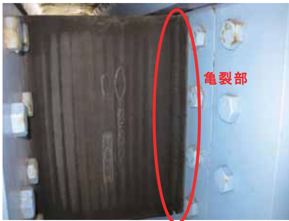
(a) 積層ゴムの亀裂部
