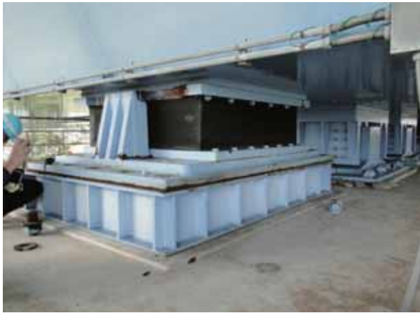
(a) 支承全景
