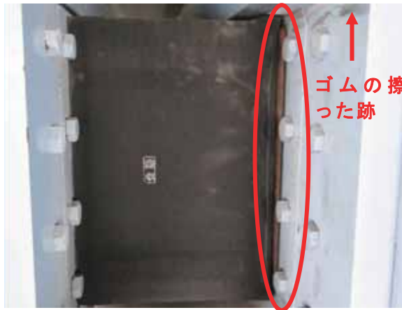
(a) P34 橋脚側より
