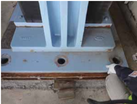
(a) 損傷の状況
