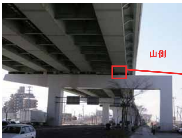
写真-2.2.1.5 P54橋脚(P55側より撮影)
