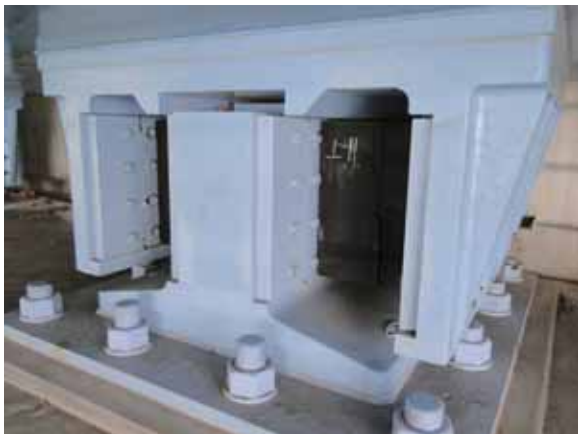
(a) 海側ウインド支承(S2支承)
