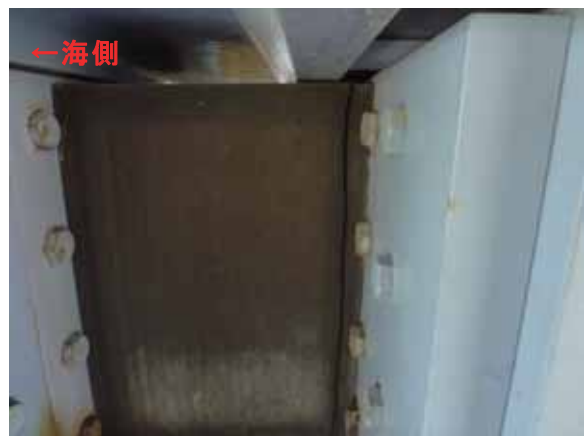
(b) 海側ゴムの亀裂部
