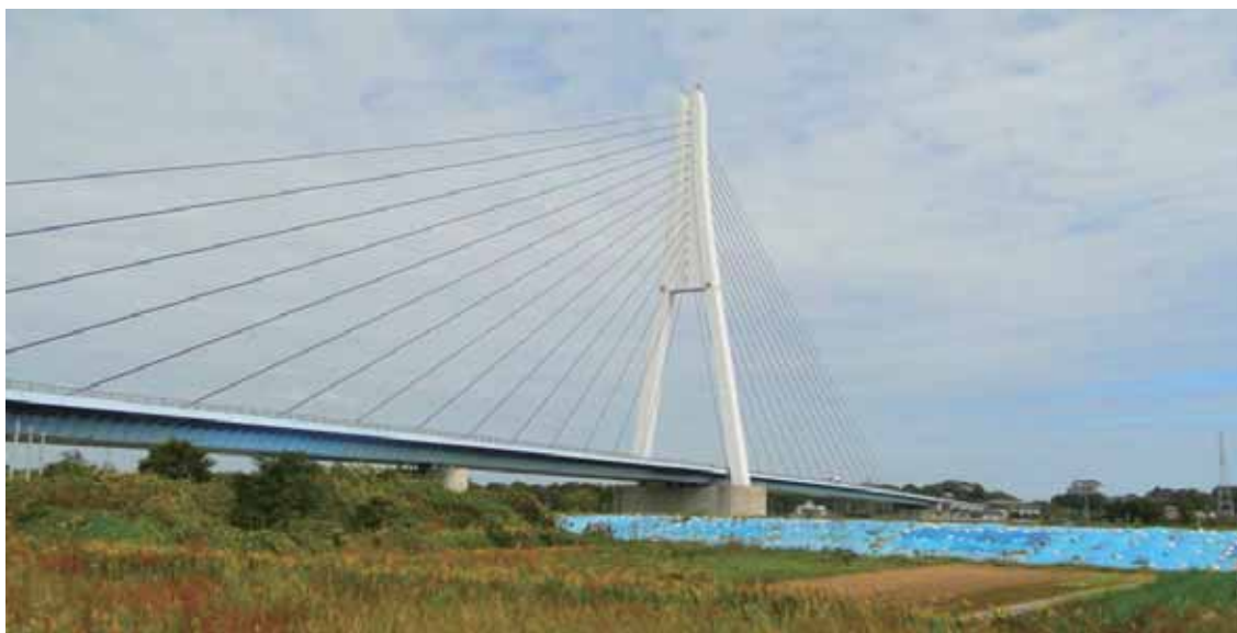
写真-2.6.1.1 新那珂川大橋(水戸市側-海側より撮影)
