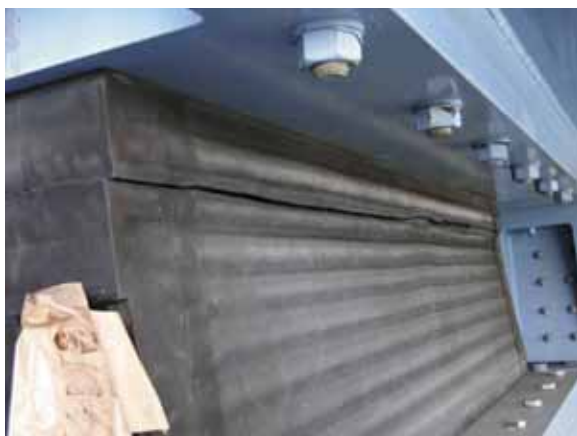
(a) P34 橋脚側より
