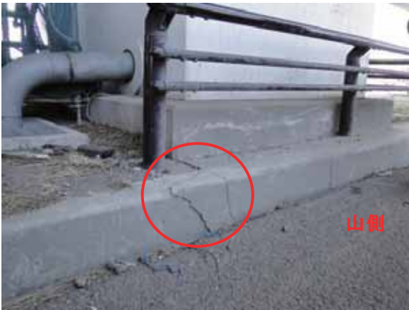
写真-2.2.1.20 P56の鋼製柱基部周辺 コンクリートのひび割れ
