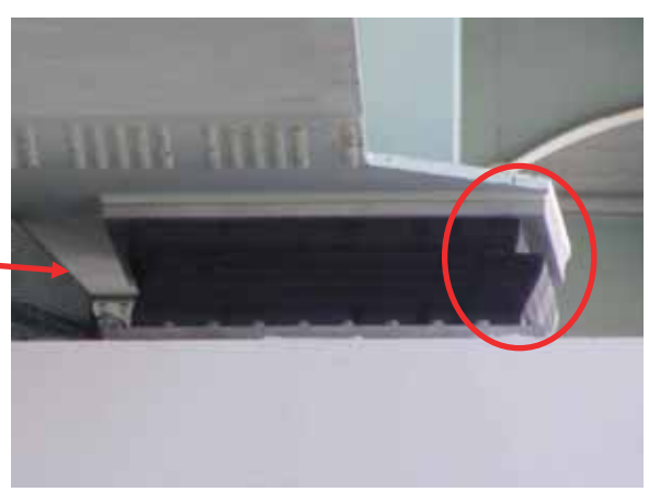
写真-2.2.1.6 P54橋脚S1支承(山側)が破断し、橋軸直角方向にズレ
