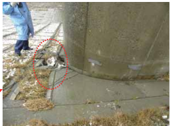
写真-2.1.4.5 P2 橋脚と周辺護岸の損傷の状況
