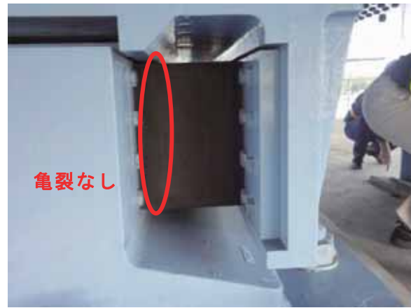
(b) P33 橋脚側より
