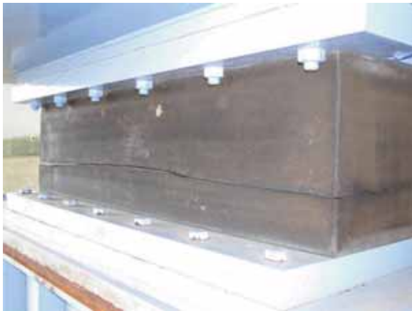
(a) 亀裂状況(斜め方向より)
