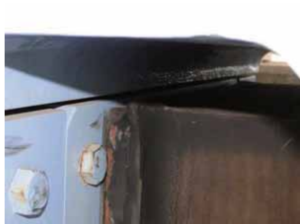
(b) 上面亀裂部拡大
