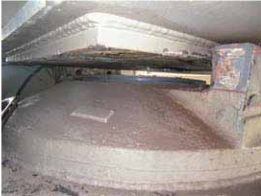
(a) 損傷した支承板支承
