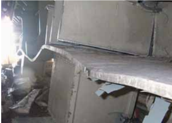
写真-2.7.2.3 大206橋脚上の桁端部の変形 (資料提供：首都高速道路(株))
