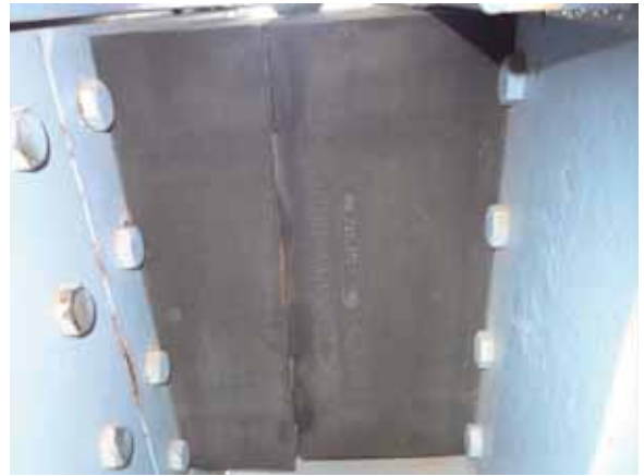
(b) P36 橋脚側より
