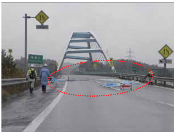
写真-2.1.4.2 A1 橋台取付部の状況 (下り線側)
