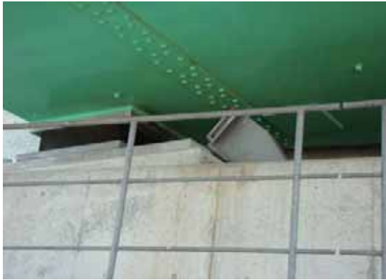
写真-2.1.3.4 P1 橋脚のジョイントプロテクターの損傷
