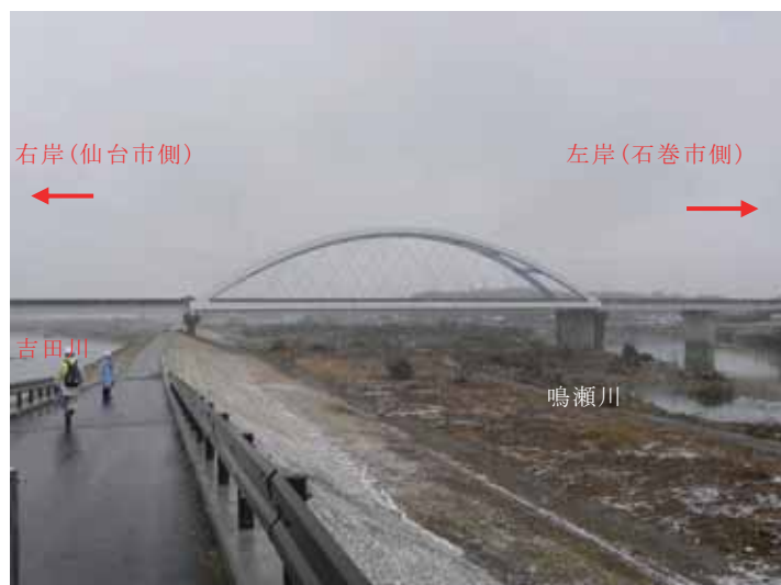
写真-2.1.4.1 鳴瀬奥松島大橋(下流側より)
