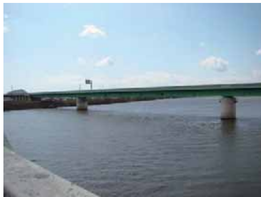
写真-2.1.3.1 新天王橋
