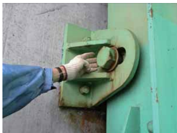
写真-2.1.5.5 A2 橋台と桁を連結する桁間連結装置のボルトの緩み
