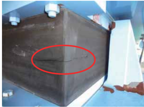
(b) ゴムの亀裂
