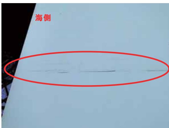
写真-2.2.1.16 P52橋脚中間部(海側)の塗膜割れ
