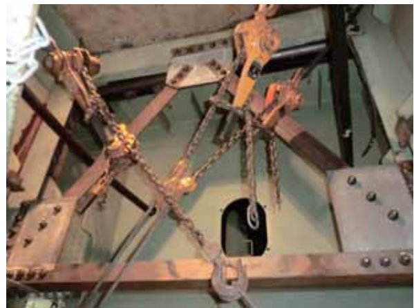
写真-2.2.1.15 対傾構の復旧状況(2011年6月撮影)
