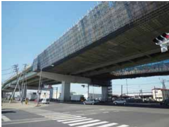
写真-2.2.1.1 P56側から見たP55橋脚等の状況
