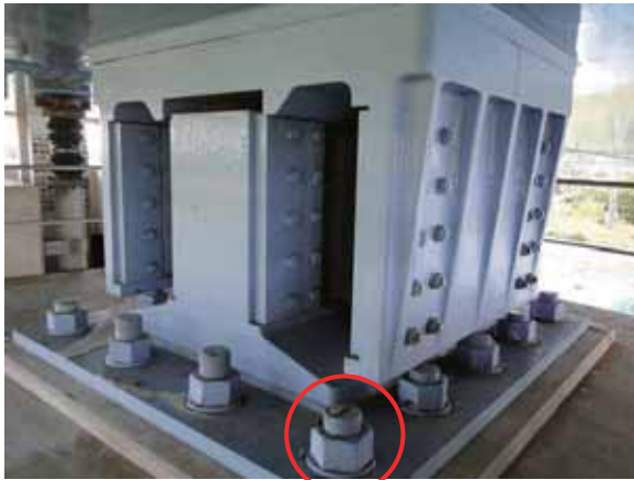
(a) ウインド支承下側ボルトの擦過痕
