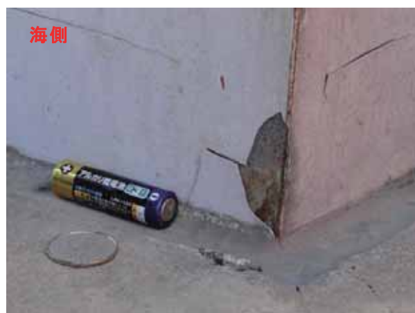
写真-2.2.1.17 P52橋脚の海側基部の塗膜剥がれ
