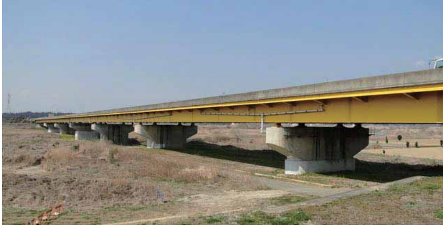
写真-2.4.1.1 那珂川橋
