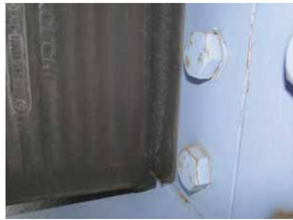
(b) 亀裂部拡大
