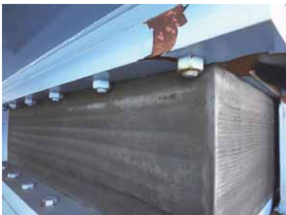
(a) 亀裂の状況
