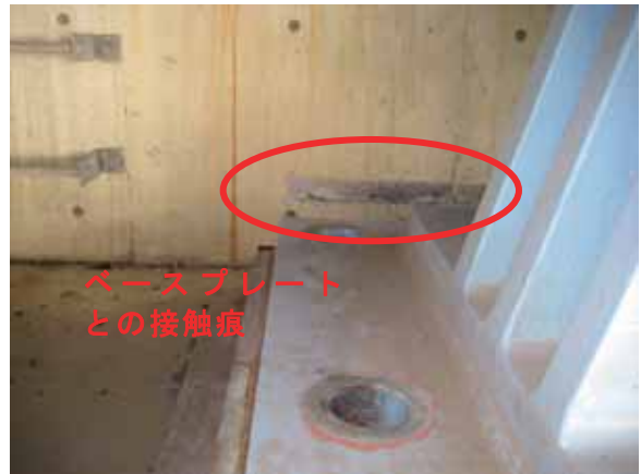
(b) ベースプレートの接触痕
