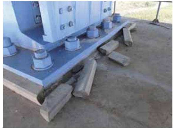
(b) 杓座モルタルの損傷
