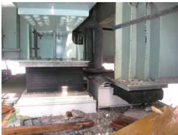
写真-2.2.1.3 P56橋脚上のゴム支承の破断(写真提供：東日本高速道路(株))
