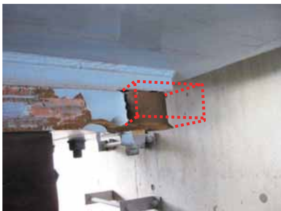
(a) ツメ部が破断した上沓部
