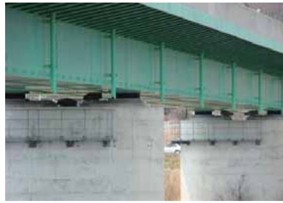
写真-2.1.3.5 P2 橋脚のジョイントプロテクターの損傷
