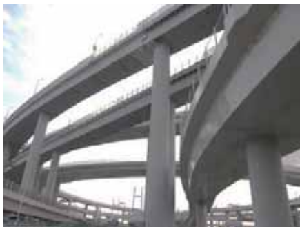
写真-2.7.2.1 大黒JCT連結路の橋(資料提供：首都高速道路(株))
