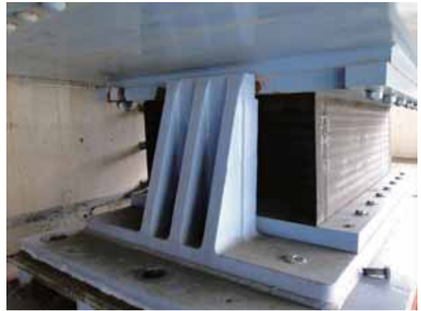
(b) 支承の状況(山側より)
