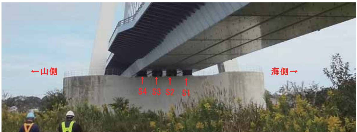
写真-2.6.1.13 P34(主塔部)橋脚(P33橋脚側より)
