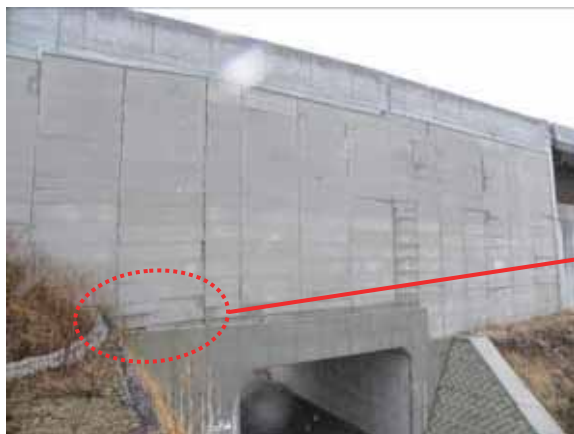
写真-2.1.2.4 橋台取付部の化粧板の目地ずれ
