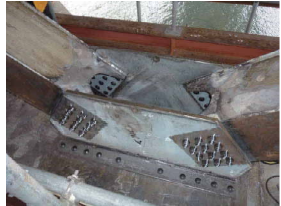
(a) 横支材－下横構間の取付部材(図中①) (b) 横支材－対傾構間の取付部材(図中②) 写真-2.7.1.3 湾754橋脚におけるトラス部材の復旧状況(資料提供：首都高速道路(株))
