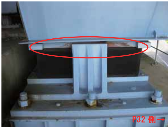
(a) サイドブロックとの接触痕 海側
