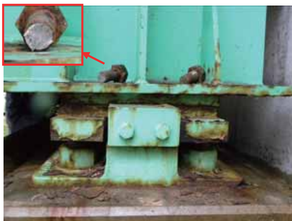
写真-2.1.5.2 A2 橋台支承部のセットボルト破断とボルト破断面
