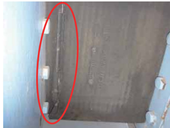
(b) P36 橋脚側より
