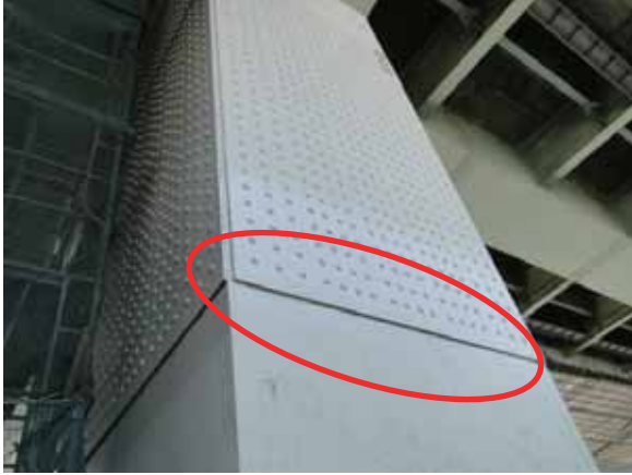
写真-2.2.1.18 P56鋼製柱山側の塗膜割れ
