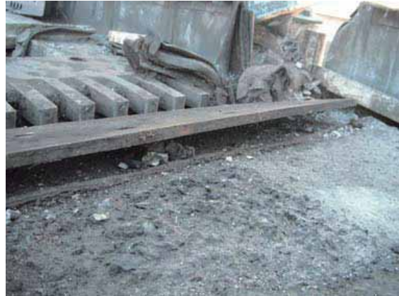
写真-2.7.2.4 大206橋脚上の路面段差 (資料提供：首都高速道路(株))
