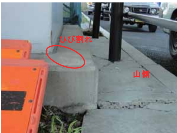
写真-2.2.1.22 P52橋脚の山側の基部： 根巻きコンクリートと周辺コンクリート にひび割れ
