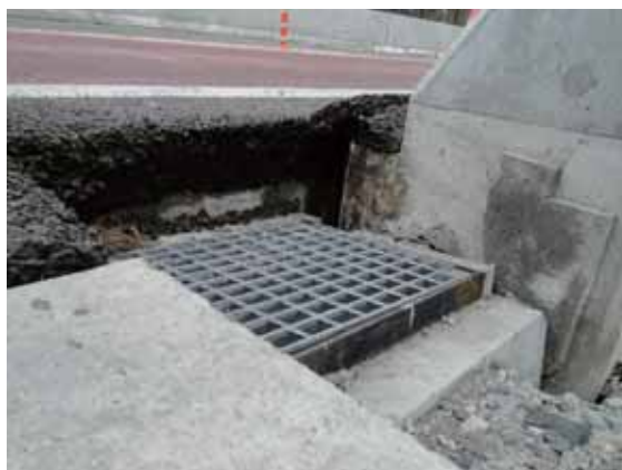
(a) 排水ますの沈下
