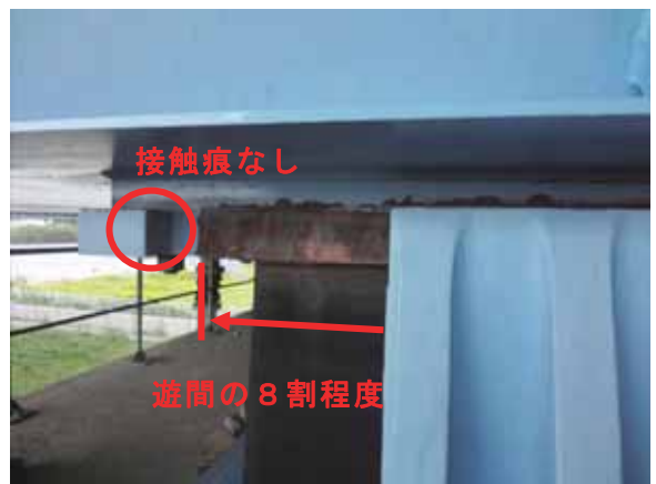
(b) 海側・P34 橋脚側の接触痕
