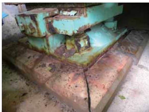
写真-2.1.5.4 沓座モルタルの損傷
