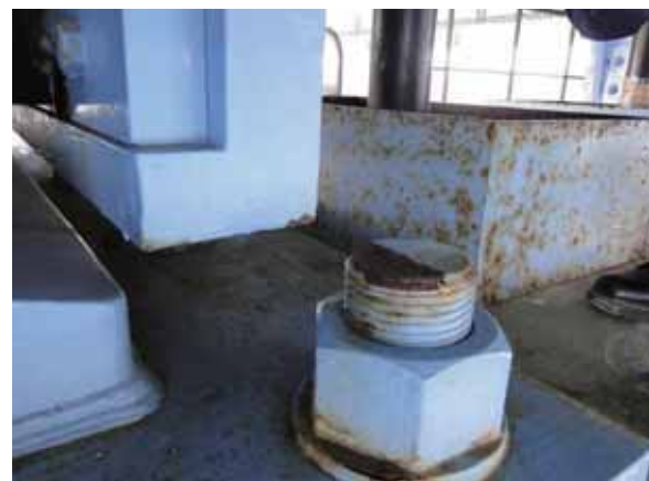
(b) 下側ボルトの接触痕
