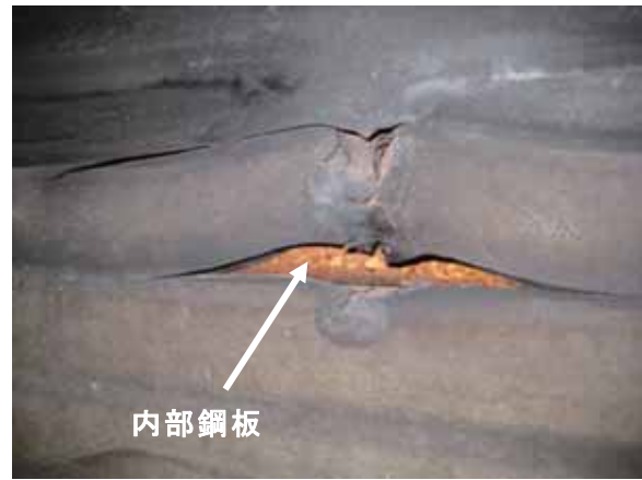
(b) 亀裂部拡大
