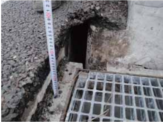
写真-2.1.1.3 A1橋台の間詰舗装部の空洞
