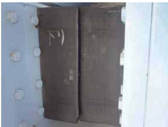
(a) P34 橋脚側より
