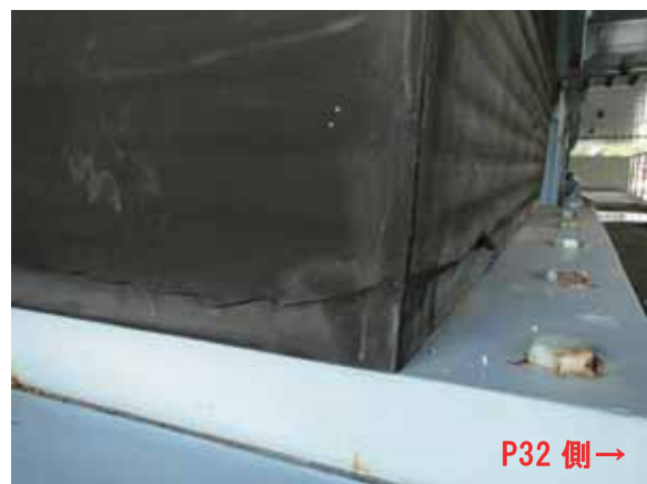
(b) 亀裂部拡大
