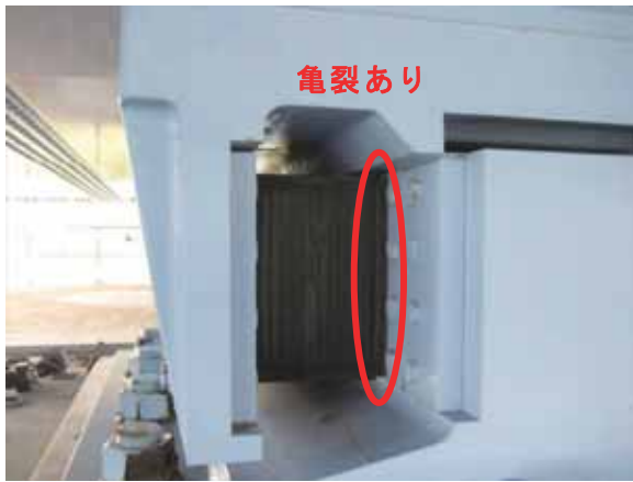
(a) P35 橋脚側より
