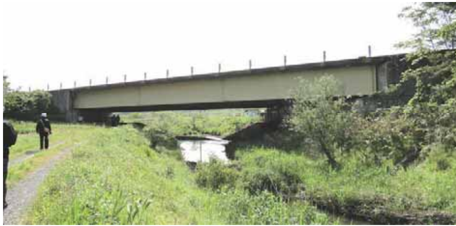
写真-2.5.1.1 築館荒川橋
