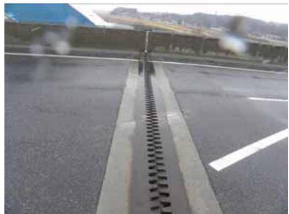
写真-2.1.4.7 P3 橋脚上フィンガージョ イントの目開き(下り線)
