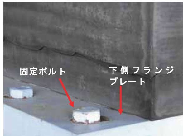
(b) 固定ボルトの塗膜割れ
