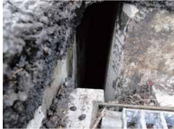
写真-2.1.1.3 A1橋台の間詰舗装部の空洞
