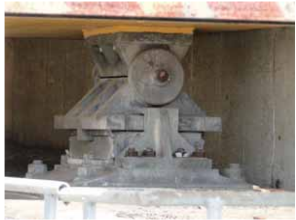
写真-2.4.1.2 那珂川橋の福島側の橋台とその支承
