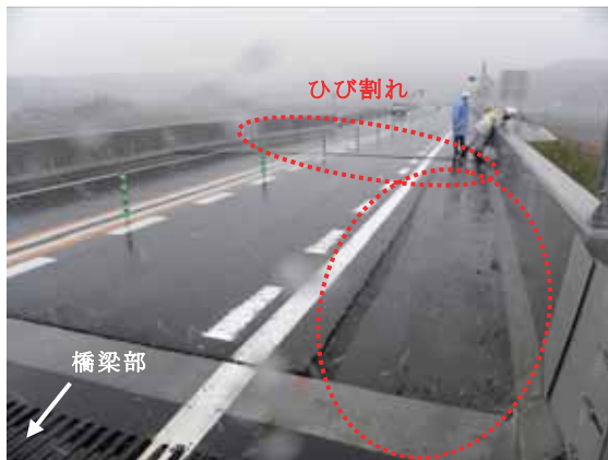
写真-2.1.2.2 A2 橋台背面路肩の沈下
