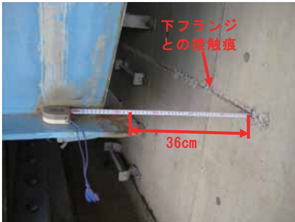
(a) 桁遊間と下フランジの接触痕
