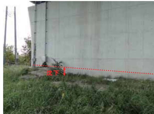
(b) P32 橋脚周辺地盤 (P33 橋脚側より)
