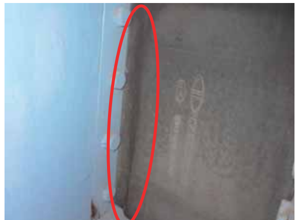
(b) P36 橋脚側より
