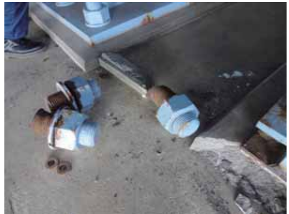
(b) 破断したアンカーボルト
