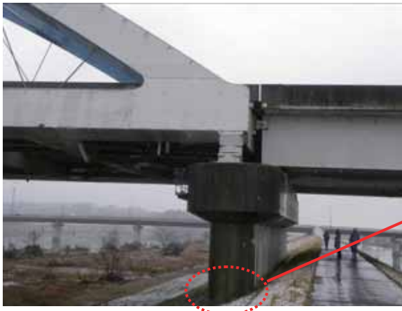
写真-2.1.4.5 P2 橋脚と周辺護岸の損傷の状況
