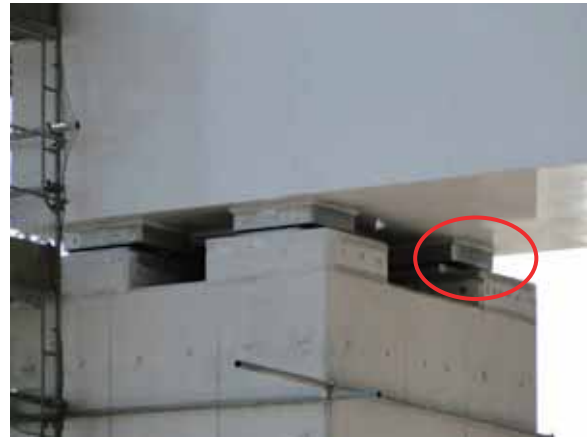
写真-2.2.1.8 写真-2.2.1.5のトラックの位置付近から見たP56橋脚のRC柱頭部
