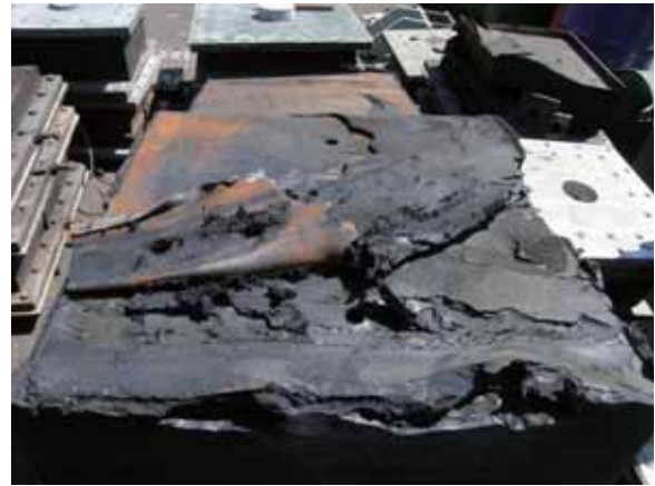
写真-2.2.1.10 ゴム支承の破断状況 (主としてゴム本体部で破断)
