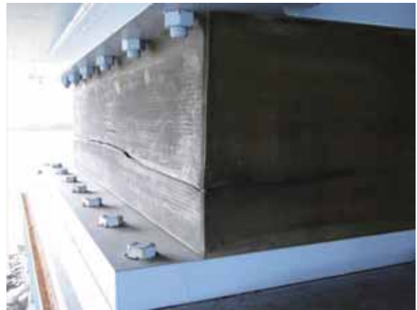
(b) 亀裂状況(横方向より)
