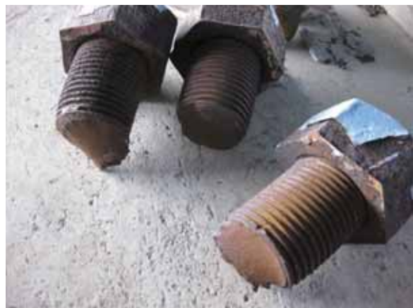
(b) 破断したアンカーボルト
