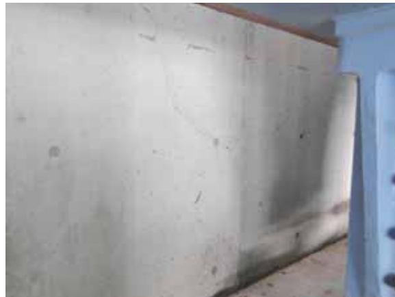
写真-2.6.1.46 コンクリート壁のクラック
