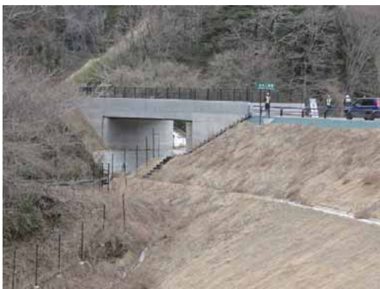
写真-2.1.1.1 金浜跨線橋
