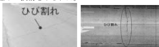
(a) 現地調査結果 (b) 路面性状測定車画像データ
