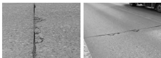
(a-1) 現地(角欠け) (a-2) 現地(わだち掘れ、ポリッシング)
