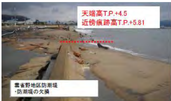
写真-2.1 防潮壁の被災事例（石巻港雲雀野）
