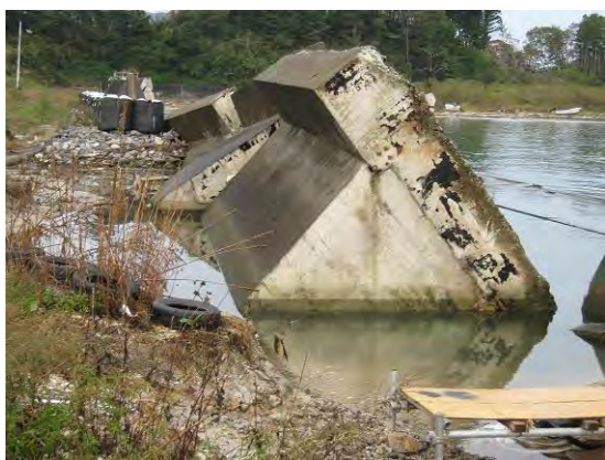
写真-2.2 防潮壁の被災事例（山田漁港）
