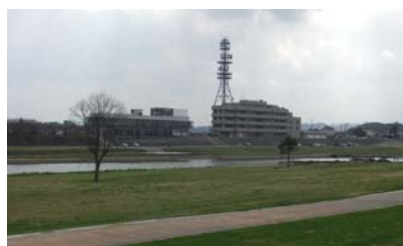
写真-2.13 遠賀川水辺館
