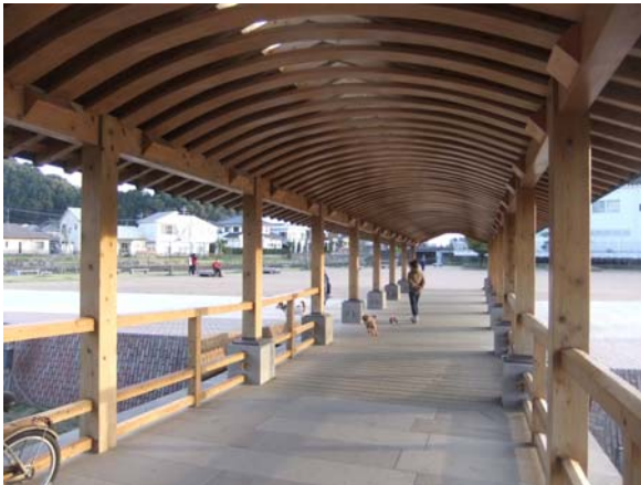
写真-2.15 地場材の飫肥杉を用い伝統的の木橋工法で整備された夢見橋
