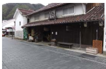
写真-参. 7 御影石の乾式工法により整備された街路
