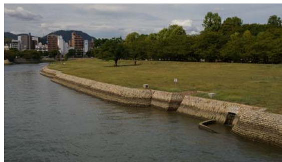
写真-参. 16 基町護岸（空鞆橋の上流区間）
