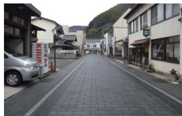
写真-参. 7 御影石の乾式工法により整備された街路
