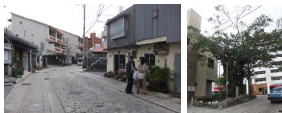
写真-参. 3 琉球石灰岩を用いた石畳舗装(左)とガジュマルの保全(右)
