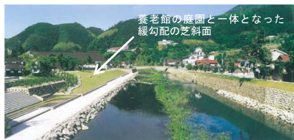
写真-参. 22 整備後の状況
