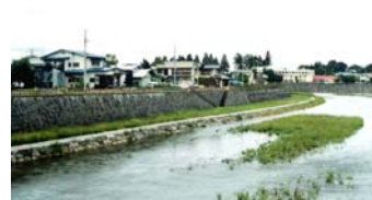
写真-参. 27 護岸の漸次的変化
