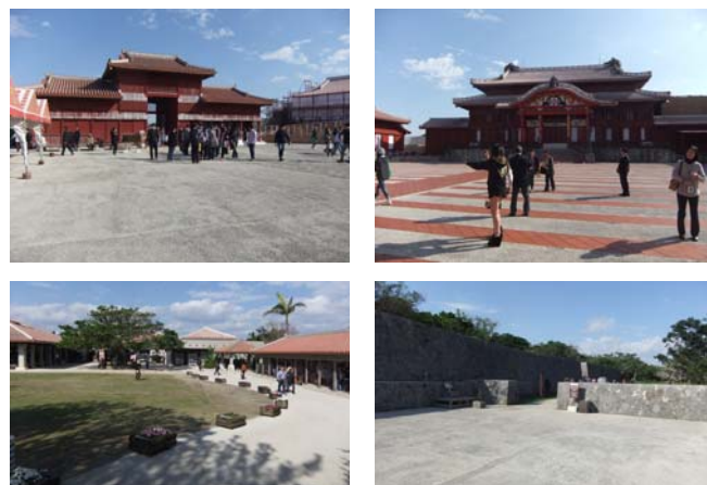
写真-参. 29 復元整備後の状況
