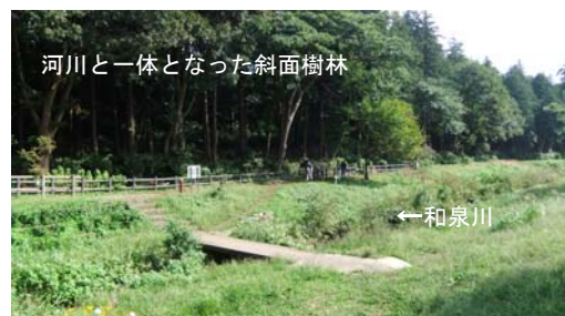
写真-参.23 整備後の状況
