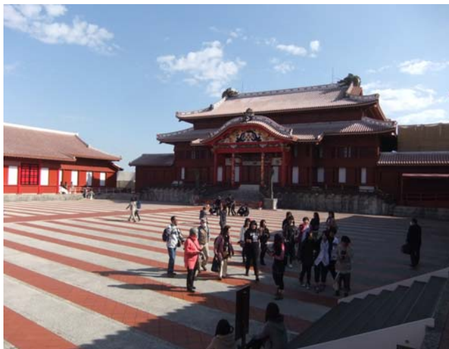
写真-2. 24 首里城公園の復元整備
