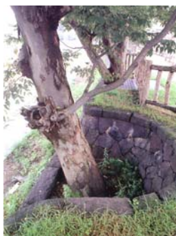
写真-2. 23 横手川の河川改修で残された樹木（右）と保護工法（左）
