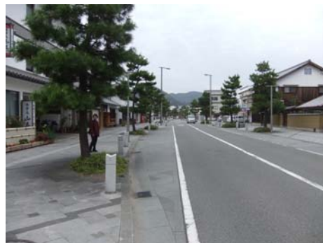
写真-参. 11 お城通りの整備後の状況
