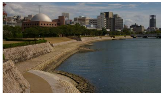
写真-参. 17 基町護岸（空鞆橋の下流区間）
